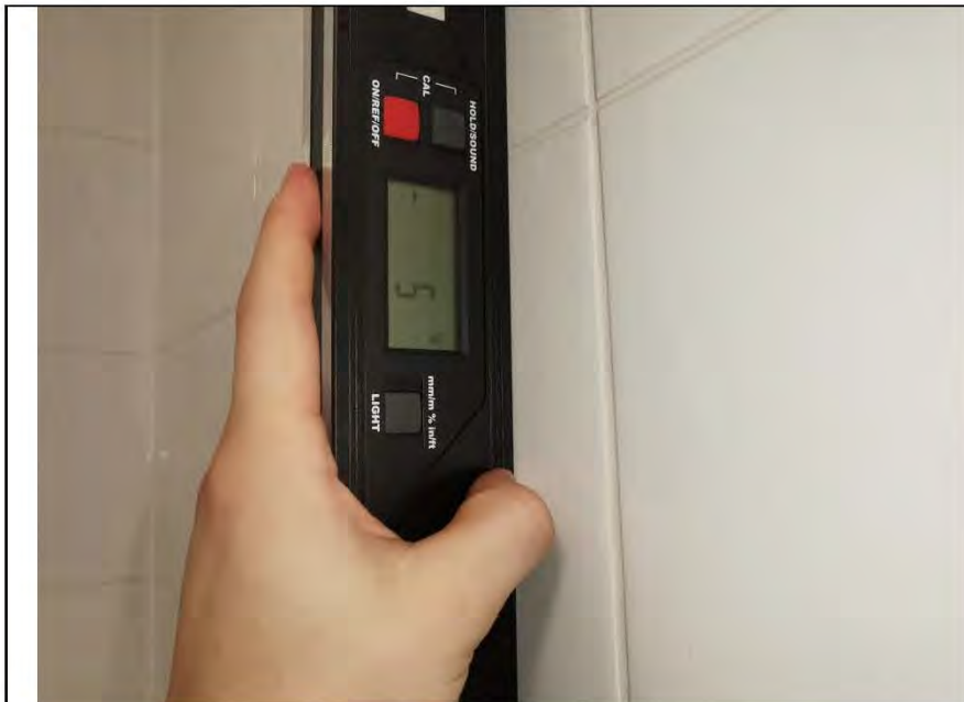
Фото №16. Измерение уровня стен в ванной комнате.
