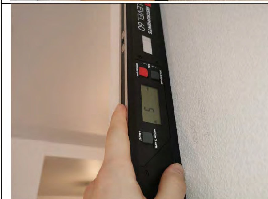
Фото №8. Измерение уровня стен в кухне.
