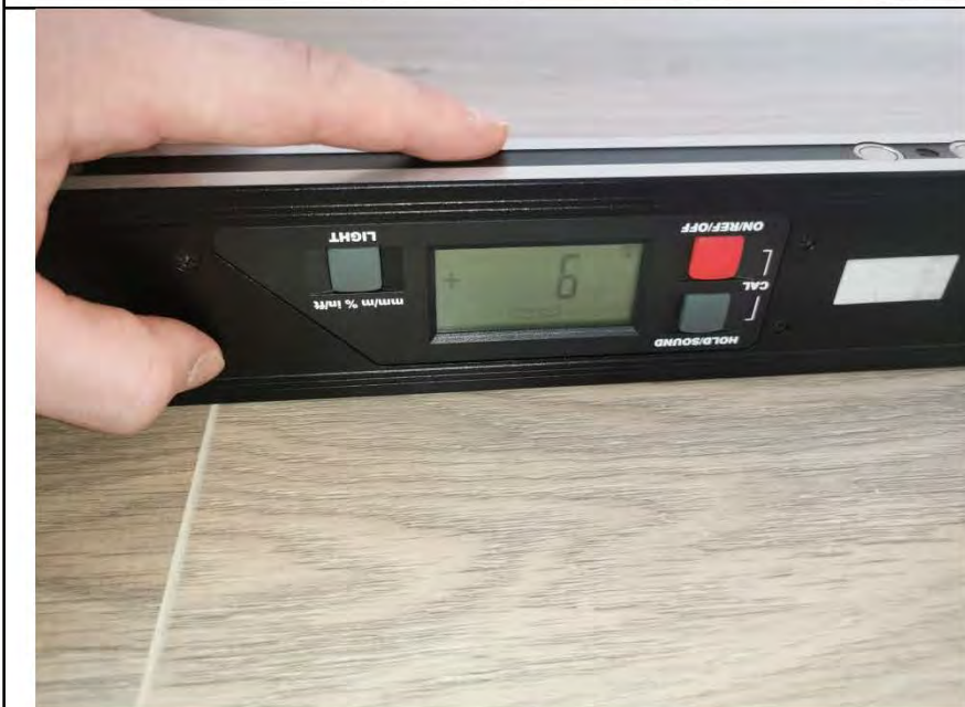
Фото №20. Измерение уровня пола в кухне.
