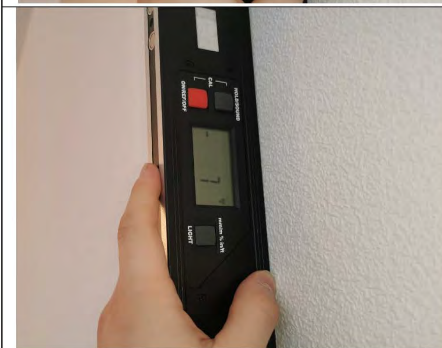
Фото №9. Измерение уровня стен в спальне.
