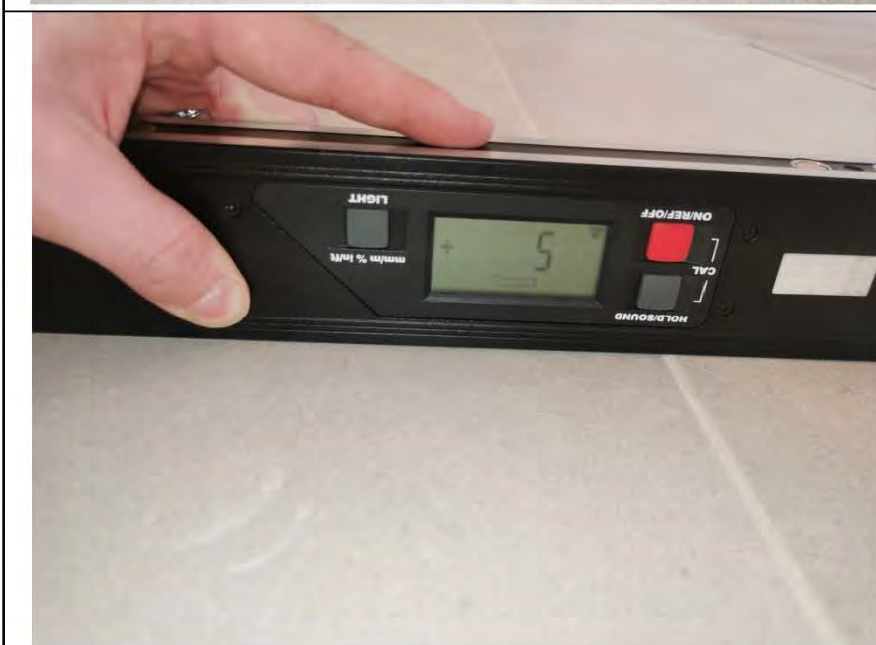
Фото №27. Измерение уровня пола в кухне.
