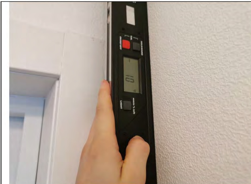
Фото №7. Измерение уровня стен в коридоре.
