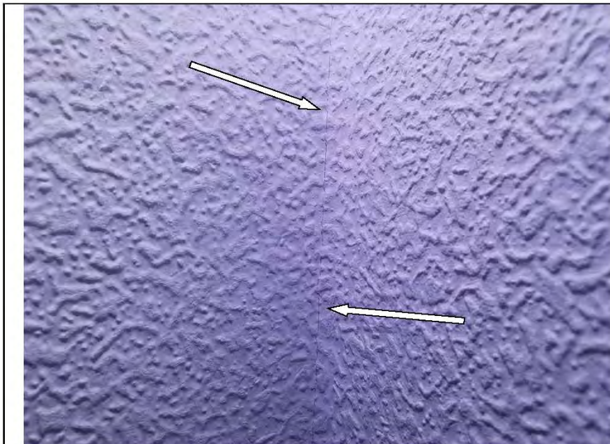
Фото №10. Читаемые обойные стыки в коридоре.
