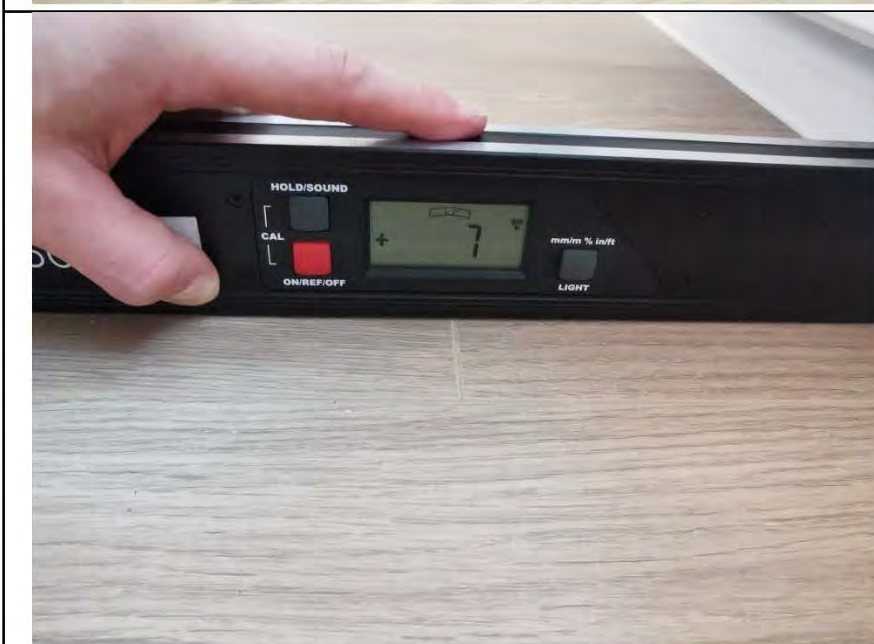
Фото №21. Измерение уровня пола в спальне.
