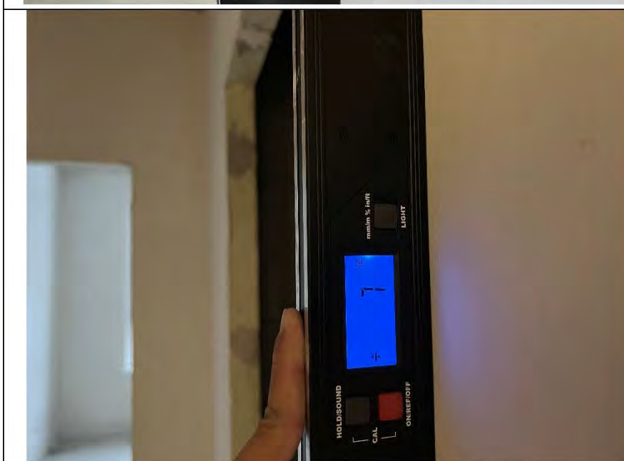
Фото №9. Измерение уровня стен в коридоре.
