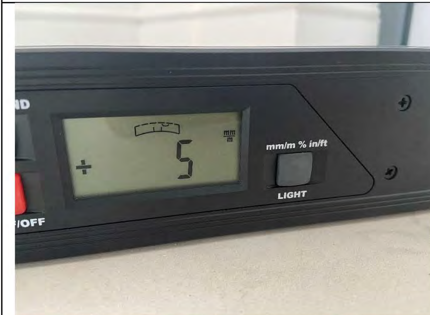
Фото №26. Отклонения напольного покрытия из керамической плитки в коридоре.
