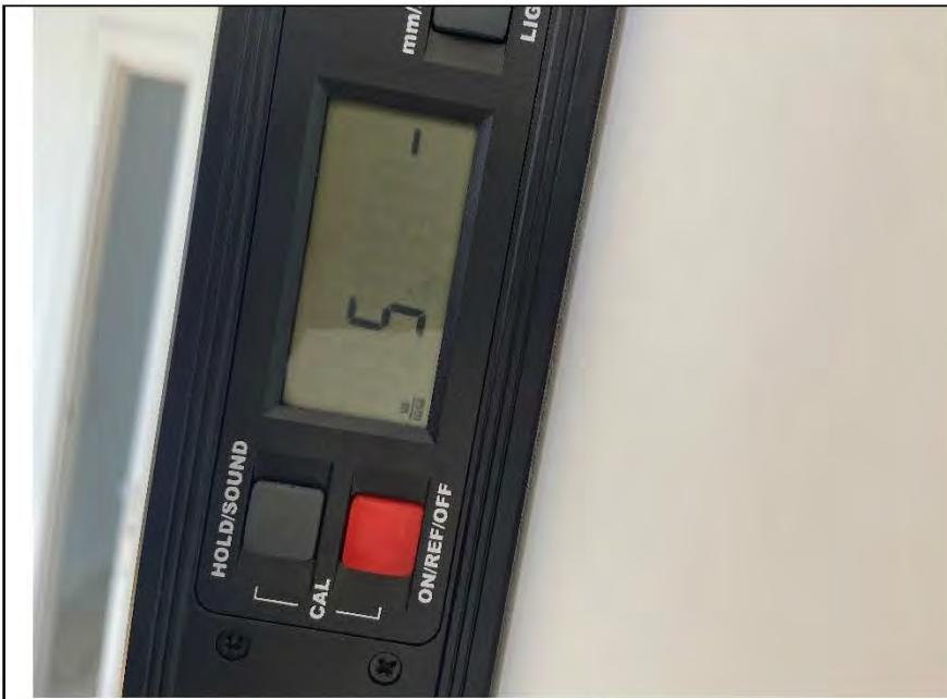
Фото №13. Измерение уровня стен в кабинете.
