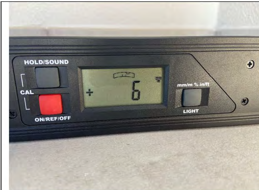
Фото №28. Отклонения напольного покрытия из керамической плитки на лоджии.
