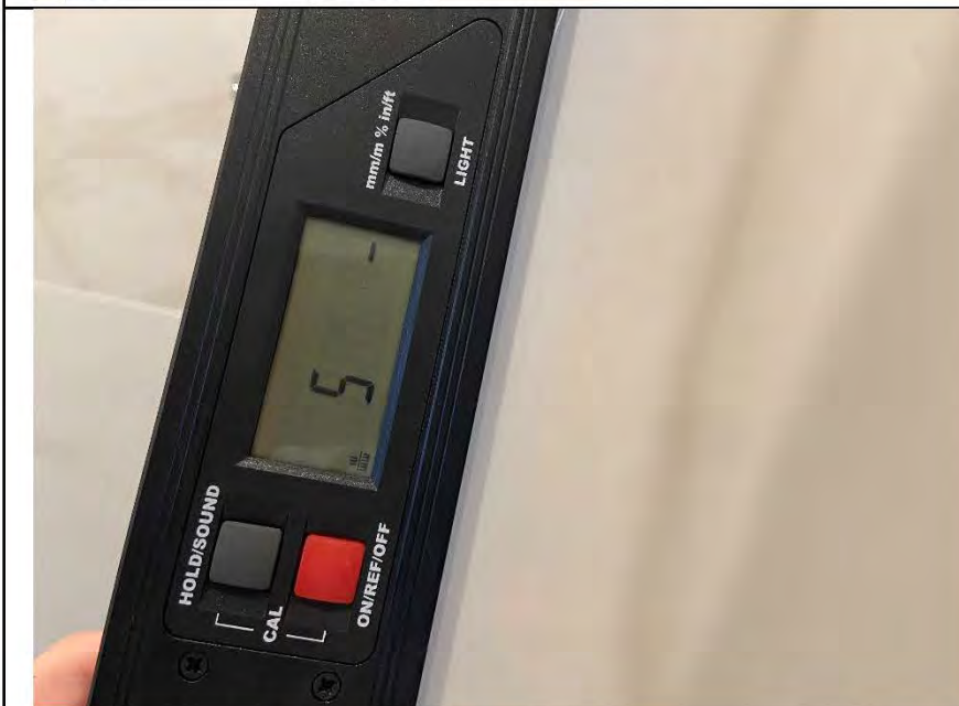
Фото №17. Измерение уровня стен в санузле.
