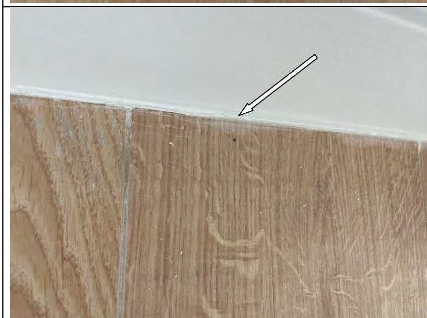
Фото №57. Загрязнения на напольном покрытии из ламината в детской.
