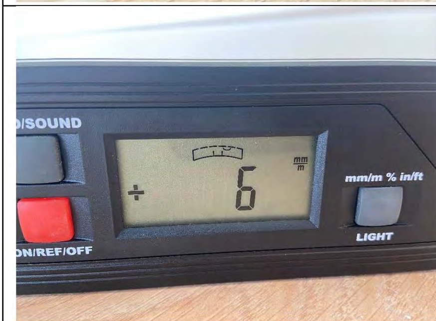
Фото №33. Отклонения напольного покрытия из ламината в кабинете.
