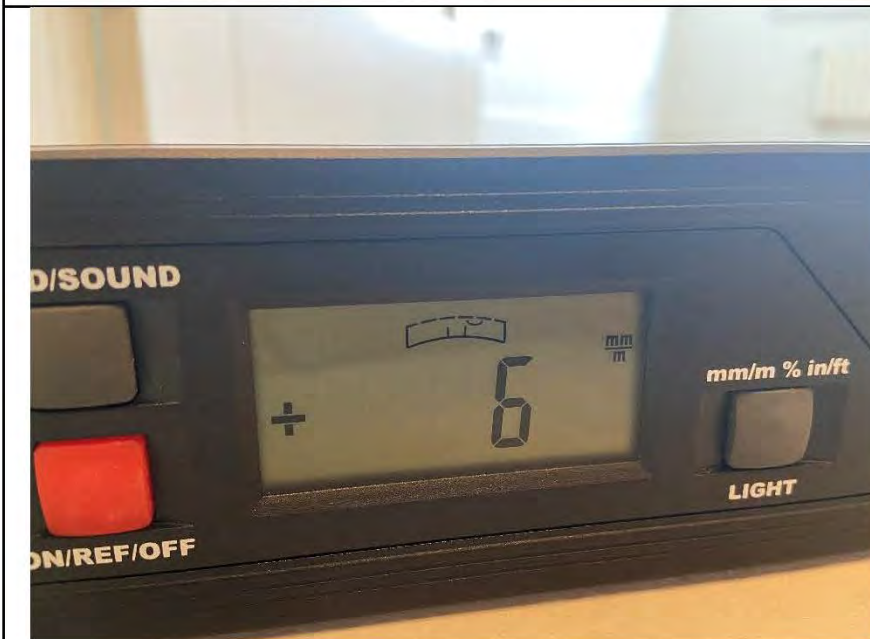
Фото №27. Отклонения напольного покрытия из керамической плитки в санузле.
