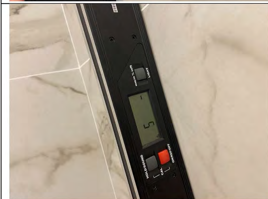
Фото №18. Измерение уровня стен в ванной комнате.
