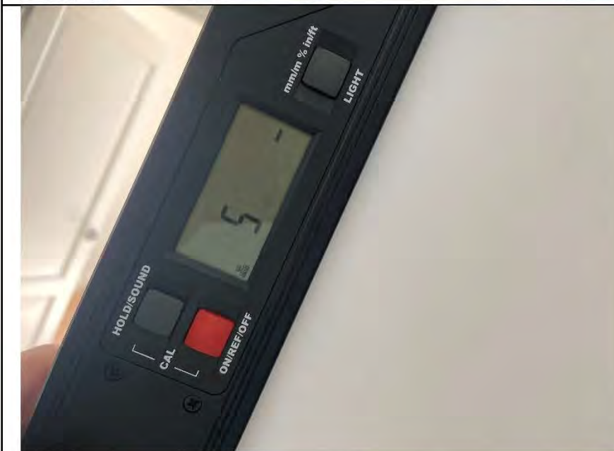
Фото №11. Измерение уровня стен в коридоре.
