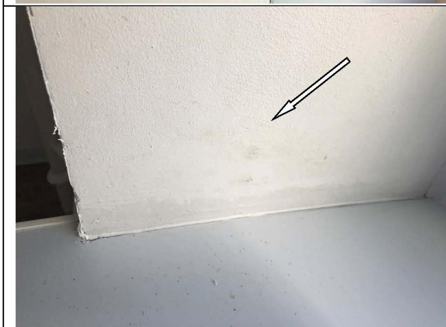
Фото №21. Дефект окрашенного откоса оконного блока ПВХ кухни в квартире (неровности, загрязнения).
