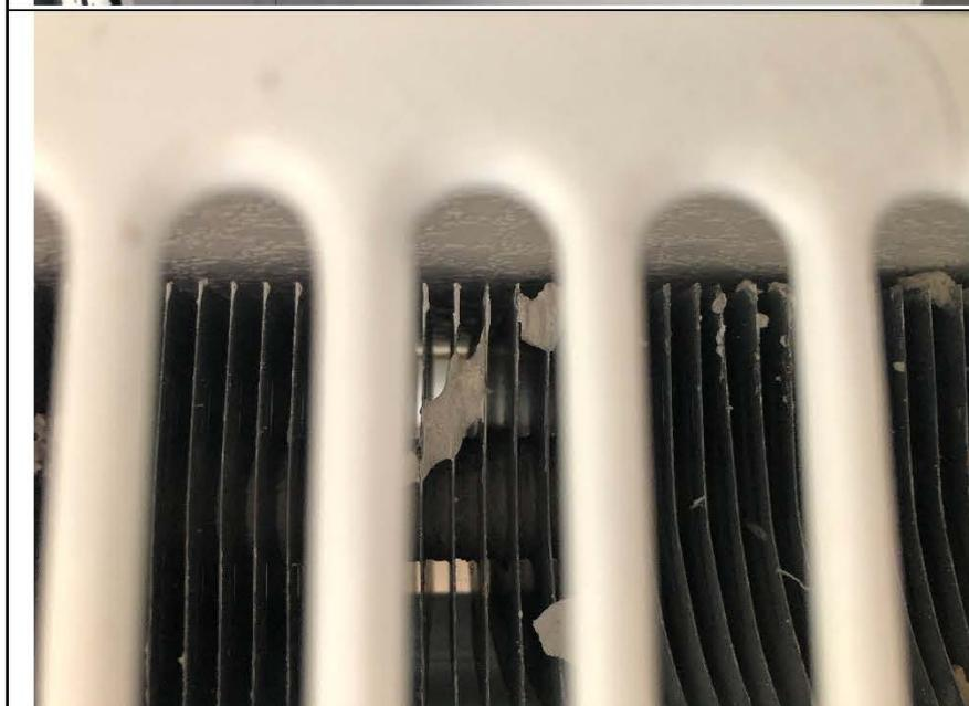
Фото №23. Дефект радиатора отопления кухни в квартире (загрязнен).
