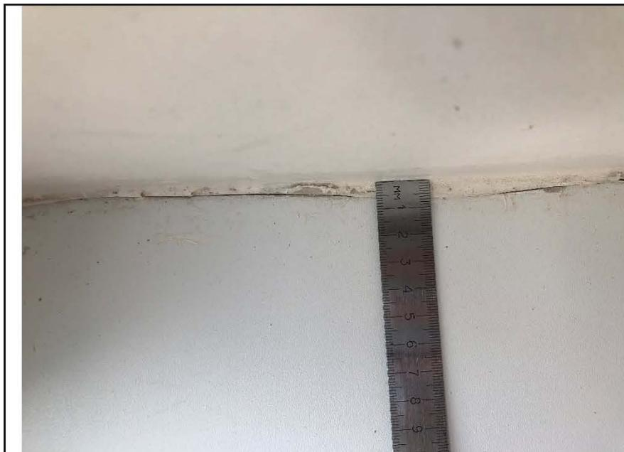
Фото №43. Дефект монтажа оконного блока спальни в квартире.
