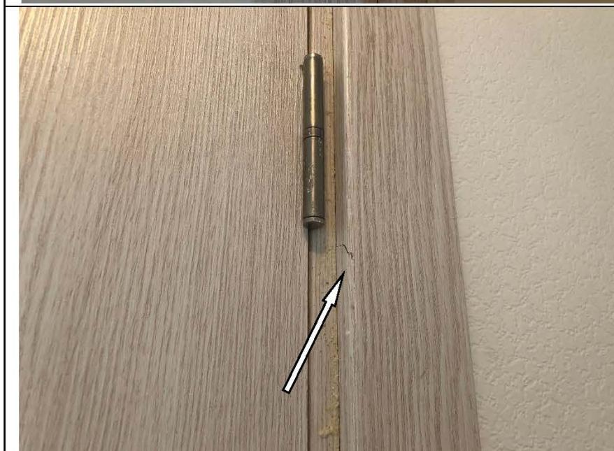
Фото №38. Дефект наличника дверного блока ванной комнаты в квартире (трещина).
