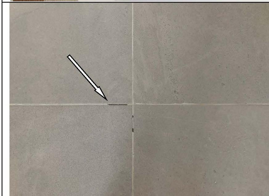
Фото №32. Дефект шва напольной плитки кухни в квартире.
