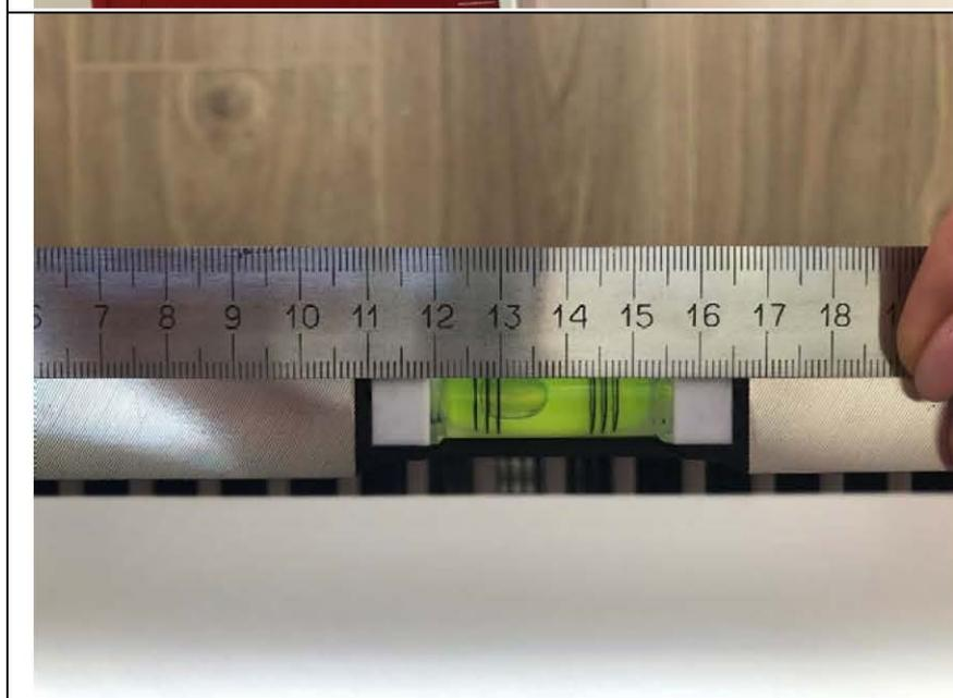
Фото №15. Неровно смонтирован радиатор отопления спальни в квартире.
