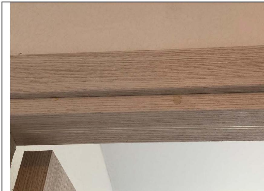
Фото №31. Дефект наличника дверного блока спальни в квартире (загрязнен).
