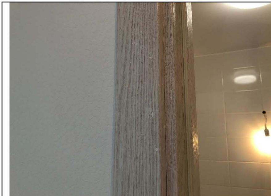
Фото №37. Дефект наличника дверного блока ванной комнаты в квартире (загрязнен).
