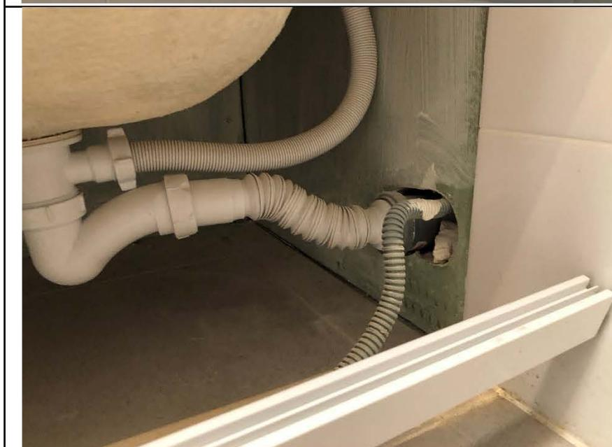
Фото №41. Частично отсутствует настенная керамическая плитка в ванной комнате.
