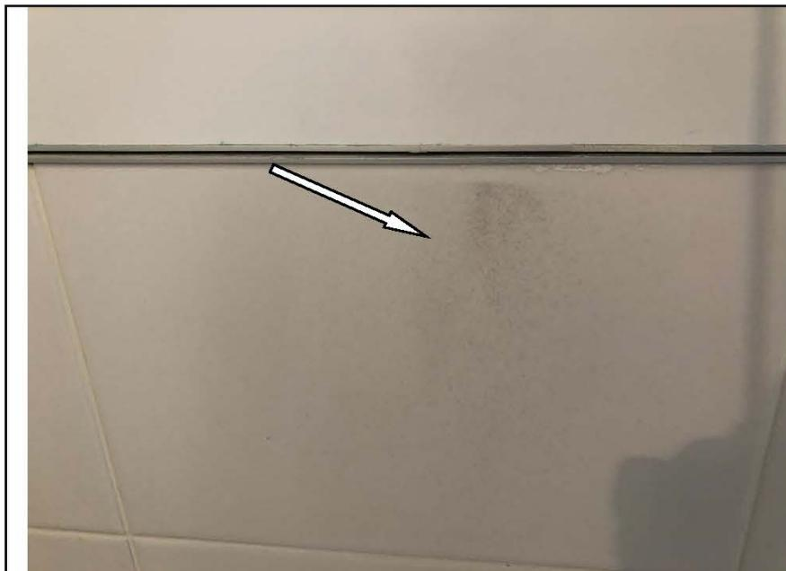
Фото №40. Дефект настенной плитки ванной комнаты в квартире (загрязнение).
