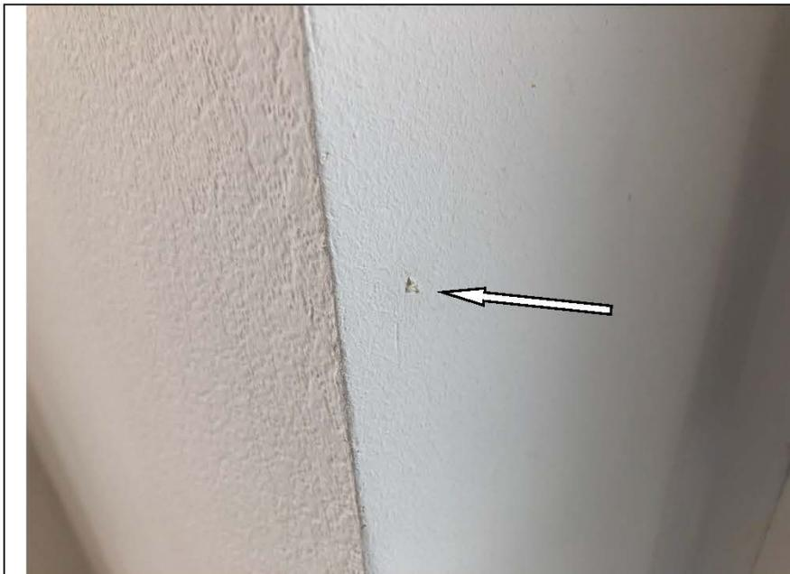
Фото №40. Неровности, сколы на окрашенных откосах оконного блока в гостиной в квартире.
