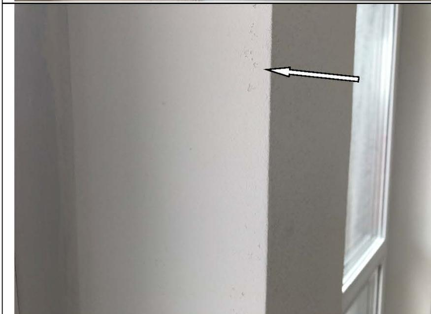
Фото №41. Неровности, сколы на окрашенных откосах оконного блока в кухне в квартире.
