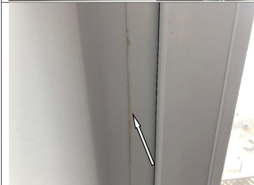
Фото №42. Дефект (загрязнение) на профиле оконного блока ПВХ в спальне в квартире.
