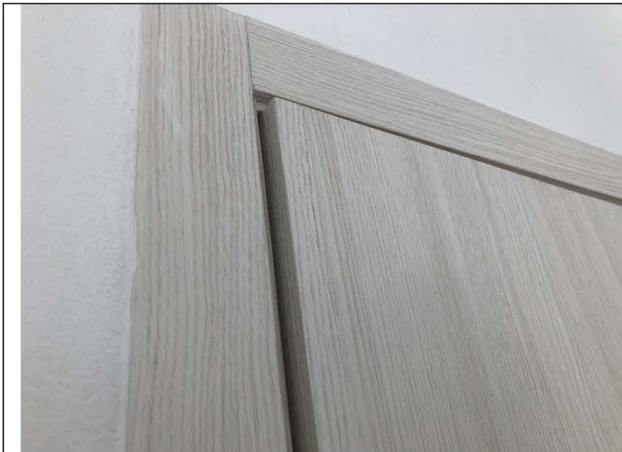
Фото №49. Дверной блок не обеспечивает безотказного открывания/закрывания двери в спальне.
