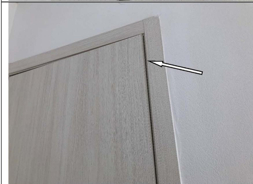
Фото №50. Дверной блок не обеспечивает безотказного открывания/закрывания двери в спальне.
