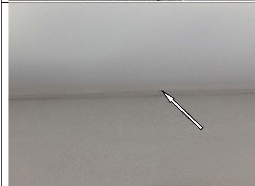
Фото №51. Загрязнение полотна натяжного потолка в спальне.
