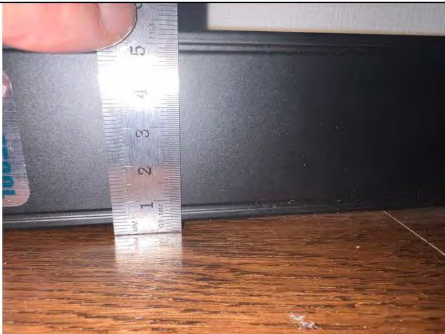
Фото №21. Неровности поверхности пола в кухне-гостиной
