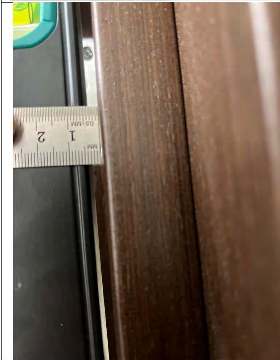
Фото №44. Отклонения прямолинейности дверного блока спальни.
