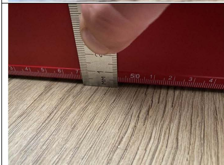
Фото №30. Измерение устройства напольного покрытия из ламината в кухне в квартире.
