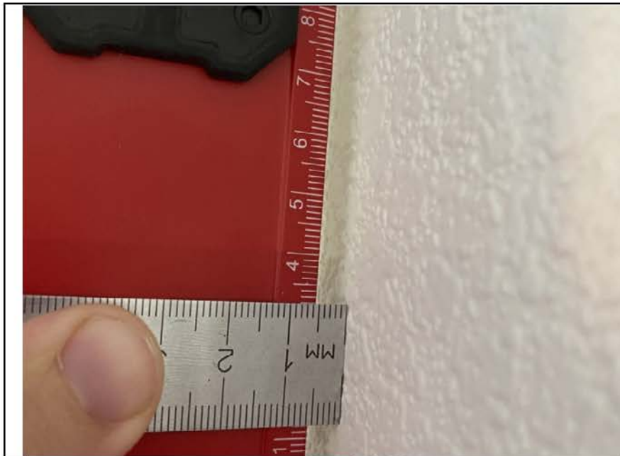
Фото №10. Измерение стены кухни в квартире.
