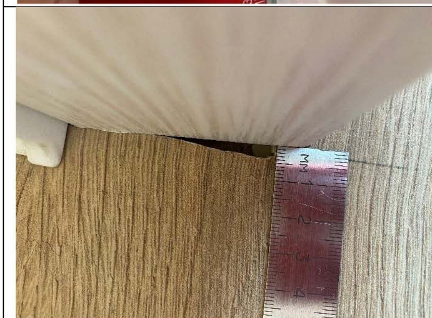
Фото №33. Измерение отсутствующей части ламината в холле в квартире.
