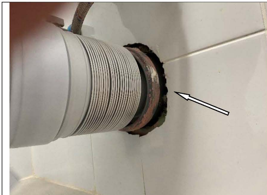
Фото №37. Отбитости настенной керамической плитки стен в санузле в квартире.
