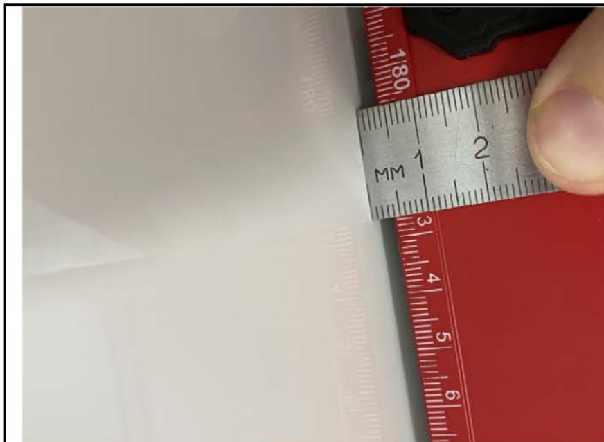
Фото №31. Измерение устройства настенного покрытия из керамической плитки в санузле в квартире.
