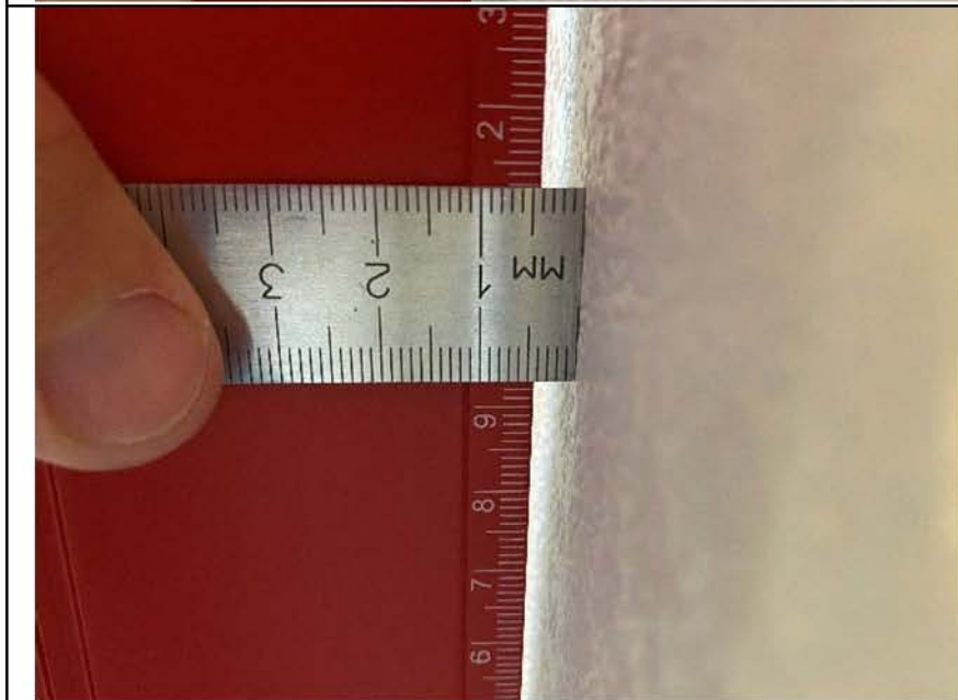
Фото №11. Измерение стены детской в квартире.
