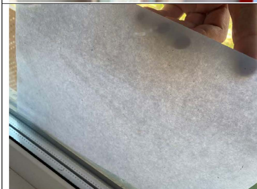
Фото №41. Окарины на стеклопакете оконного блока ПВХ в гостиной в квартире.
