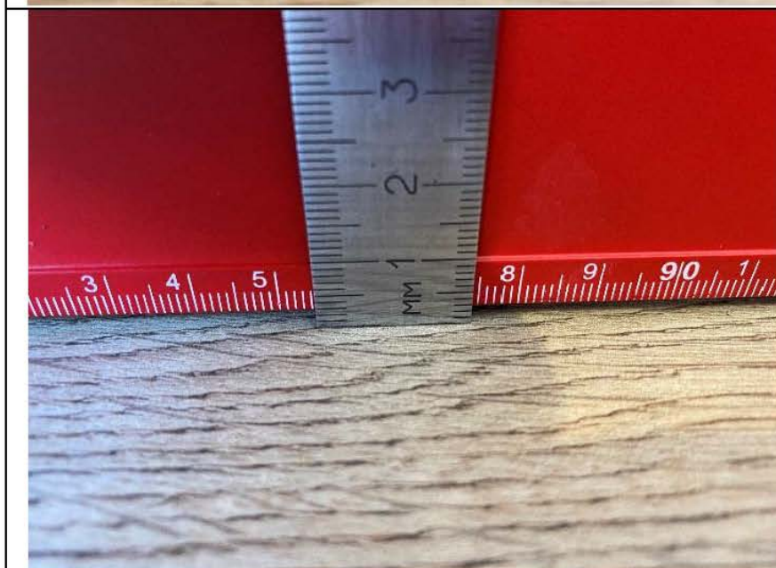
Фото №29. Измерение устройства напольного покрытия из ламината в детской в квартире.
