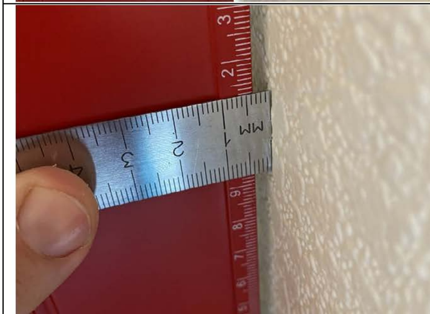
Фото №12. Измерение стены гостиной в квартире.
