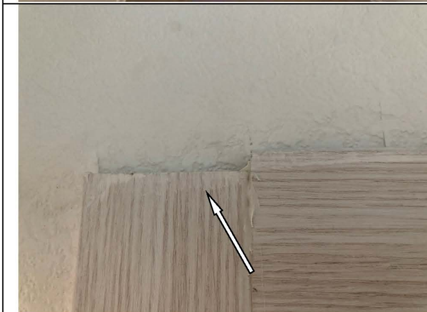
Фото №11. Наличник деревянного дверного блока имеет загрязнения в санузле.
