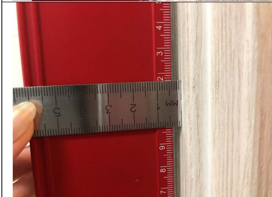
Фото № 51. Отклонение наличников дверного блока в ванной комнате равно 4 мм.
