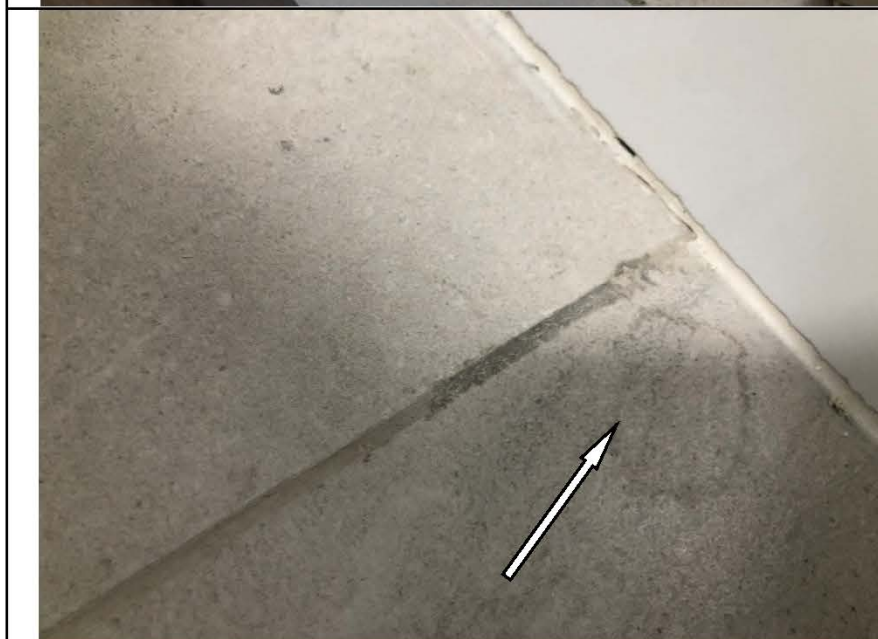
Фото №18. Загрязнения на поверхности керамической плитки в ванной комнате.
