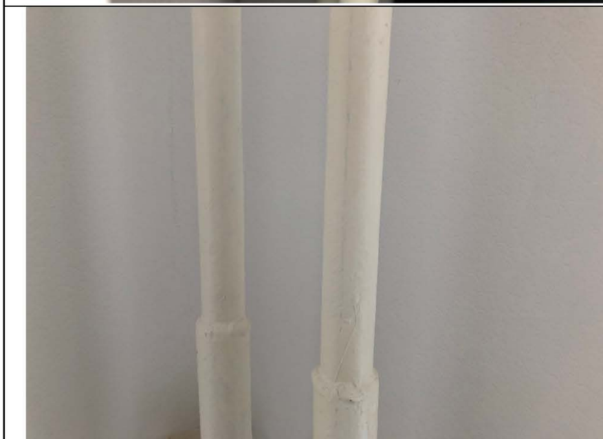
Фото № 84. Окрашивание труб отопления выполнено с дефектами в детской комнате.
