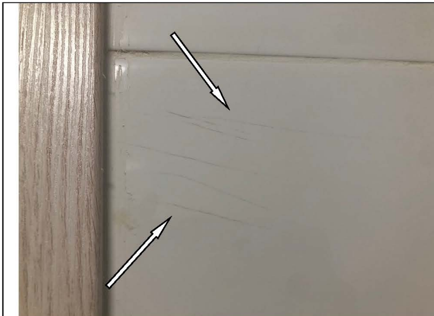
Фото №22. Трещины, отбитости настенной керамической плитки стен в ванной комнате.
