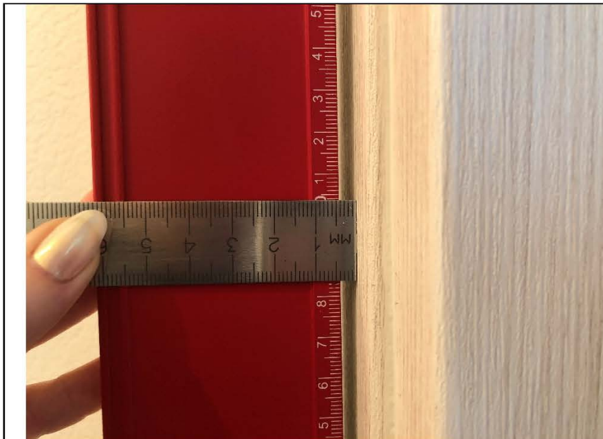
Фото № 49. Отклонение наличников дверного блока в кладовой равно 4,5 мм.
