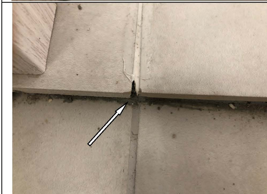
Фото №23. Затирка напольной плитки выполнена с нарушениями: неполное заполнение шовного пространства затирочным составом, каверны, неровность швов в санузле.
