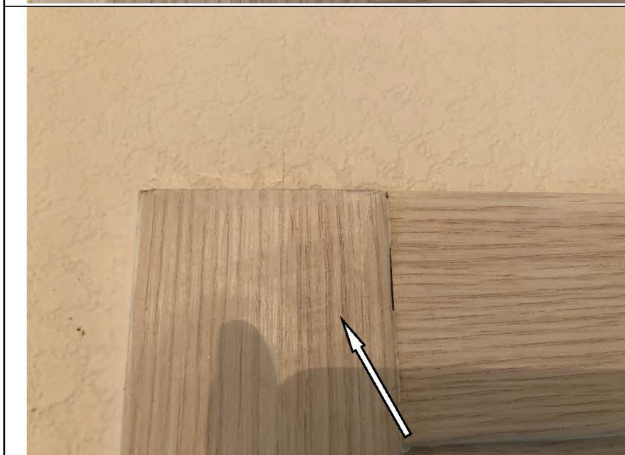
Фото №12. Наличник деревянного дверного блока имеет загрязнения в ванной комнате.
