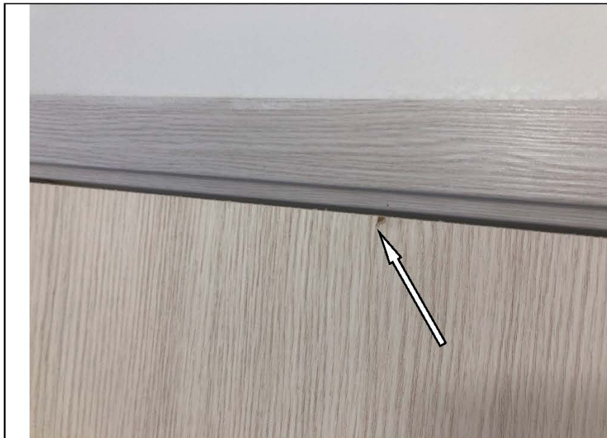
Фото № 64. Полотно деревянного дверного блока имеет сколы в спальне.
