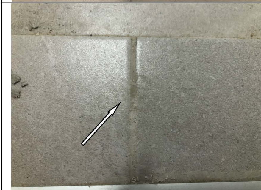
Фото №24. Затирка напольной плитки выполнена с нарушениями: неполное заполнение шовного пространства затирочным составом, каверны, неровность швов в ванной комнате.
