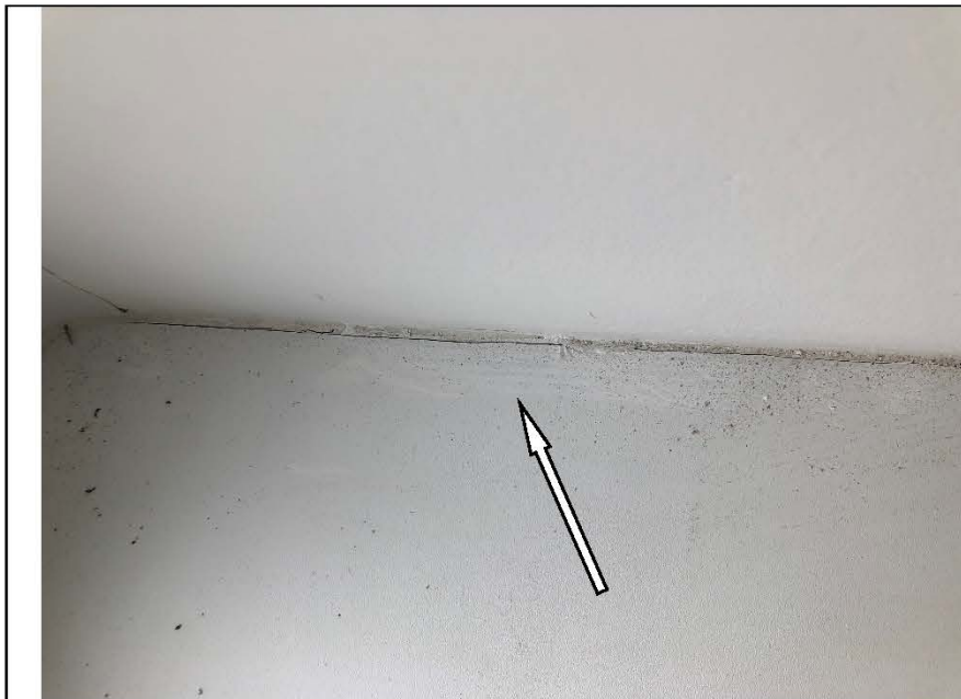
Фото № 82. На лицевой поверхности подоконной доски в детской комнате имеются дефекты (царапины, загрязнения).
