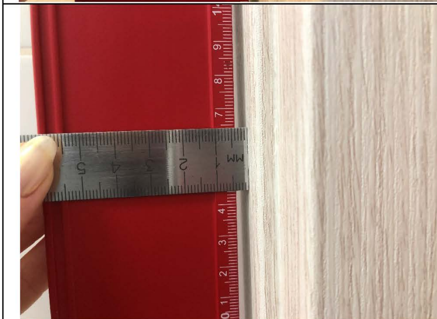
Фото № 50. Отклонение наличников дверного блока в санузле равно 4 мм.
