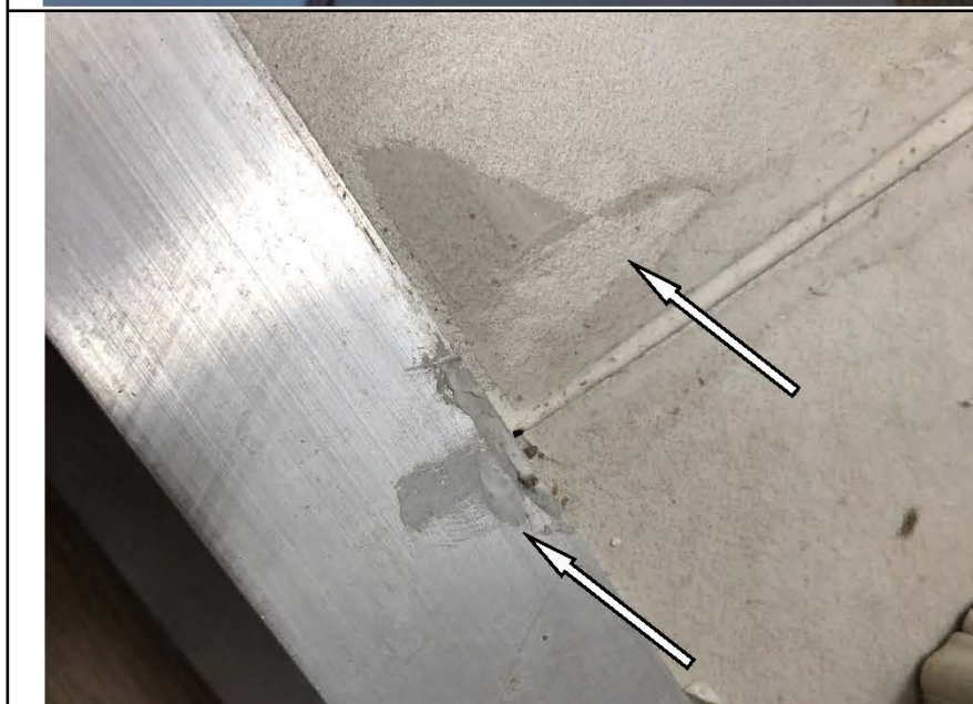
Фото №17. Загрязнения на поверхности керамической плитки в санузле. Загрязнения на поверхности металлического порожка в санузле.
