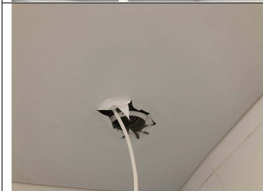
Фото №26. Дефект монтажа натяжного потолка в ванной комнате.
