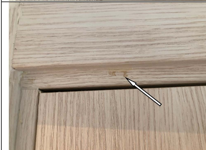
Фото №14. Коробка деревянного дверного блока имеет загрязнения в санузле.
