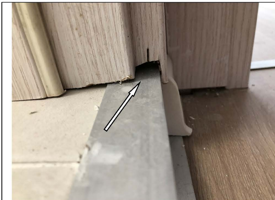
Фото №19. Между напольным покрытием и наличником деревянного дверного блока в санузле имеется пространство.
