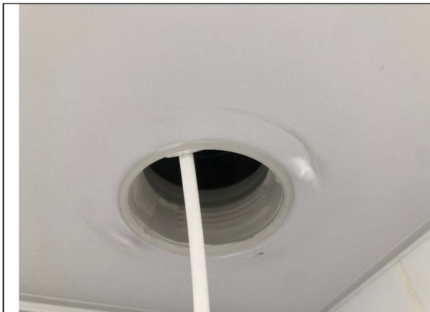
Фото №25. Видны инженерные сети на полотне натяжного потолка в санузле.
