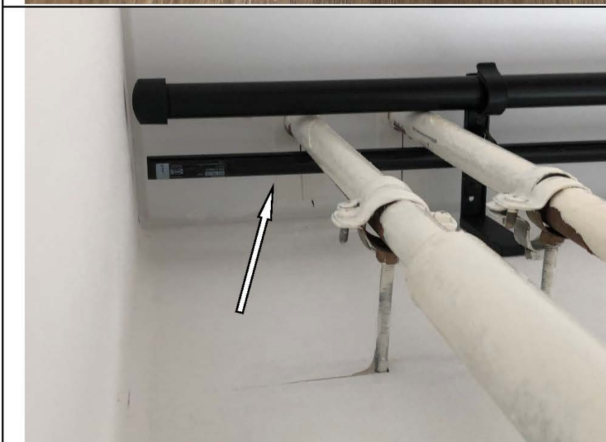
Фото № 92. Загрязнение полотна натяжного потолка в детской комнате.
