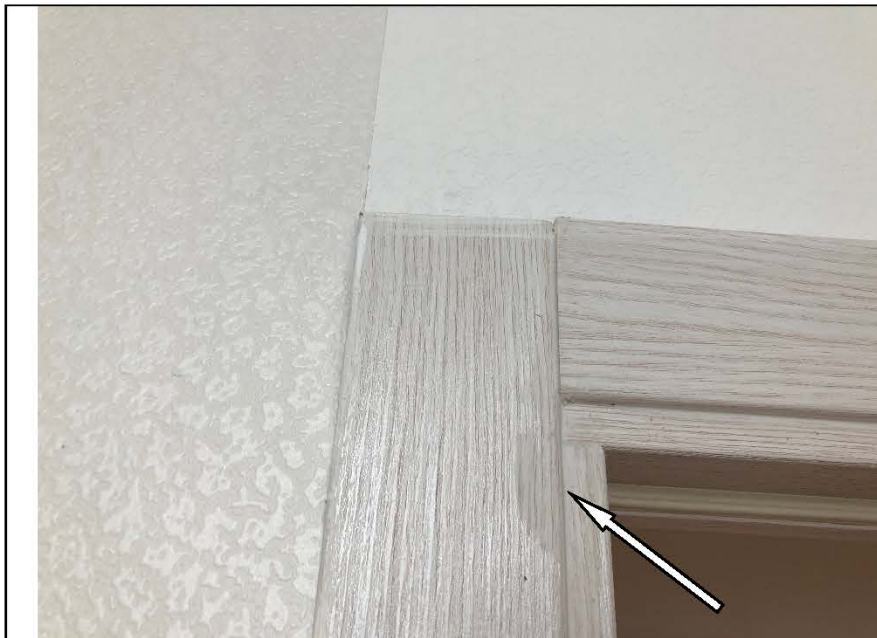
Фото № 58. Наличник деревянного дверного блока имеет загрязнения в кухне.
