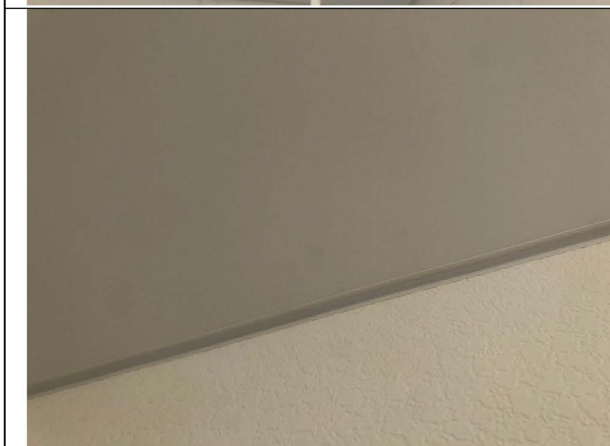
Фото №27. Загрязнение полотна натяжного потолка в прачечной.
