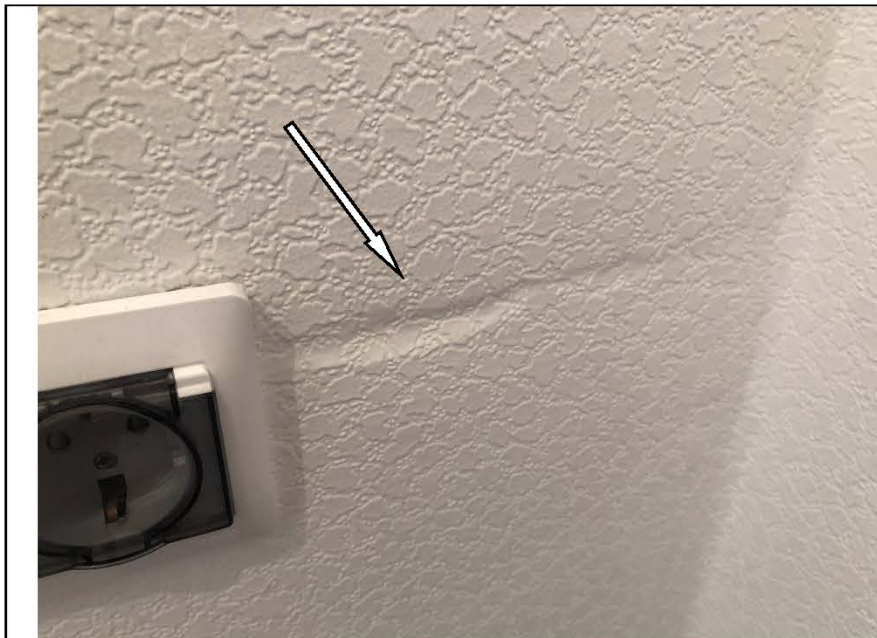
Фото №34. Стены, оклеенные обоями, в прачечной имеют дефект.
