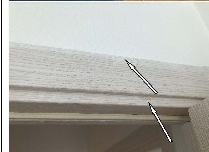
Фото № 60. Наличник деревянного дверного блока имеет загрязнения, коробка деревянного дверного блока имеет загрязнения в гостиной.
