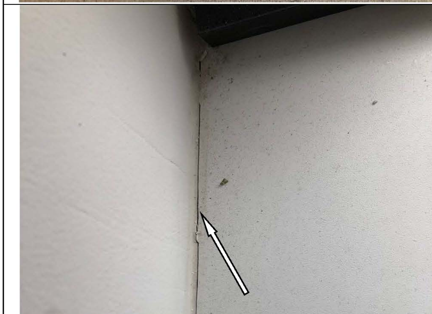
Фото № 66. Дефект монтажа подоконной доски в кухне.
