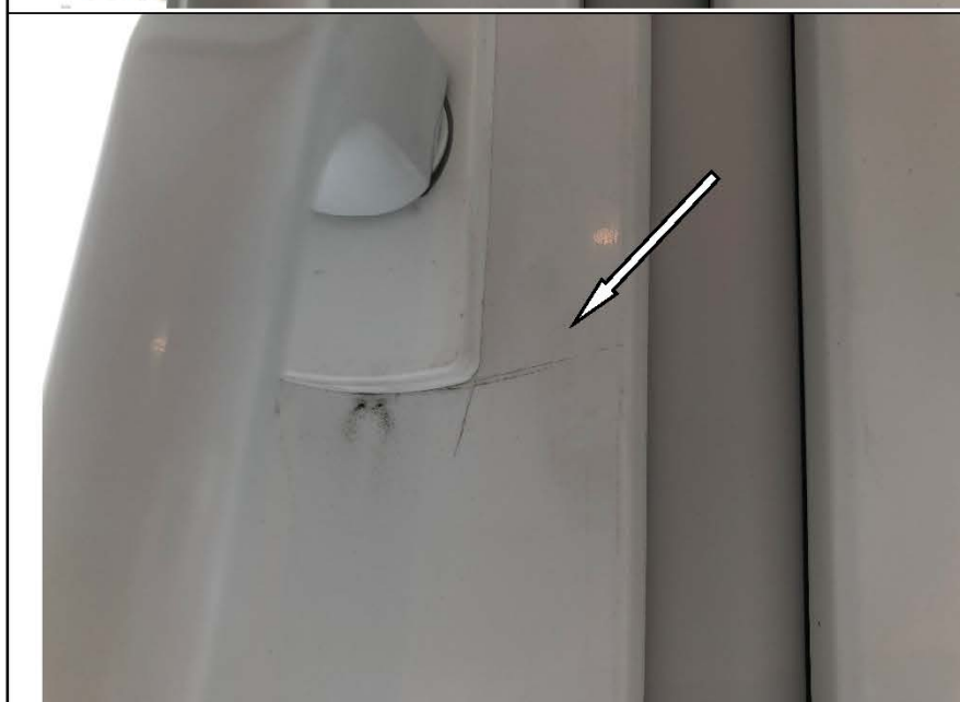
Фото № 78. Профиль ПВХ оконного блока в спальне имеет дефекты (царапины, загрязнения).
