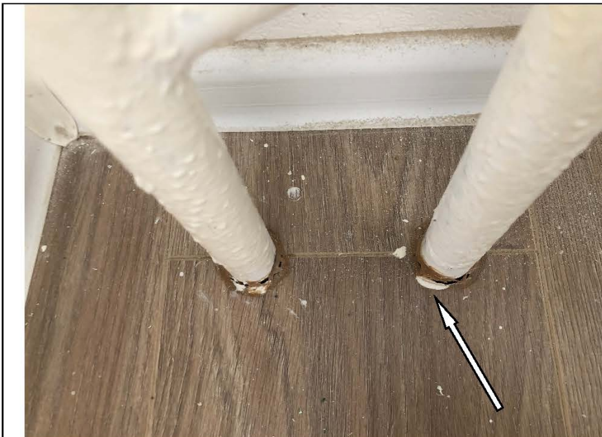
Фото № 91. Загрязнения на поверхности ламината в спальне.
