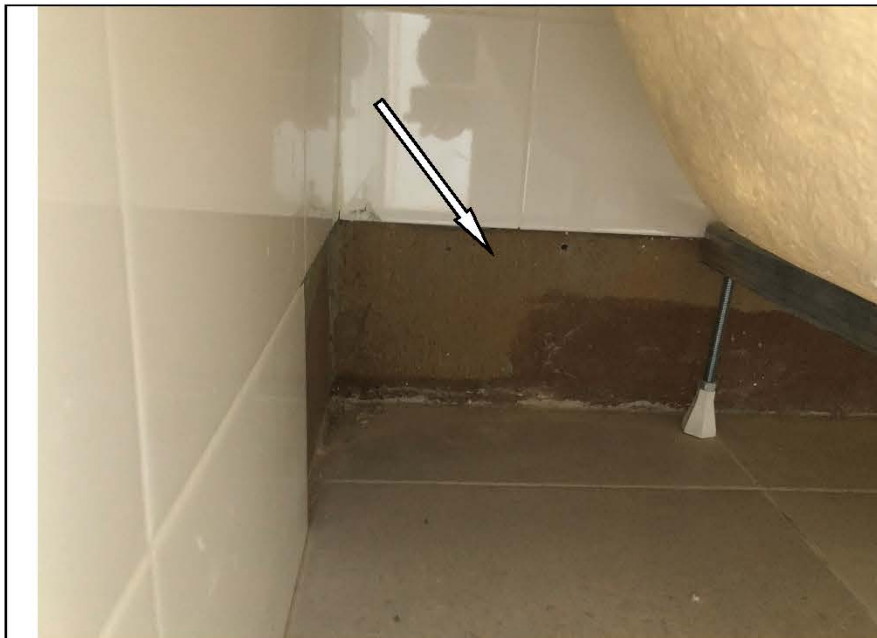
Фото №31. Частично отсутствует настенная керамическая плитка в ванной комнате.
