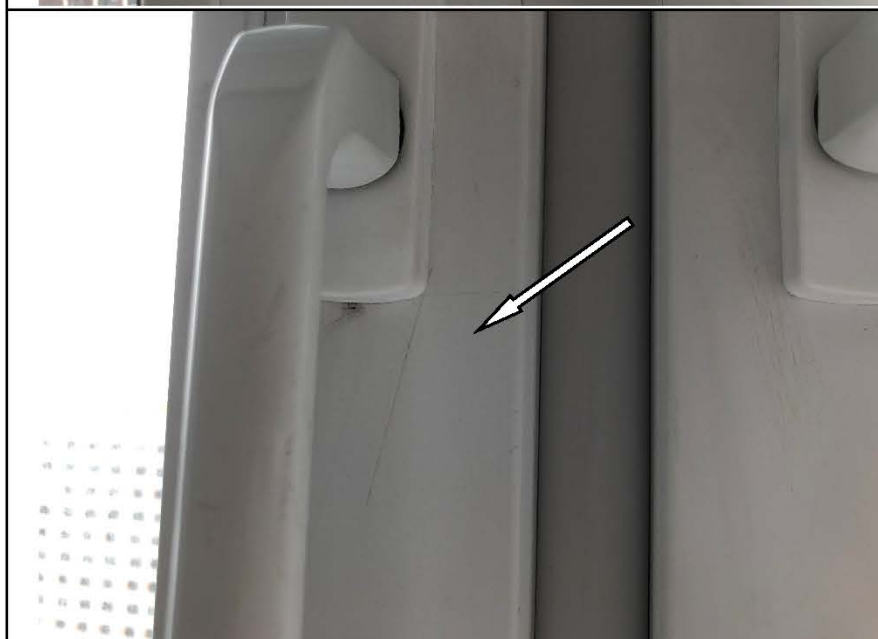
Фото № 77. Профиль ПВХ оконного блока в гостиной имеет дефекты (царапины, загрязнения).
