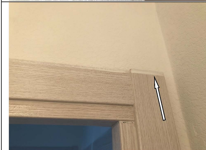
Фото № 59. Наличник деревянного дверного блока имеет загрязнения в детской.
