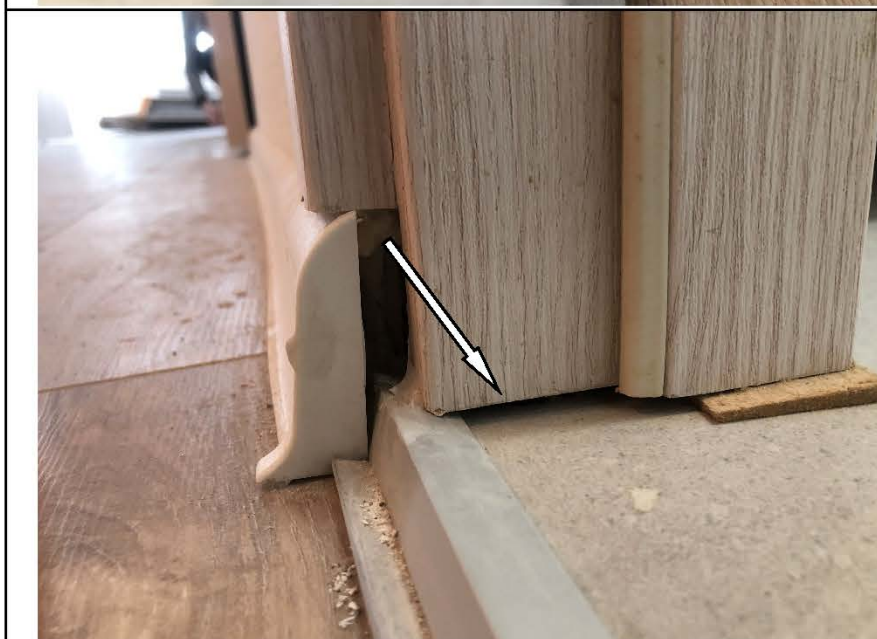
Фото №20. Между напольным покрытием и наличником деревянного дверного блока в ванной комнате имеется пространство.
