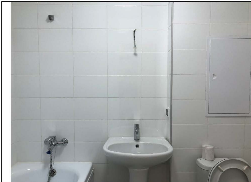
Фото №7. Общий вид ванной комнаты в квартире.
