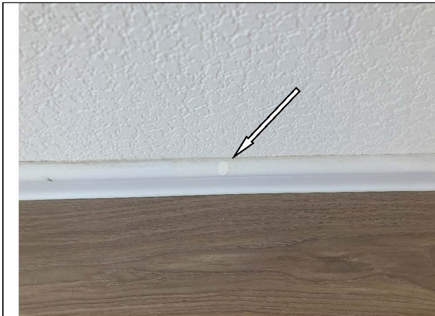
Фото № 97. Загрязнение напольного плинтуса ПВХ в спальне.
