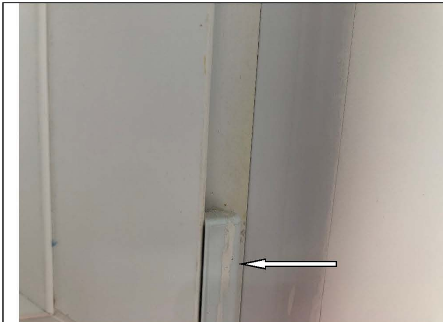
Фото № 73. Профиль ПВХ оконного блока в кухне имеет дефекты (царапины, загрязнения).
