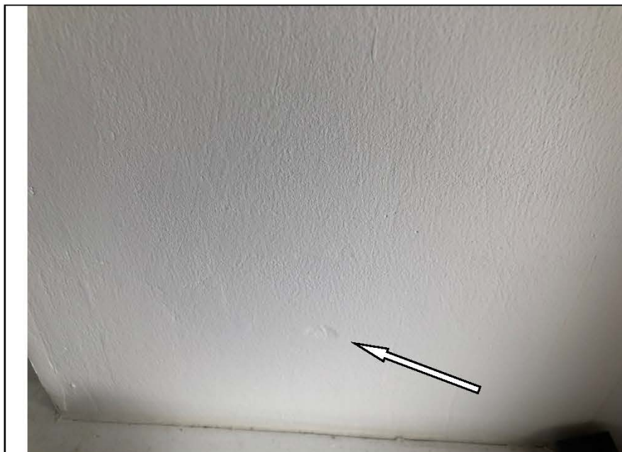
Фото № 70. Окрашенные откосы оконного блока ПВХ выполнены с дефектами в кухне.
