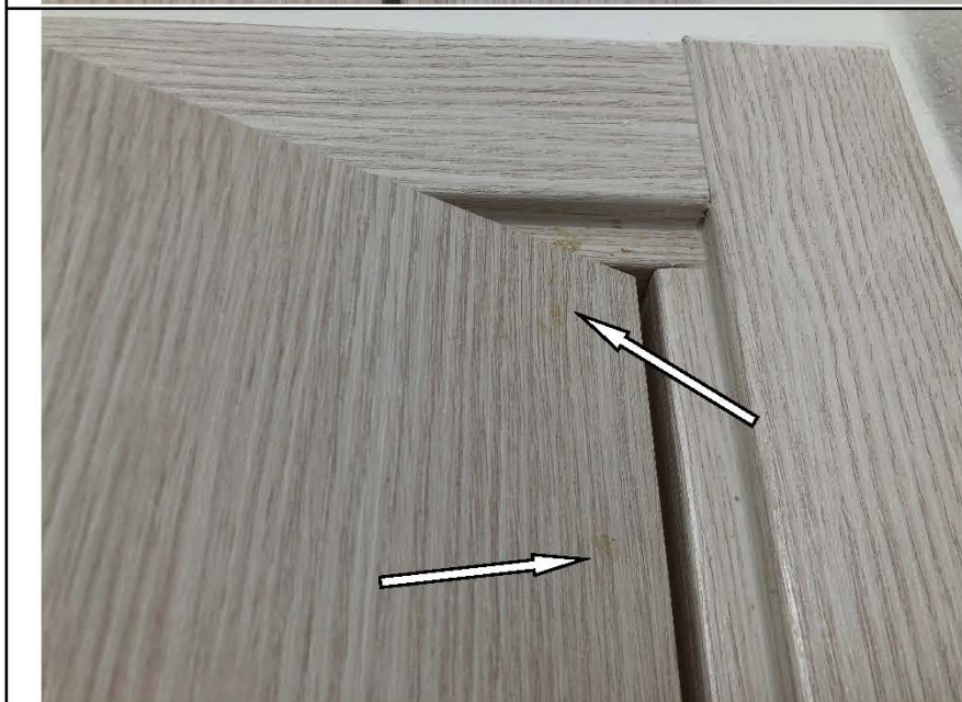
Фото № 62. Коробка деревянного дверного блока имеет загрязнения в кухне, полотно деревянного дверного блока имеет загрязнения в кухне.
