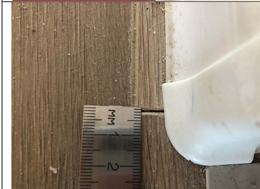
Фото № 57. Зазор между соседними досками ламината равен 1 мм в коридоре.
