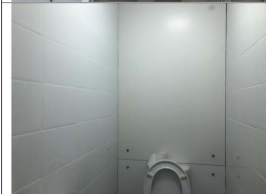
Фото №8. Общий вид санузла в квартире.
