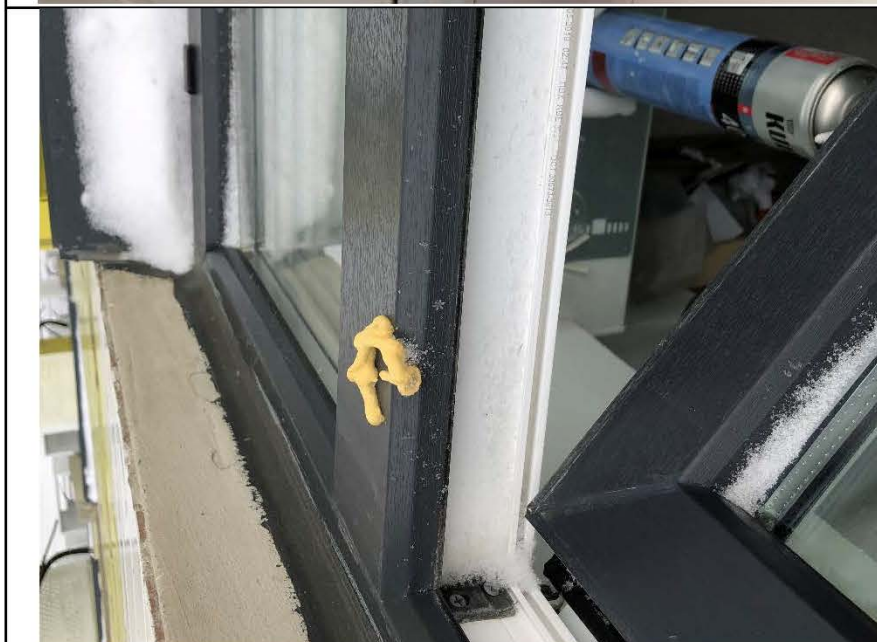
Фото № 74. Профиль ПВХ оконного блока в кухне имеет дефекты (царапины, загрязнения).
