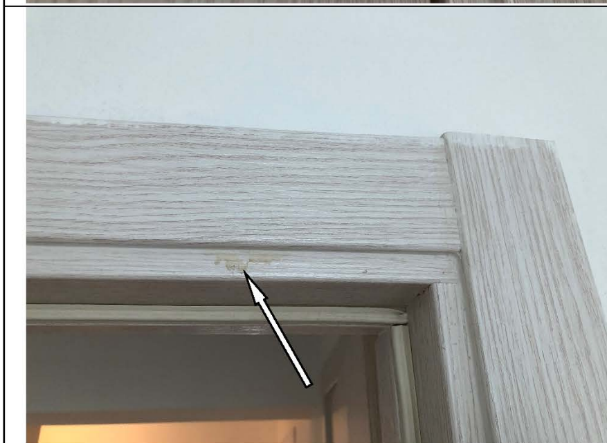
Фото № 63. Коробка деревянного дверного блока имеет загрязнения в детской.
