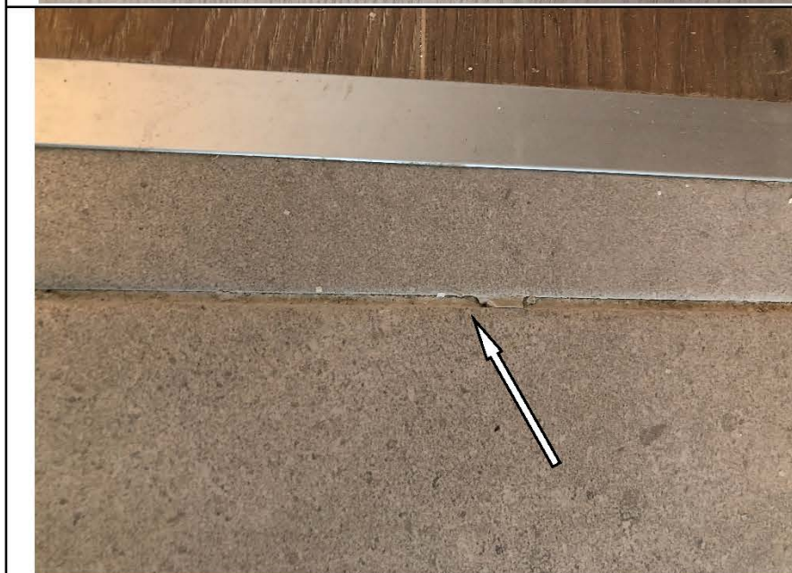
Фото № 65. Затирка напольной плитки в кухне выполнена с нарушениями: неполное заполнение шовного пространства затирочным составом, каверны.
