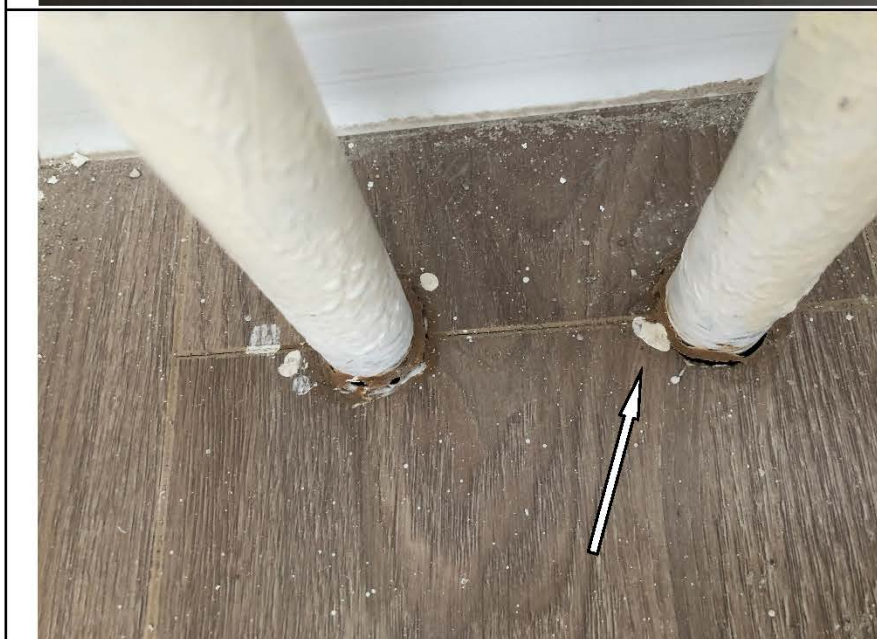
Фото № 89. Загрязнения на поверхности ламината в детской комнате.
