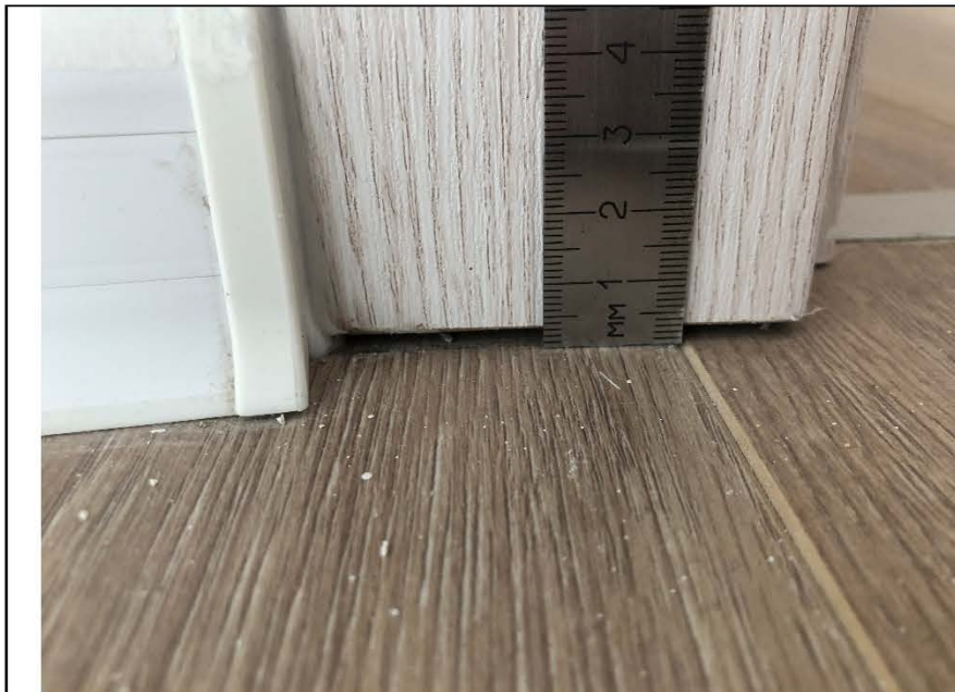
Фото № 94. Между напольным покрытием и наличником деревянного дверного блока в гостиной.
