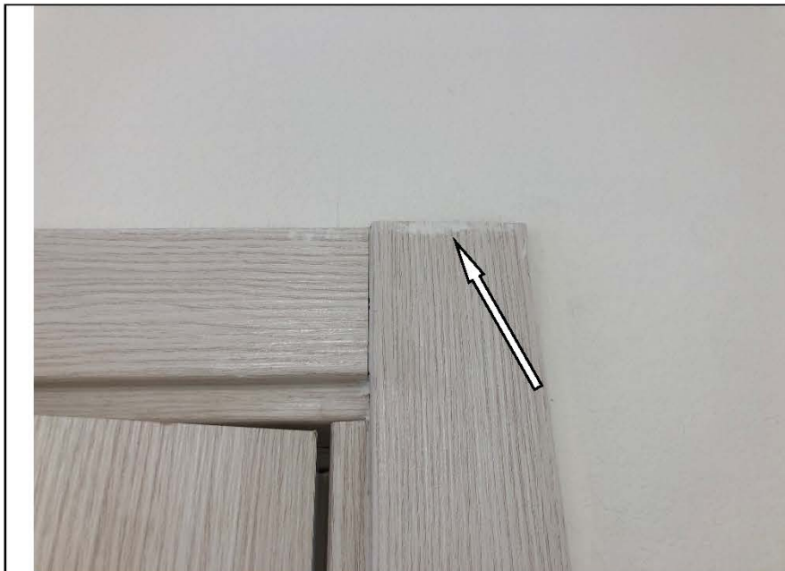
Фото № 61. Наличник деревянного дверного блока имеет загрязнения в спальне.
