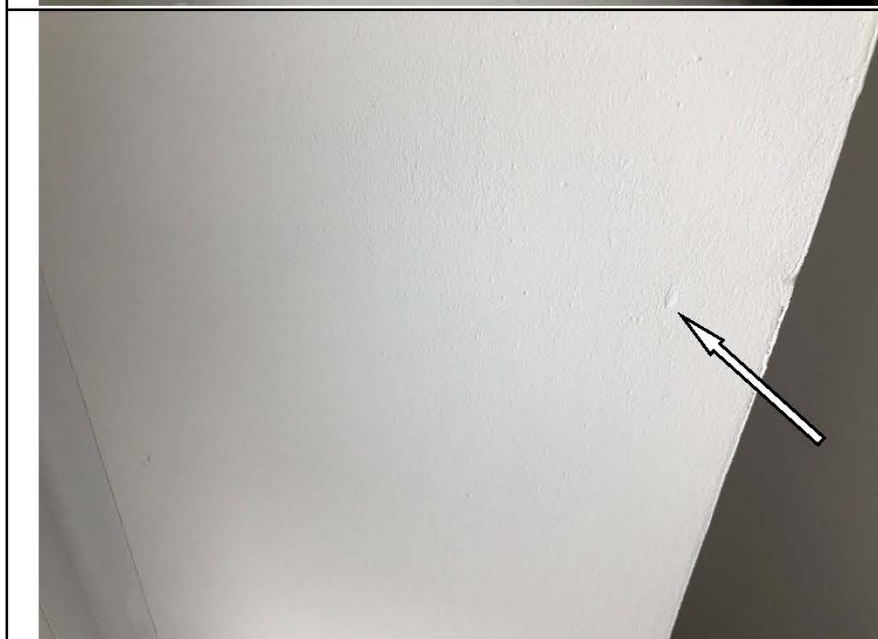
Фото № 71. Окрашенные откосы оконного блока ПВХ выполнены с дефектами в детской комнате.
