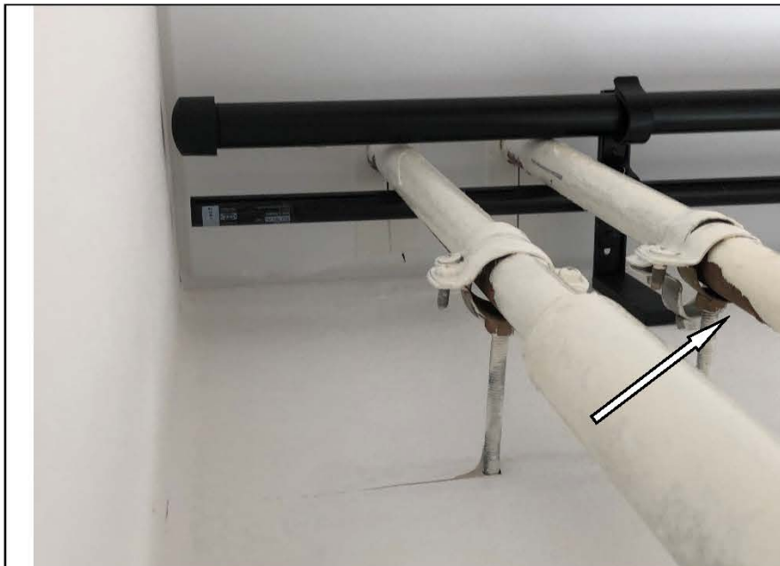
Фото № 85. Окрашивание труб отопления выполнено с дефектами в детской комнате.
