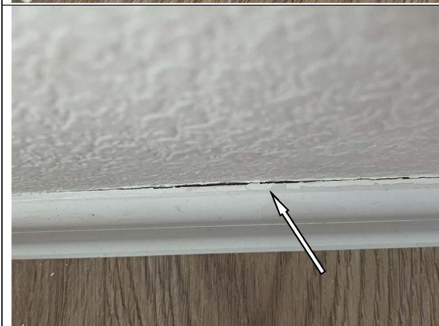
Фото №20. Зазор между плинтусом и стеной в детской.
