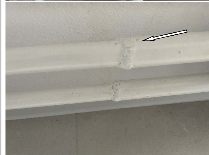
Фото №23. Трубы отопления в кухне окрашены с дефектами.
