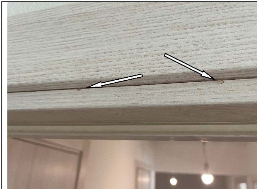
Фото №40. Повреждение дверного блока в детской.
