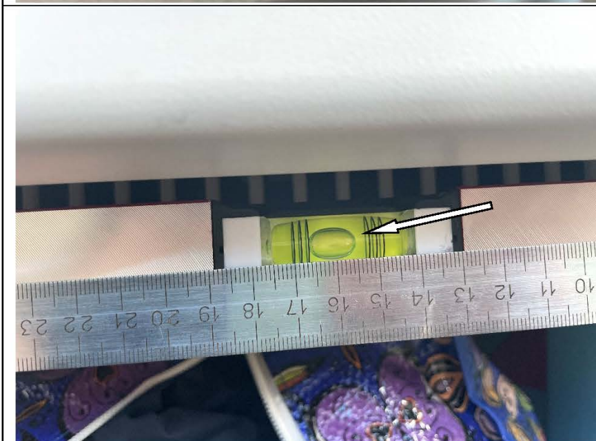
Фото №44. Отопительный прибор в детской смонтирован неровно.
