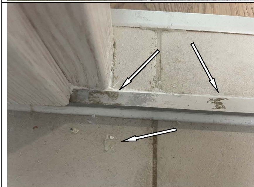
Фото №56. Дефект затирки швов напольной керамической плитки в кухне. Повреждение металлического плинтуса.
