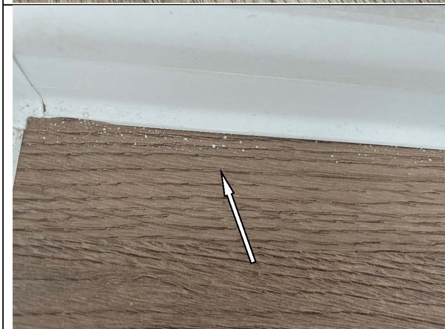
Фото №18. Загрязнение ламината в спальне.
