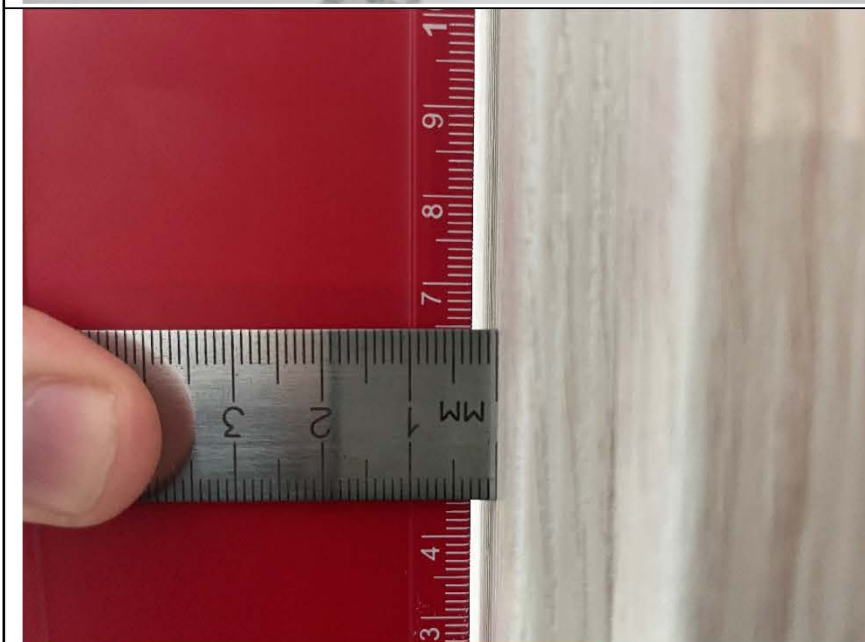
Фото №32. Отклонение коробки дверного блока в спальне.
