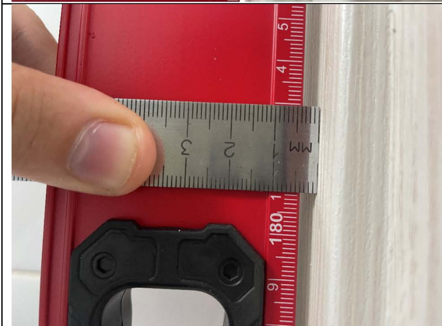
Фото №33. Отклонение коробки дверного блока в санузле.
