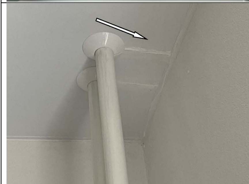
Фото №30. Дефект натяжного потолка в кухне.
