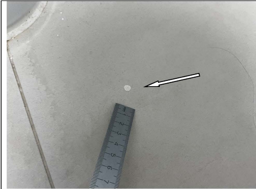
Фото №58. Загрязнение напольной керамической плитки в ванной комнате..
