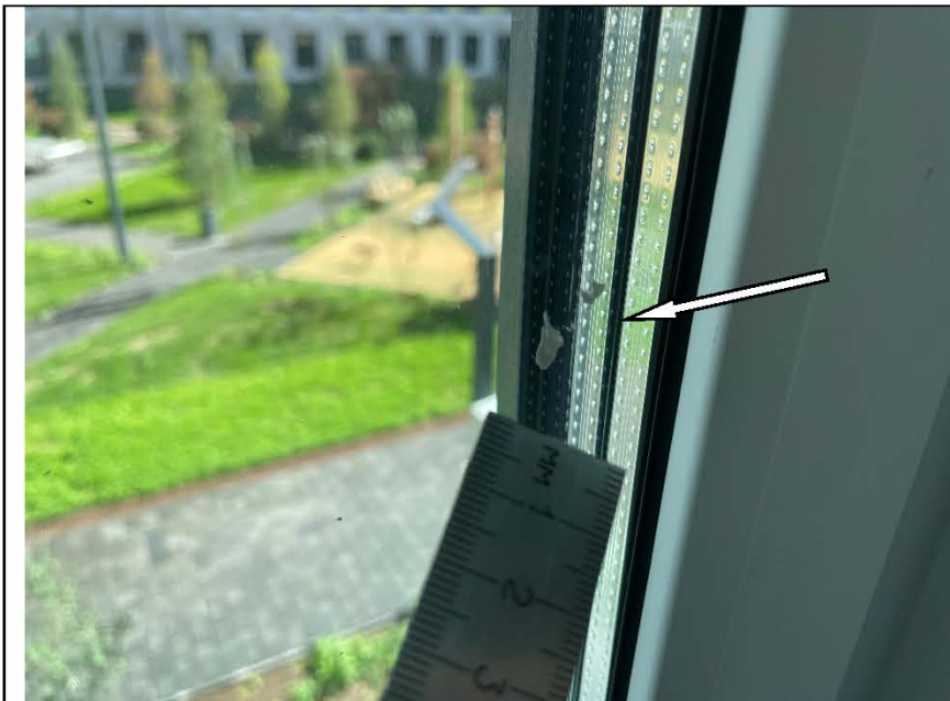
Фото №49. Загрязнение на стеклопакете оконного блока ПВХ в спальне.
