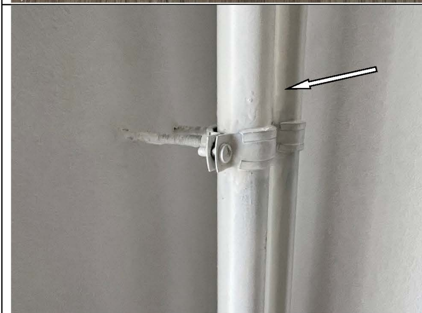
Фото №21. Трубы отопления в детской окрашены с дефектами.
