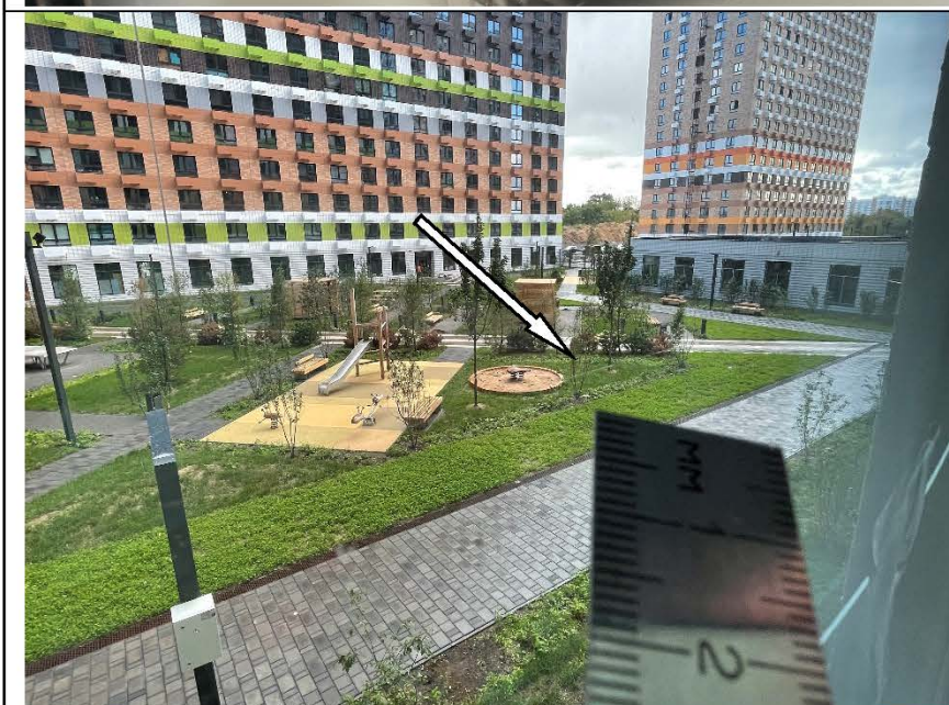
Фото №47. Царапина на стеклопакете оконного блока ПВХ в детской.
