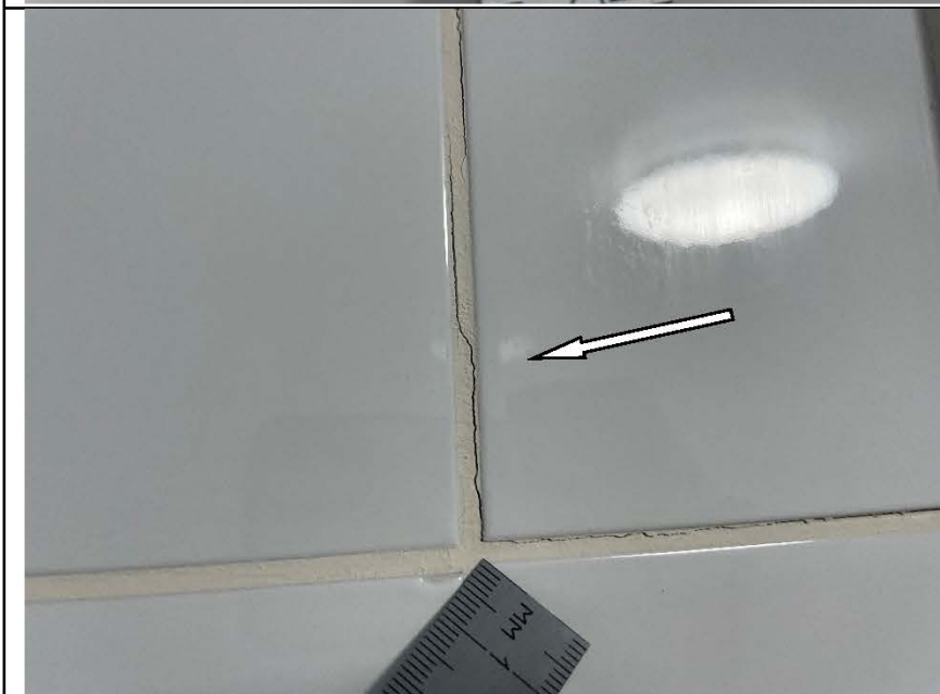
Фото №60. Затирка швов настенной керамической плитки в ванной комнате.
