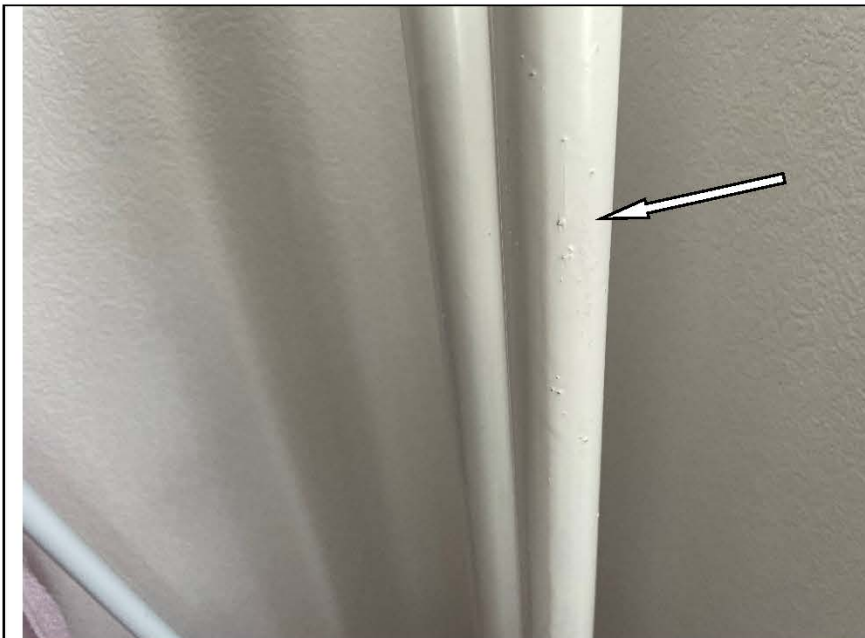
Фото №22. Трубы отопления в спальне окрашены с дефектами.
