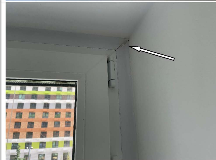
Фото №53. Щель в оконном блоке в кухне.
