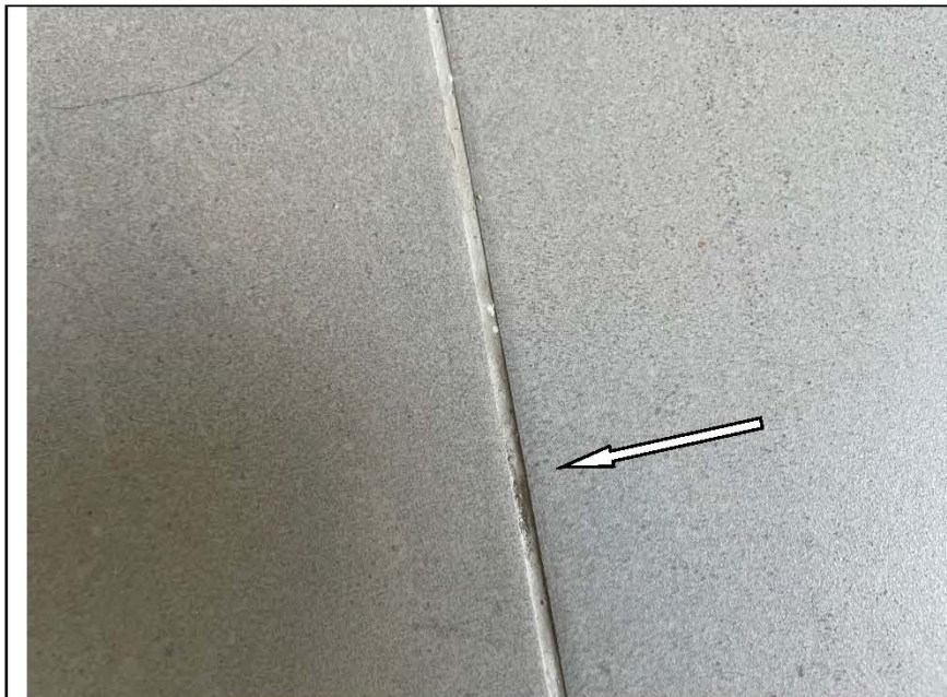
Фото №55. Дефект затирки швов напольной керамической плитки в кухне.
