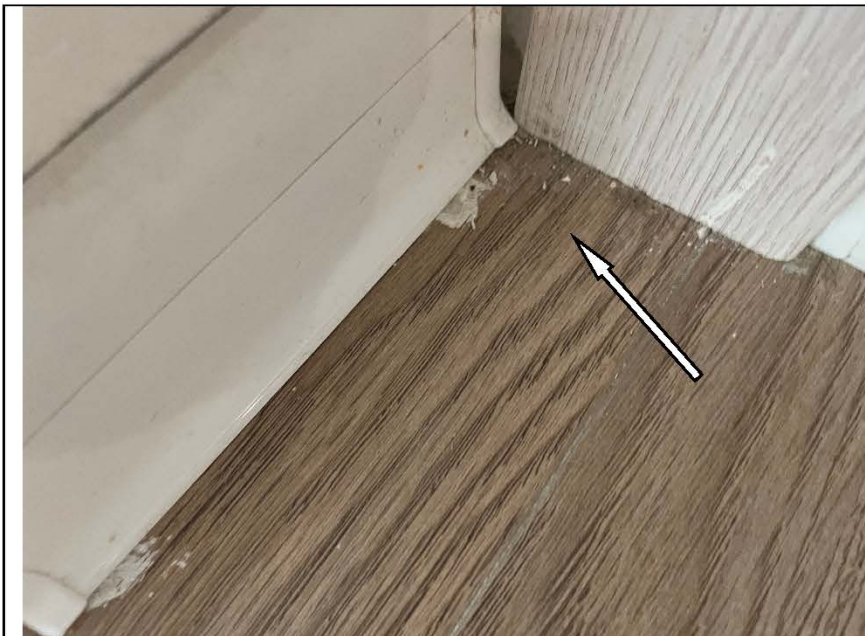
Фото №19. Загрязнение ламината в коридоре.
