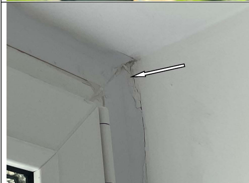
Фото №51. Щель в оконном блоке в детской.
