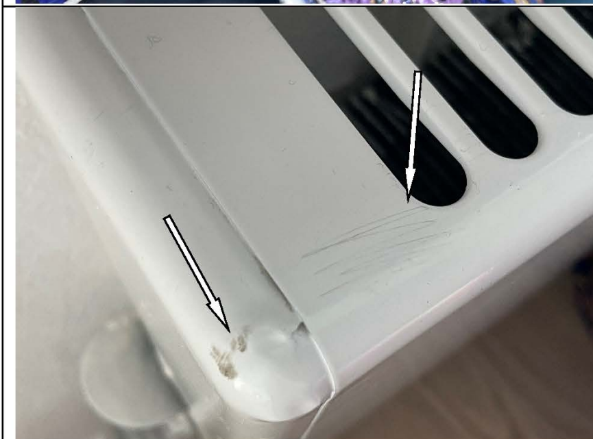
Фото №45. Кожух отопительного прибора в детской поврежден.
