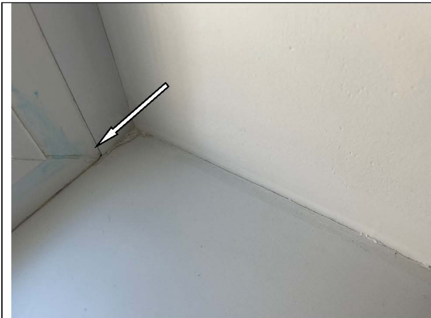
Фото №52. Щель в оконном блоке в спальне.
