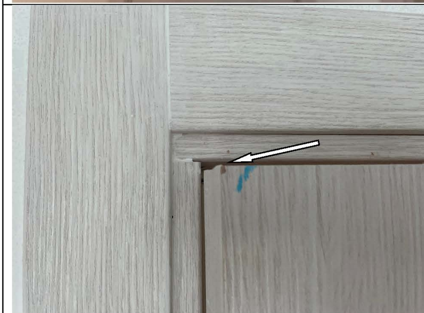
Фото №42. Повреждение дверного полотна в спальне.
