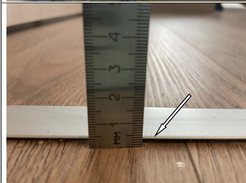
Фото №65. Дефект металлического порожка в коридоре.
