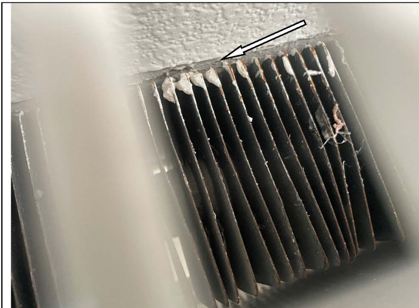
Фото №46. Решетка радиатора в кухне загрязнена.
