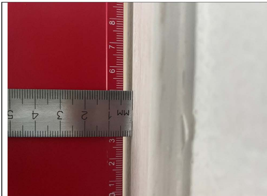
Фото №37. Отклонение наличника в кухне.
