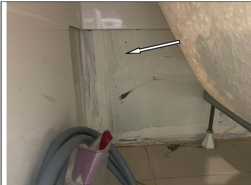
Фото №64. Частично отсутствует настенная керамическая плитка в ванной комнате.
