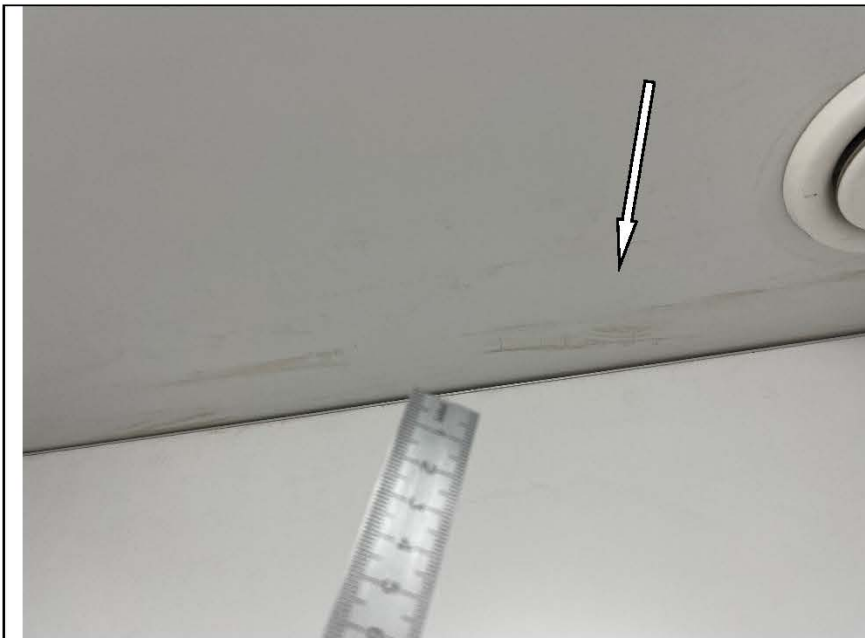
Фото №31. Окрашенный потолок в санузле загрязнен..
