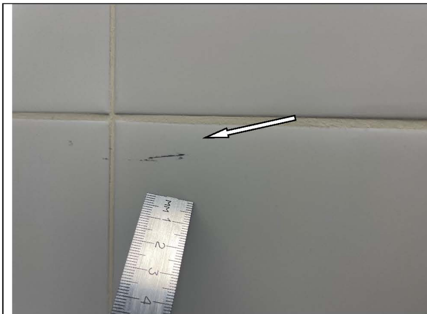
Фото №61. Загрязнение настенной керамической плитки в санузле.
