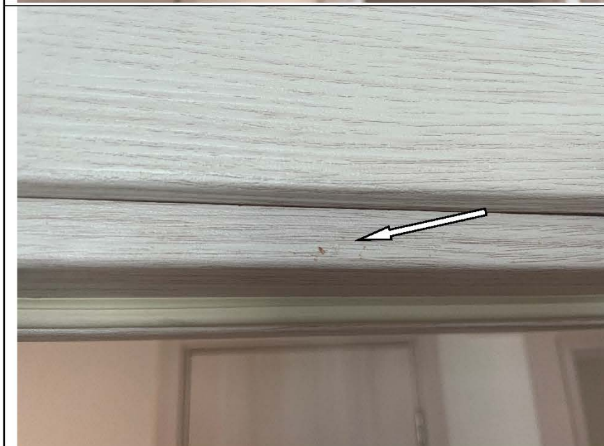
Фото №41. Повреждение дверного блока в спальне.
