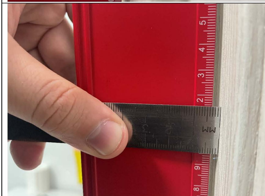
Фото №38. Отклонение наличника в ванной комнате.
