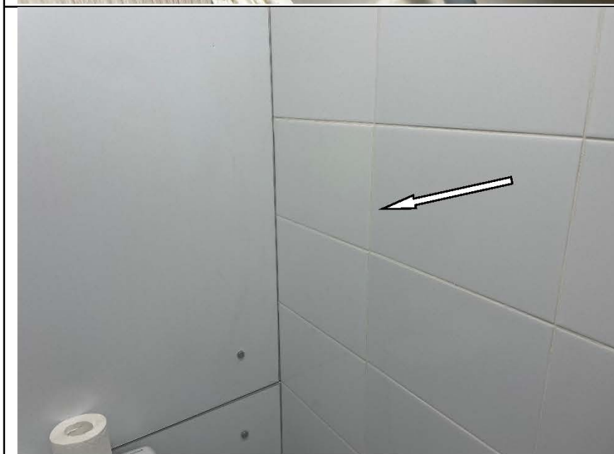
Фото №63. Разный цвет плитки в санузле.
