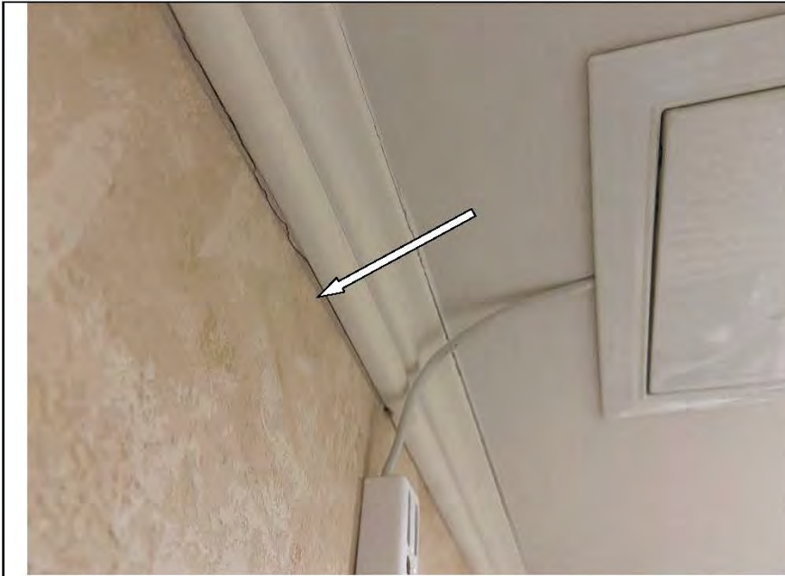
Фото №25. Следы залития на стенах, оклеенных обоями, в кладовой.
