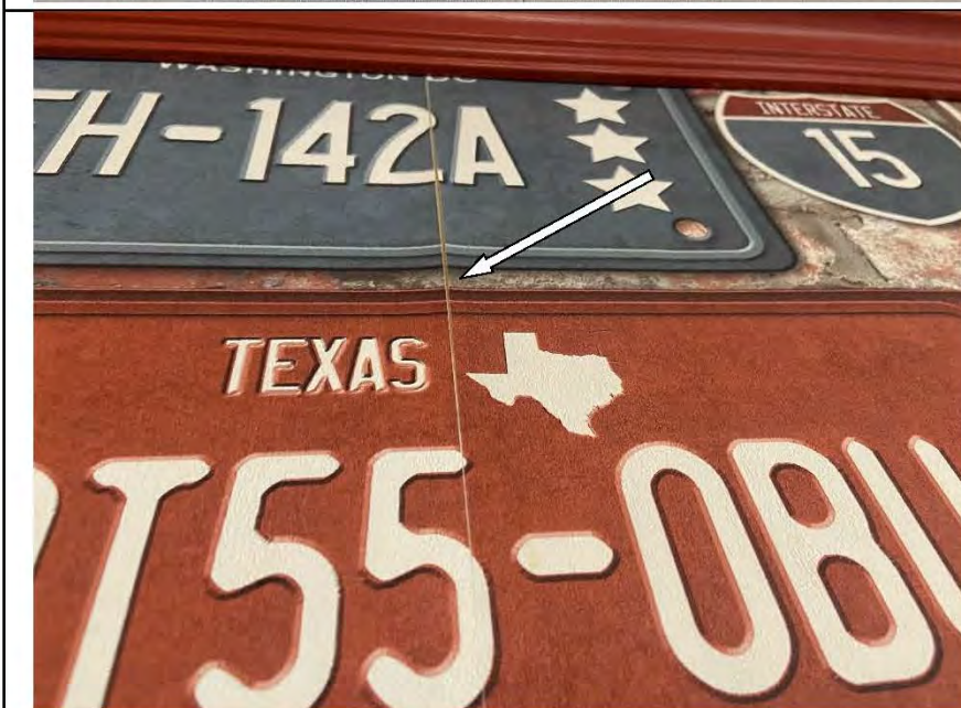
Фото №24. Следы заливания на стенах, оклеенных обоями, в спальне.
