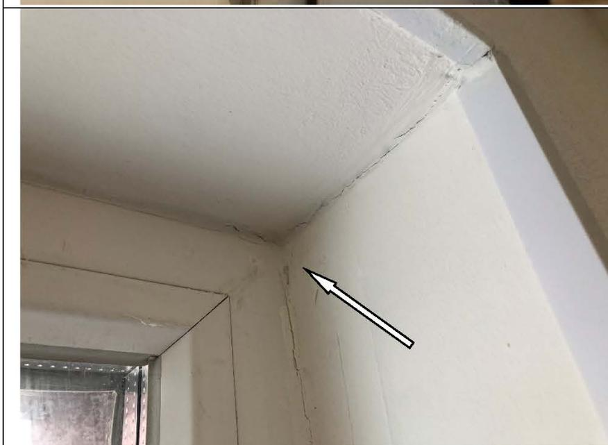
Фото №57. Инфильтрация оконного блока ПВХ в спальне в квартире.
