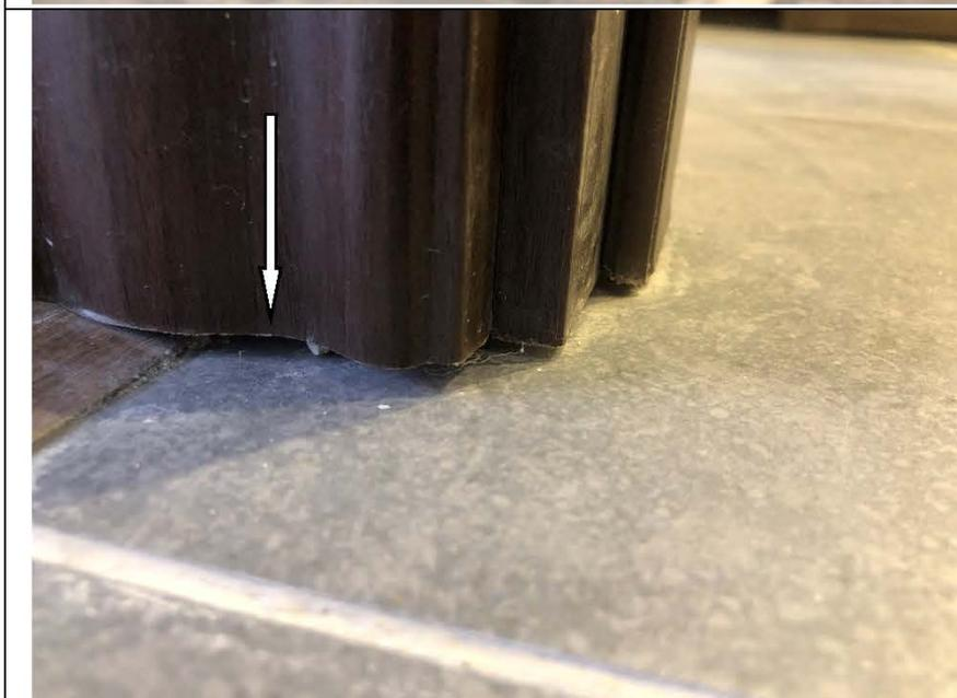
Фото №42. Наличник деревянного дверного блока не достает до напольного покрытия в спальне в квартире.
