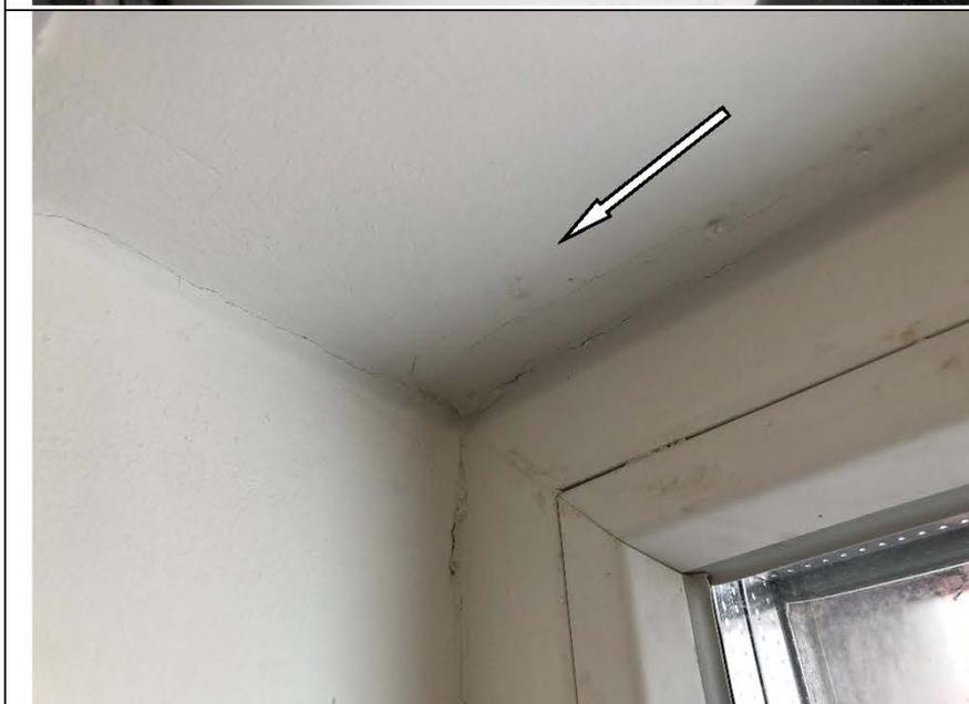
Фото №47. Неровности, сколы на окрашенных откосах оконного блока ПВХ в спальне в квартире.
