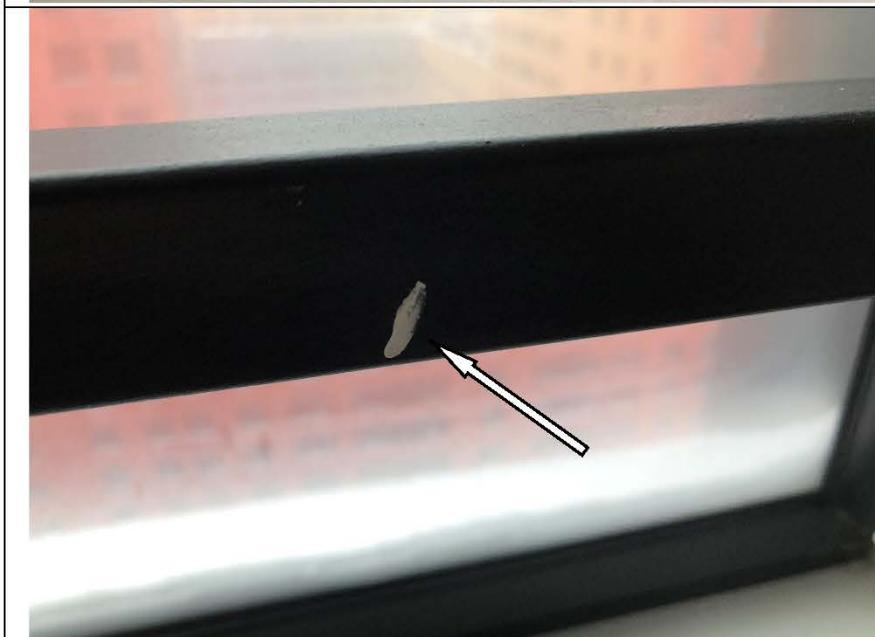
Фото №59. Загрязнения на металлическом профиле на лоджии в квартире.
