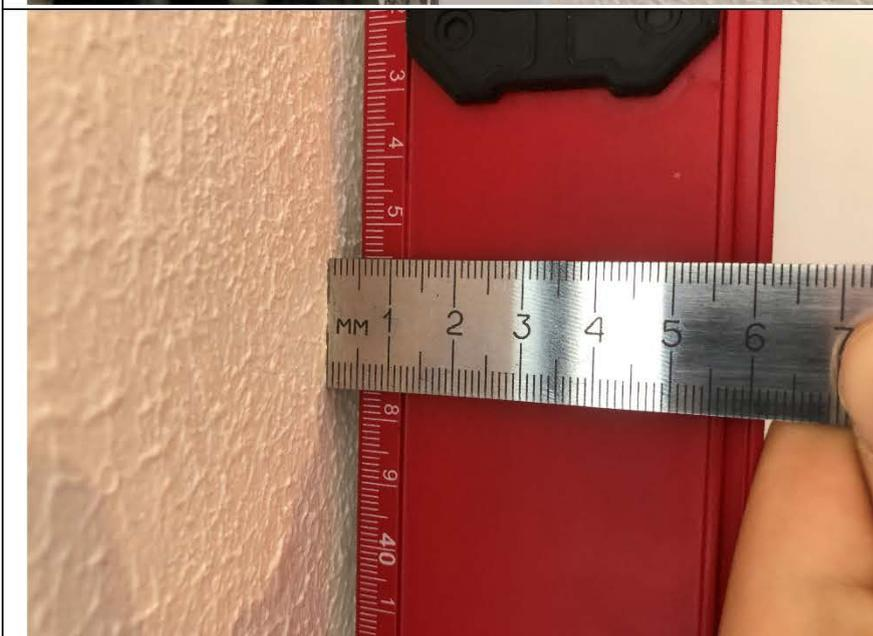
Фото №62. Измерение уровня стен на лоджии в квартире.
