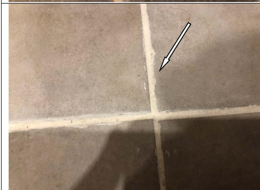
Фото №27. Неровный шов напольной керамической плиткой в ванной комнате в квартире.
