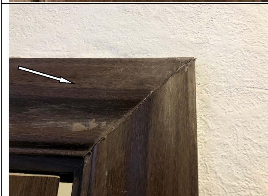
Фото №24. Притертости на наличнике деревянного дверного блока в спальне в квартире.
