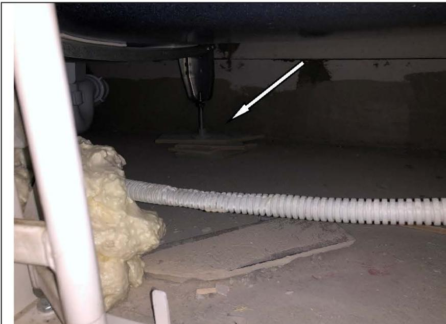
Фото №34. Неустойчиво закреплена конструкция ванны в ванной комнате в квартире.
