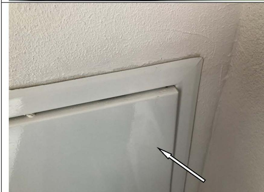
Фото №60. Загрязнения на сантехническом люке на лоджии в квартире.
