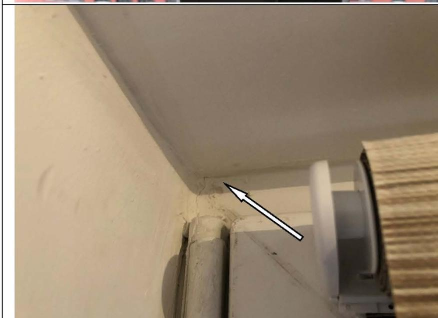
Фото №56. Инфильтрация оконного блока ПВХ в кухне в квартире.
