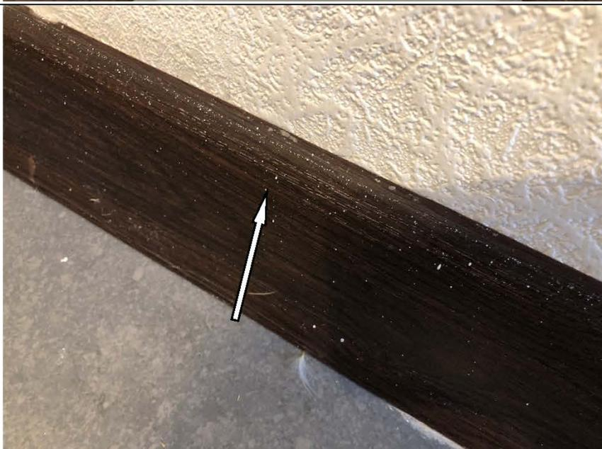
Фото №15. Загрязнения на напольном деревянном плинтусе в спальне в квартире.
