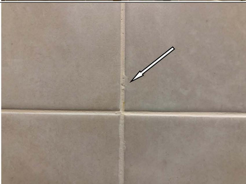
Фото №30. Неровный шов настенной керамической плитки в ванной комнате в квартире.
