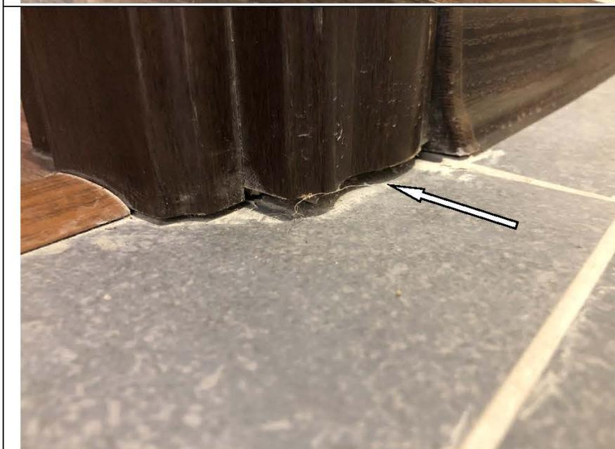
Фото №41. Наличник деревянного дверного блока не достает до напольного покрытия в кухне в квартире.
