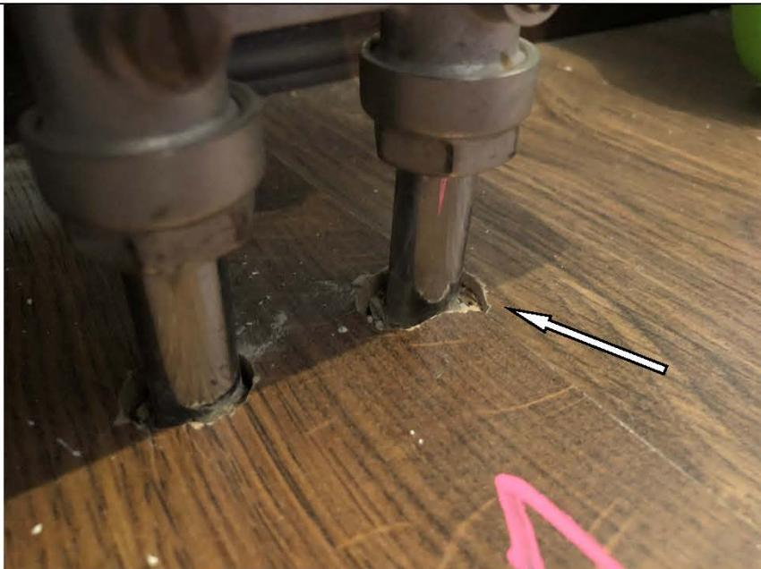
Фото №53. Дефект вставки труб отопления в напольное покрытие из ламината в кухне в квартире.
