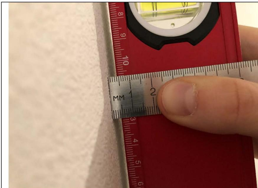
Фото №7. Измерение уровня стен кухни в квартире.
