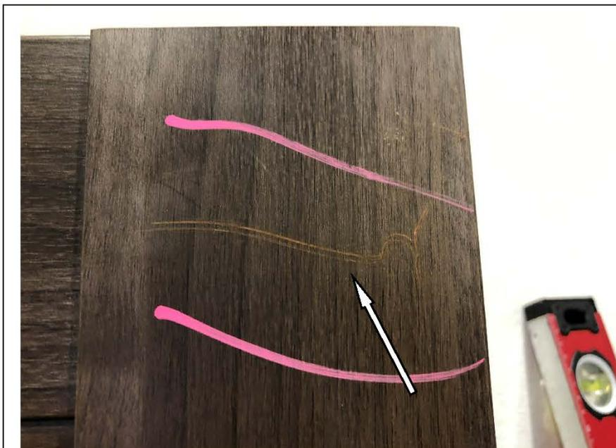
Фото №22. Царапина на наличнике деревянного дверного блока в ванной комнате в квартире.
