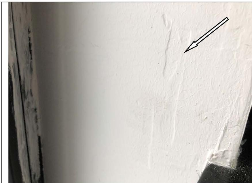
Фото №46. Неровности, сколы на окрашенных откосах оконного блока ПВХ на лоджии в квартире.
