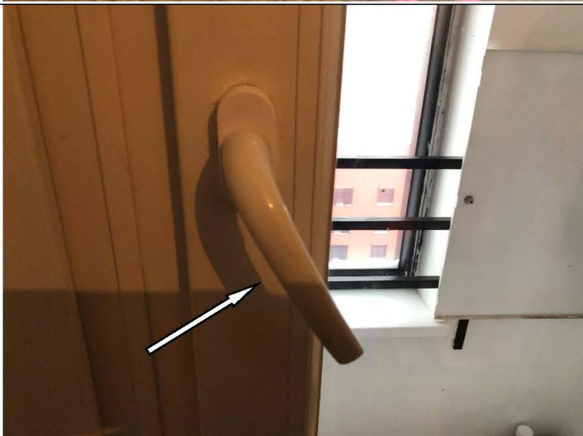
Фото №54. Не отрегулирована фурнитура оконного блока ПВХ в кухне в квартире.
