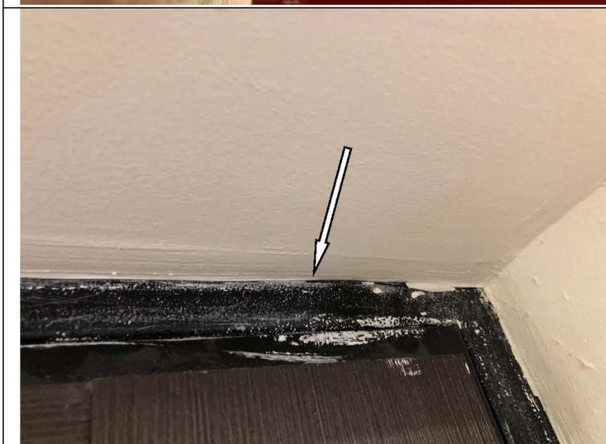
Фото №9. Загрязнения на блоке входной металлической двери в коридоре в квартире.
