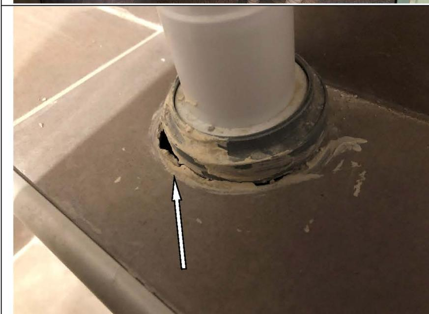
Фото №36. Дефект заделки трубопровода в напольное покрытие из керамической плитки в ванной комнате в квартире.
