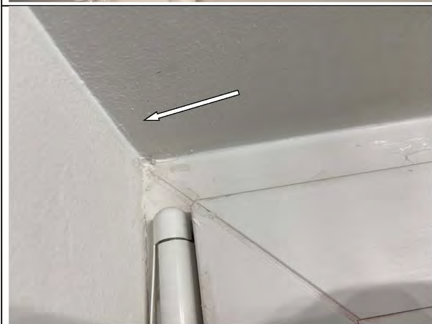
Фото №63. Неровности, выбоины, раковины на окрашенных откосах оконного блока ПВХ в гостиной.
