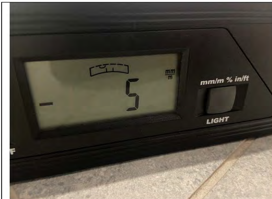
Фото №28. Отклонение поверхности напольного покрытия из керамической плитки в коридоре.
