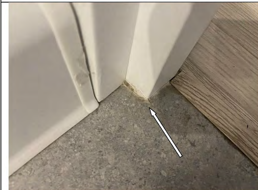
Фото №32. Загрязнения на напольной керамической плитке в коридоре.
