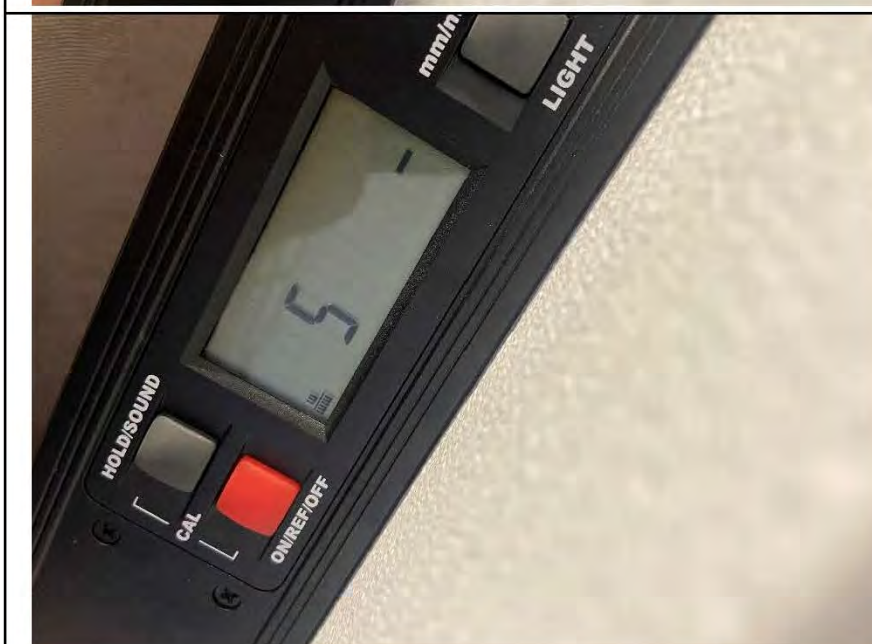
Фото №14. Отклонение поверхности стен от вертикали в кухне.
