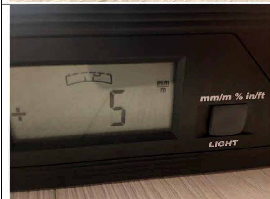
Фото №26. Отклонение поверхности напольного покрытия из ламината в кладовой.
