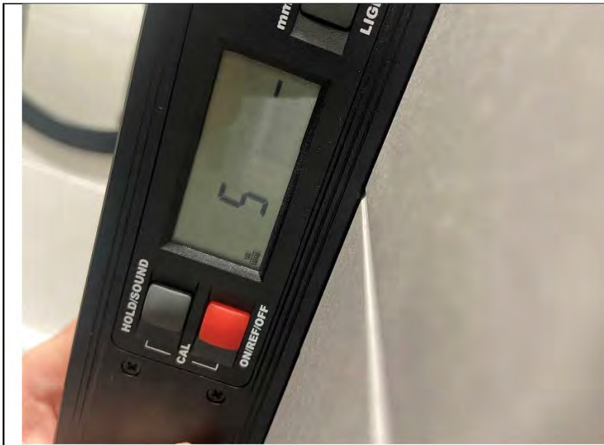
Фото №16. Отклонение поверхности стен от вертикали в санузле.
