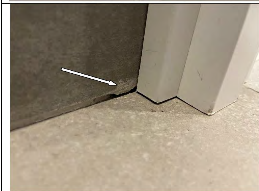
Фото №18. Загрязнения на настенной керамической плитке в санузле.
