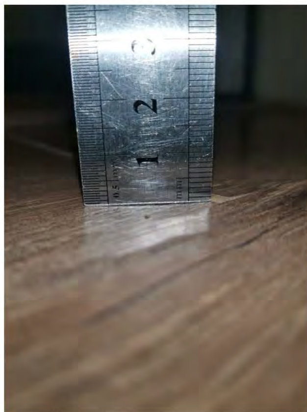
Фото 5, 6. Коридор. Напольное покрытие из ламинированной доски. Вздутие кромок смежных досок.
