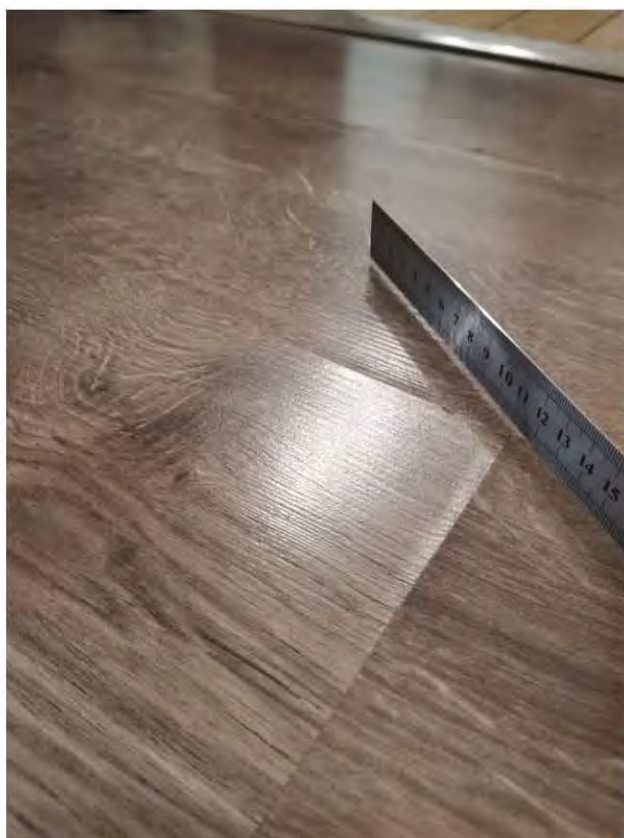
Фото 5, 6. Коридор. Напольное покрытие из ламинированной доски. Вздутие кромок смежных досок.
