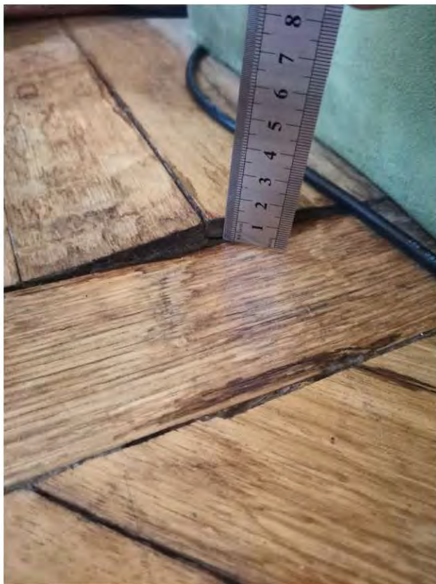
Фото 10, 11. Комната. Напольное покрытие из паркета. Вздутие кромок смежных досок, разбухание отдельных плашек, потемнение структуры дерева.
