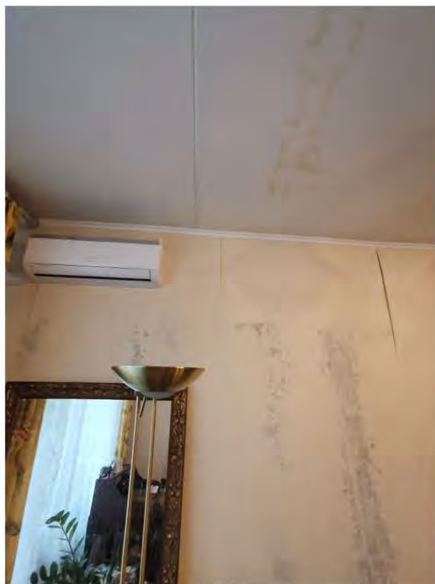
Фото 8, 9. Комната. Стены. Отслоение обоев, появление под обоями признаков поражения грибком (темные пятна)
