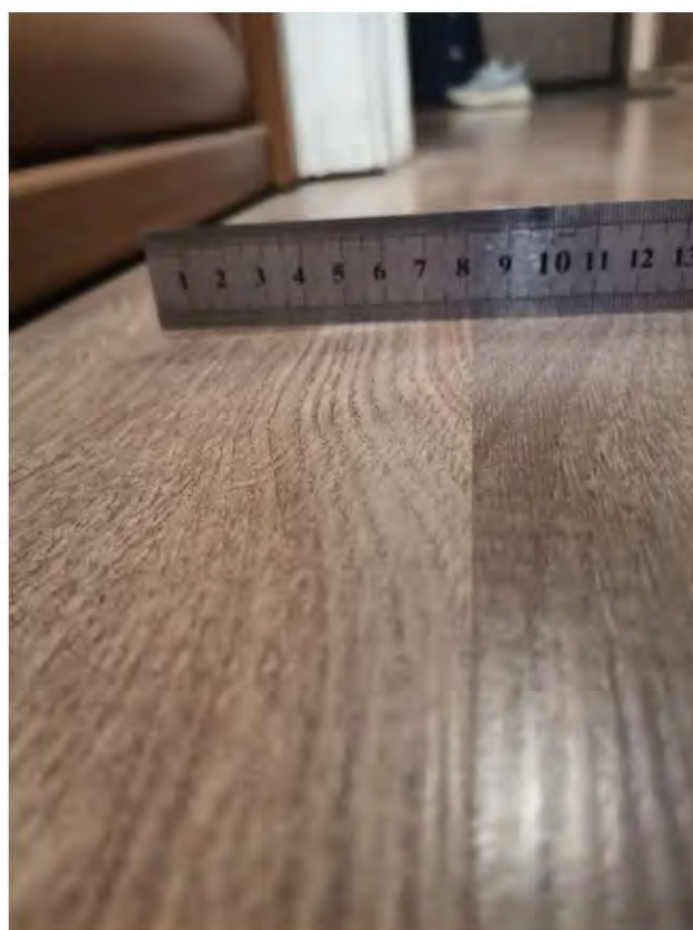
Фото 12. Кухня. Напольное покрытие из ламинированной доски. Вздутие кромок смежных досок.
