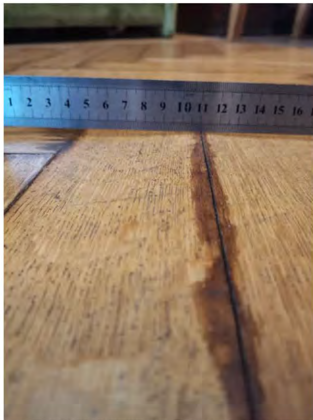
Фото 10, 11. Комната. Напольное покрытие из паркета. Вздутие кромок смежных досок, разбухание отдельных плашек, потемнение структуры дерева.
