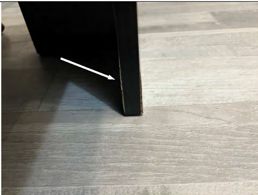
Фото №35. Вздутие стенок читального столика в кухне.
