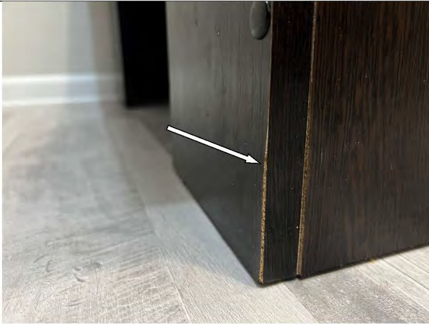
Фото №34. Вздутие стенок читального столика в кухне.
