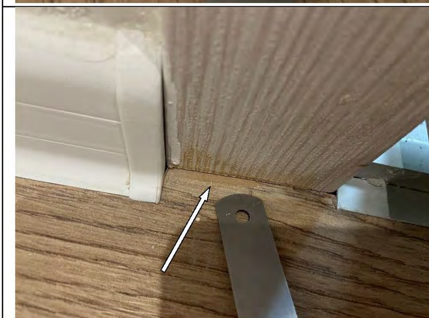
Фото №24. Коротко подрезаны доски ламината на стыке элементов в коридоре.
