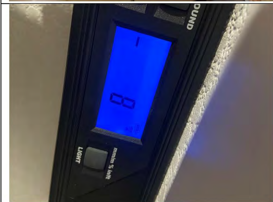
Фото №6. Отклонение по уровню вертикальности поверхности стен в коридоре.
