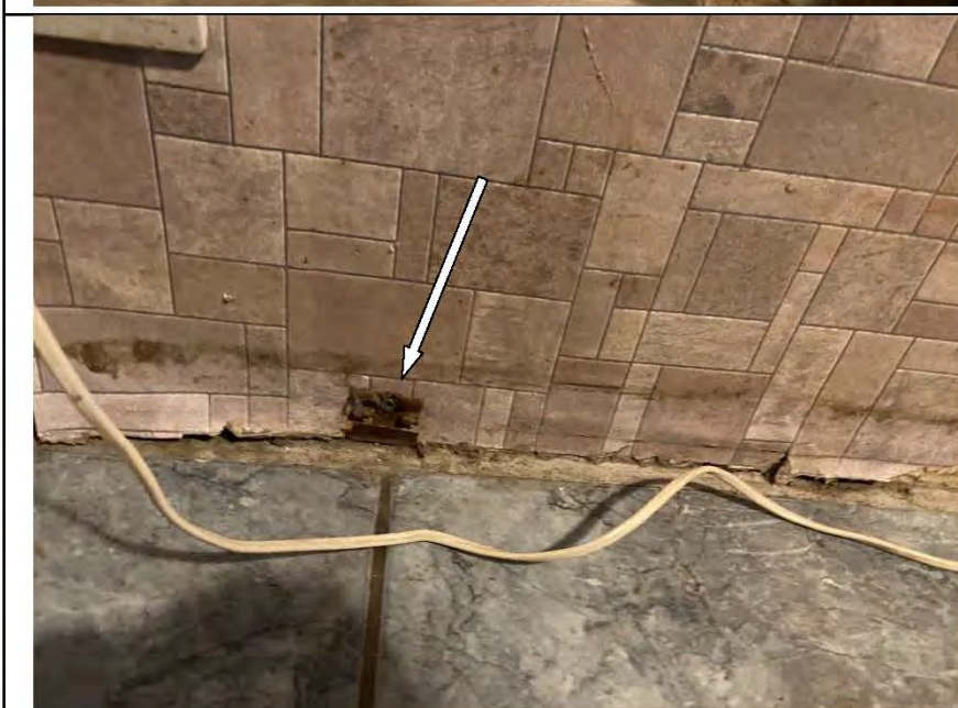
Фото №11. Следы залития на стенах и поражение грибком, оклеенных обоями, в кухне в квартире.
