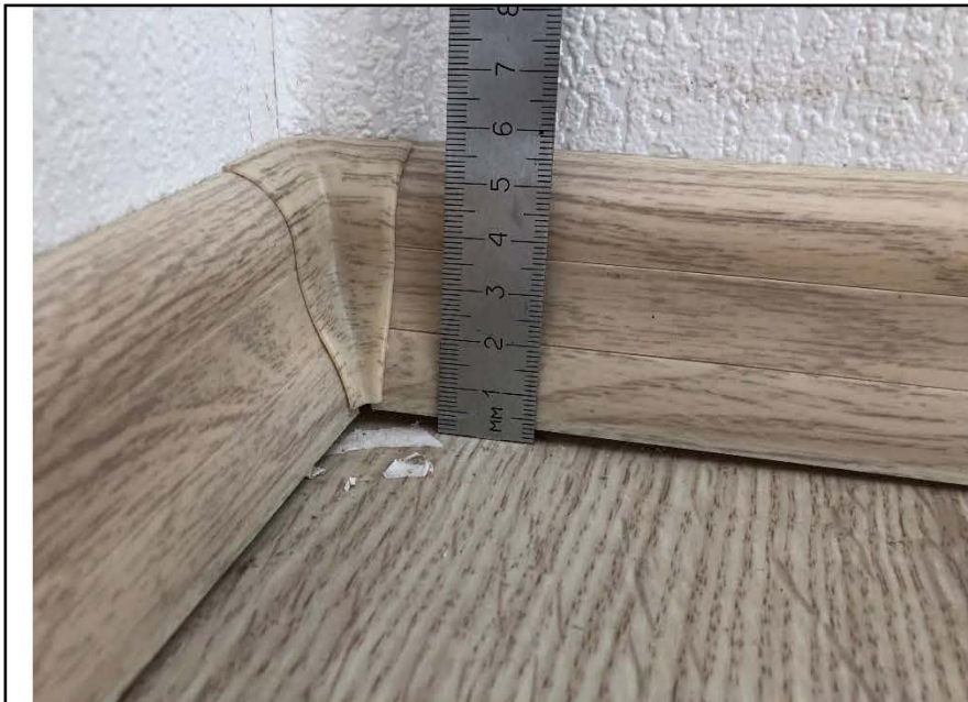
Фото №37. Измерение прогиба ламината в общей комнате.
