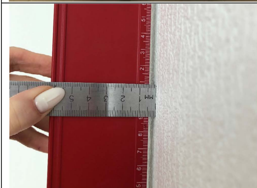
Фото №9. Измерение уровня стен кухни в квартире.
