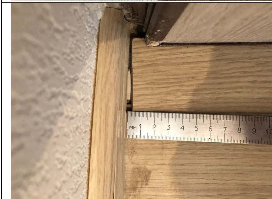
Фото №23. Отсутствует часть ламината в коридоре.
