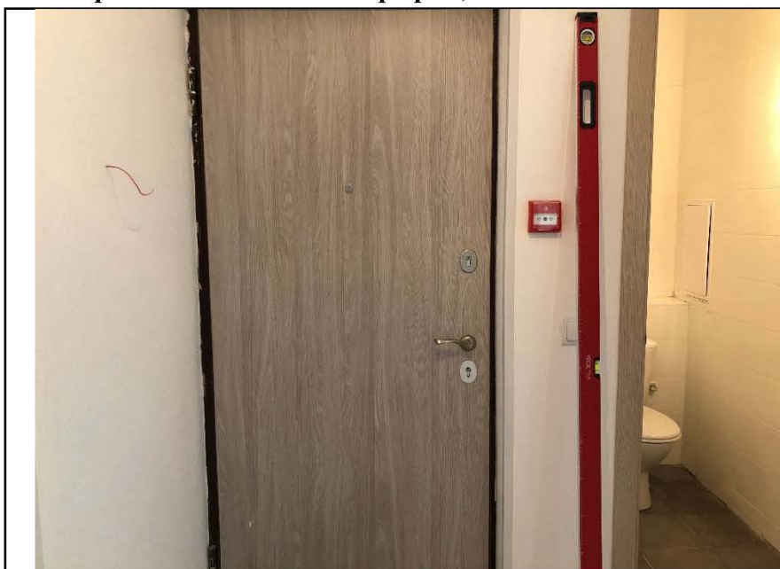
Фото №1. Общий вид коридора в квартире.
