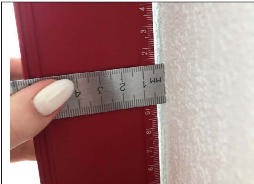
Фото №13. Измерение уровня стен общей комнаты в квартире.
