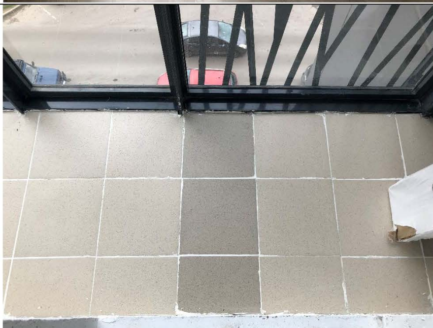
Фото №6. Общий вид напольного покрытия лоджии в квартире.
