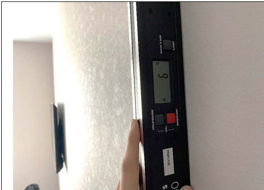
Фото №10. Измерение уровня стен в кухне.
