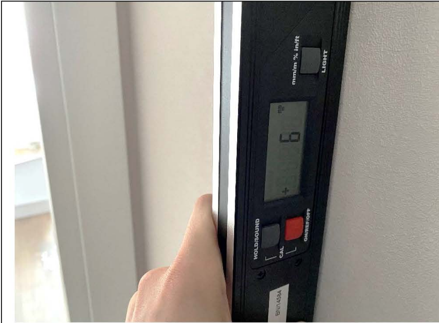
Фото №7. Измерение уровня стен в коридоре.
