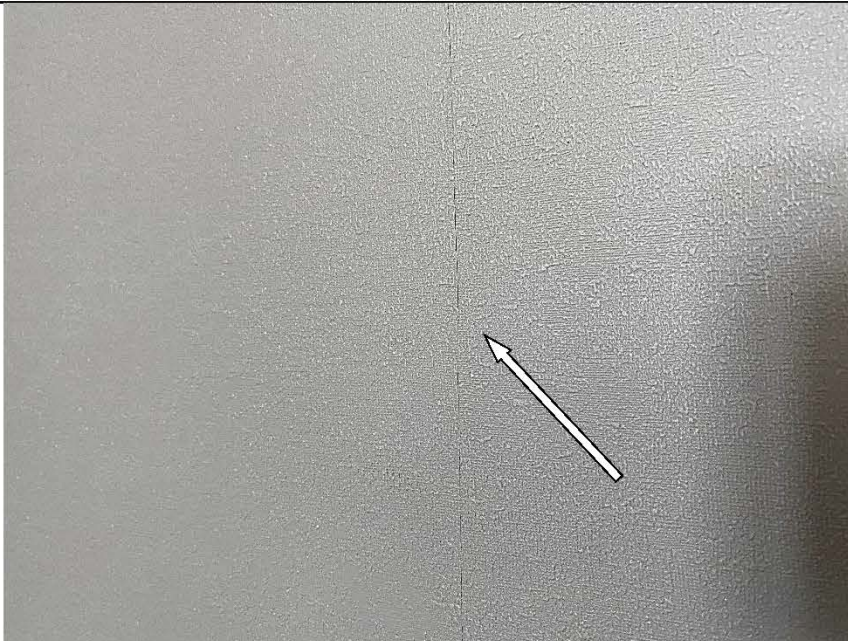
Фото №23. Читаемые обойные стыки в коридоре.
