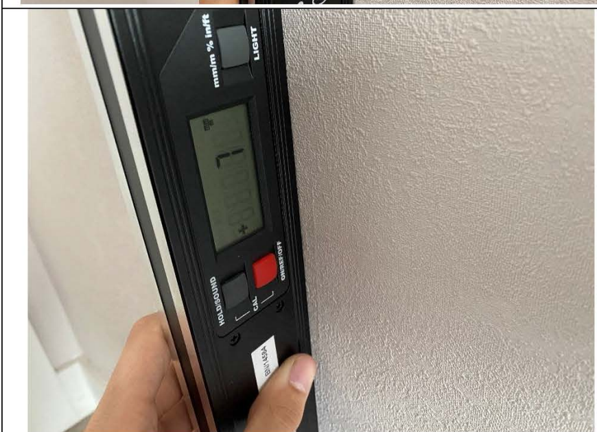
Фото №9. Измерение уровня стен в спальне.
