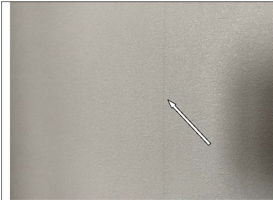
Фото №25. Читаемые обойные стыки в кухне.
