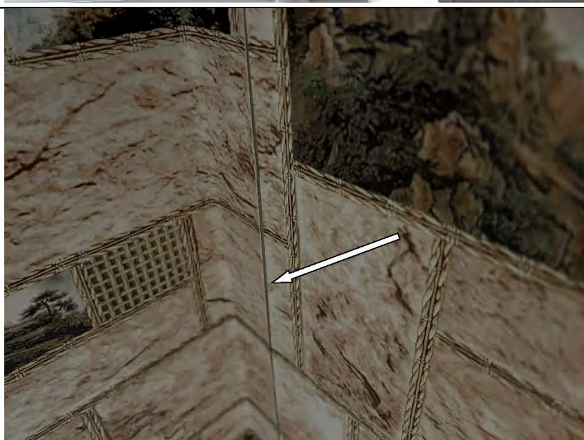
Фото №7. Отслоение обойного полотна в коридоре №2.
