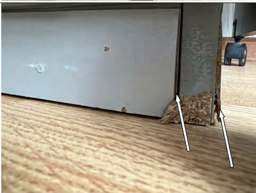
Фото №6. Расслоение нижней конструктивной части и боковой стенки шкафа-стенки в гостиной.
