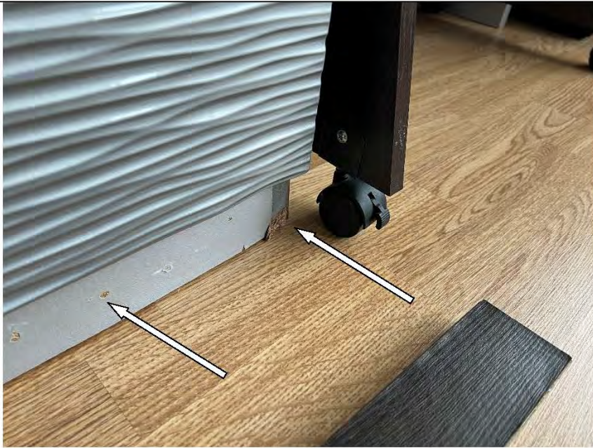
Фото №4. Расслоение нижней конструктивной части и боковой стенки шкафа-стенки в гостиной.
