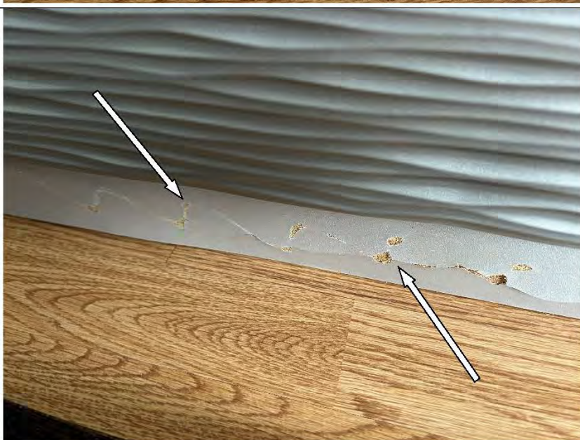
Фото №3. Расслоение нижней конструктивной части шкафа-стенки в гостиной.
