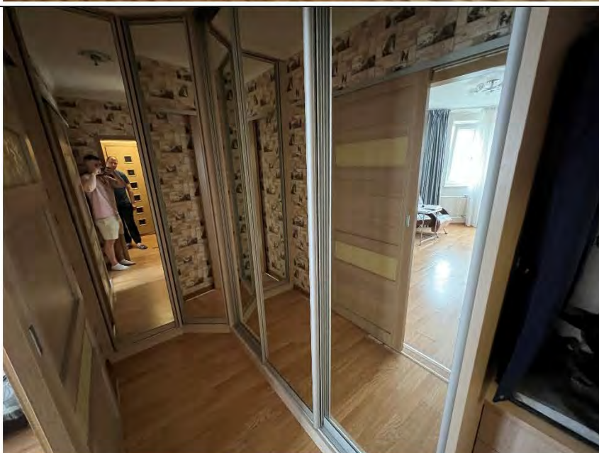
Фото №9. Расслоение нижней конструктивной части и боковой стенки шкафа-купе в гостиной.
