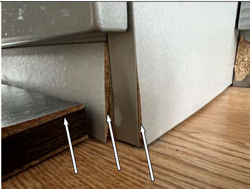
Фото №8. Расслоение нижней конструктивной части и боковой стенки шкафа-стенки в гостиной.
