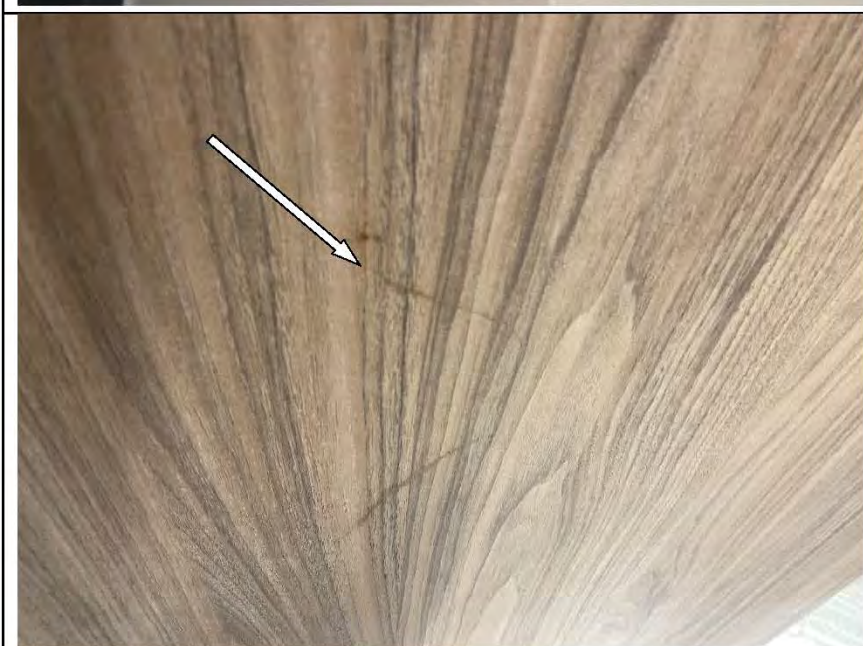
Фото №89. Дефект на полотне входного дверного блока в коридоре.
