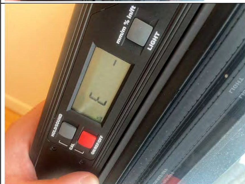
Фото №78. Отклонение от вертикали оконного блока в спальне.
