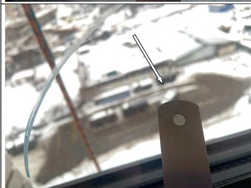
Фото №66. Царапины на стеклопакете оконного блока в кабинете.
