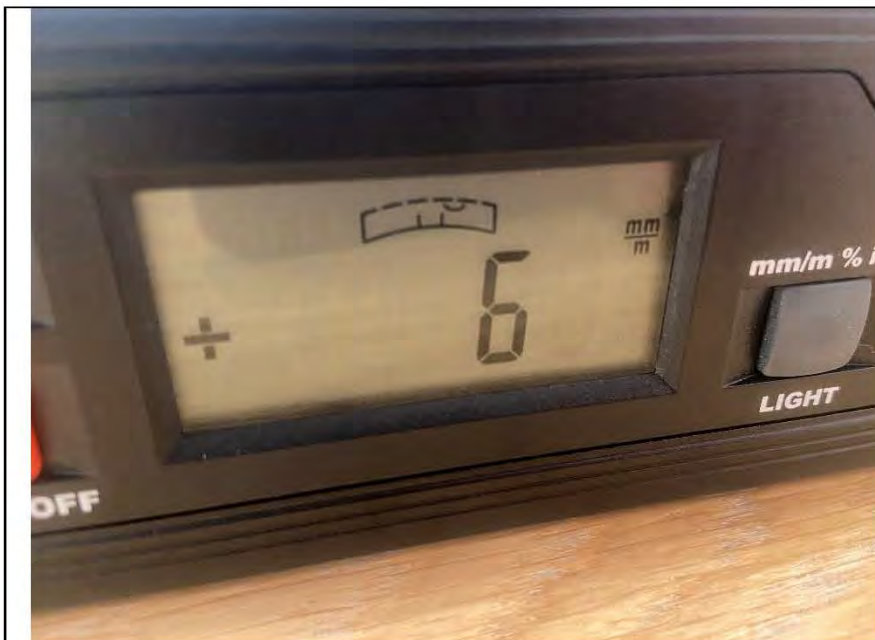
Фото №31. Отклонение поверхности напольного покрытия от плоскости в гостиной.
