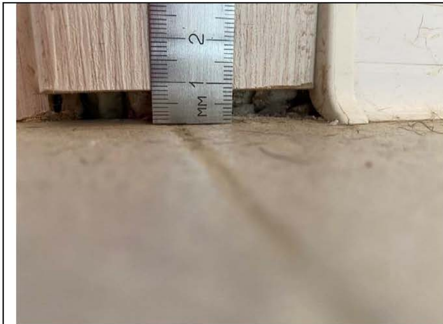
Фото №25. Измерение расстояния между напольным покрытием и наличником в спальне в квартире.
