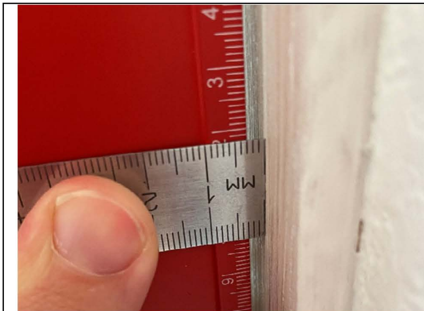
Фото №19. Измерение наличников дверного блока в ванной комнате.
