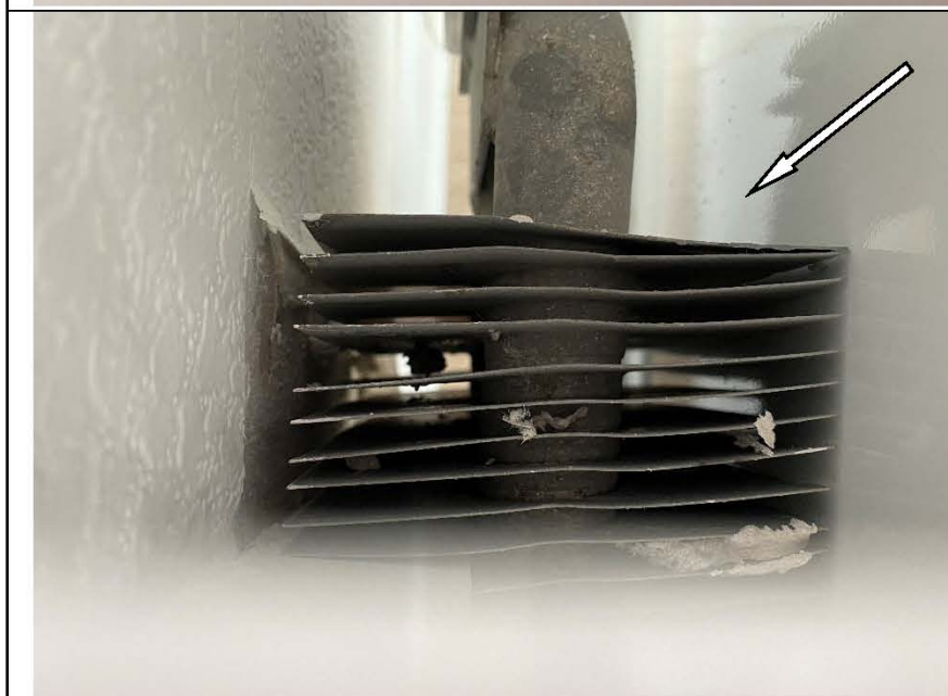
Фото №12. Загрязнение радиатора в детской в квартире.
