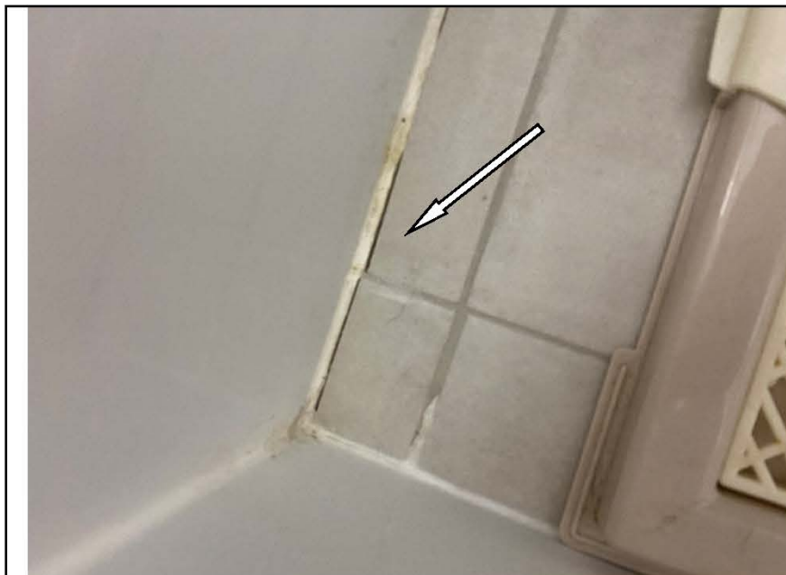
Фото №28. Неполное заполнение шовного пространства затирочным составом напольной плитки в санузле.
