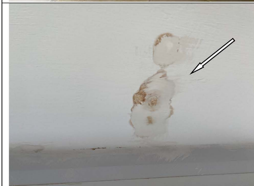
Фото №23. Следы залива окрашенных откосов оконного блока в спальне в квартире.
