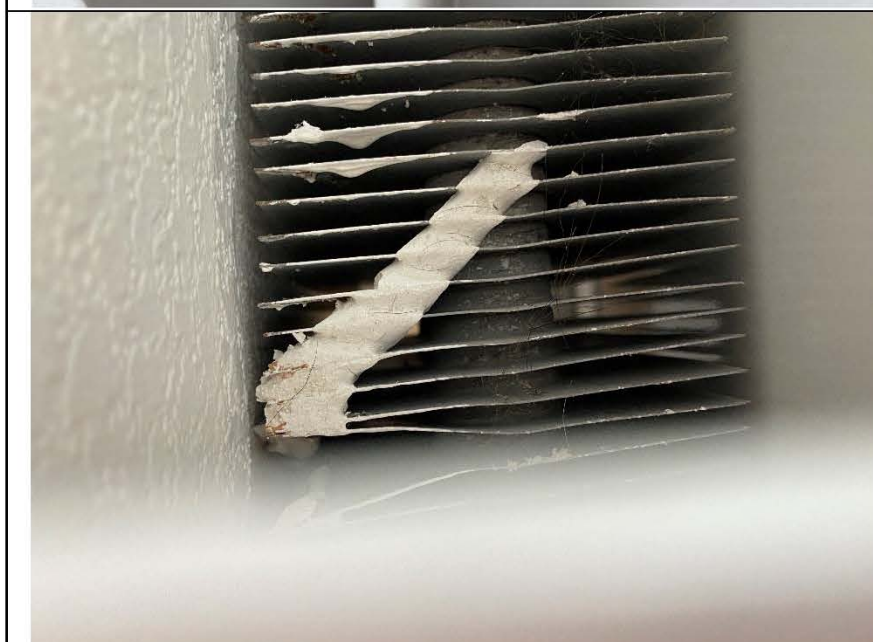
Фото №11. Загрязнение радиатора в кухне в квартире.
