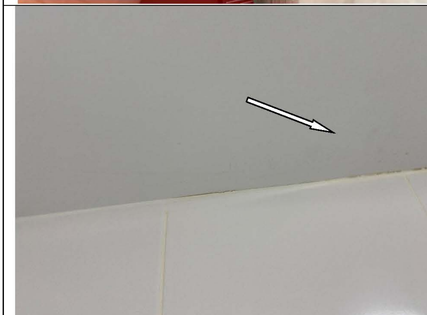
Фото №20. Загрязнения на окрашенном потолке в ванной комнате в квартире.
