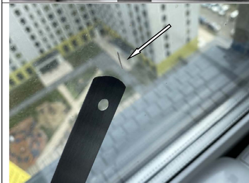
Фото №15. Загрязнение краской на стеклопакете оконного блока ПВХ в спальне в квартире.
