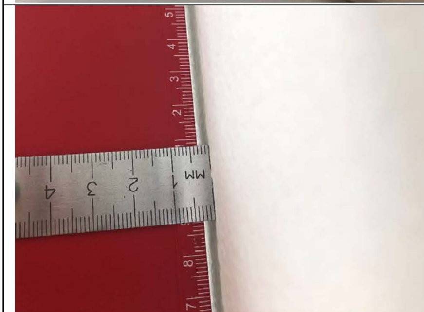
Фото №29. Измерение отклонений стен в спальне.
