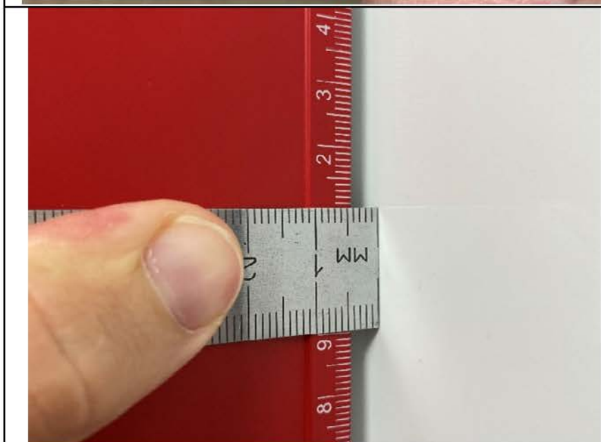
Фото №27. Измерение отклонений стен санузла в квартире.
