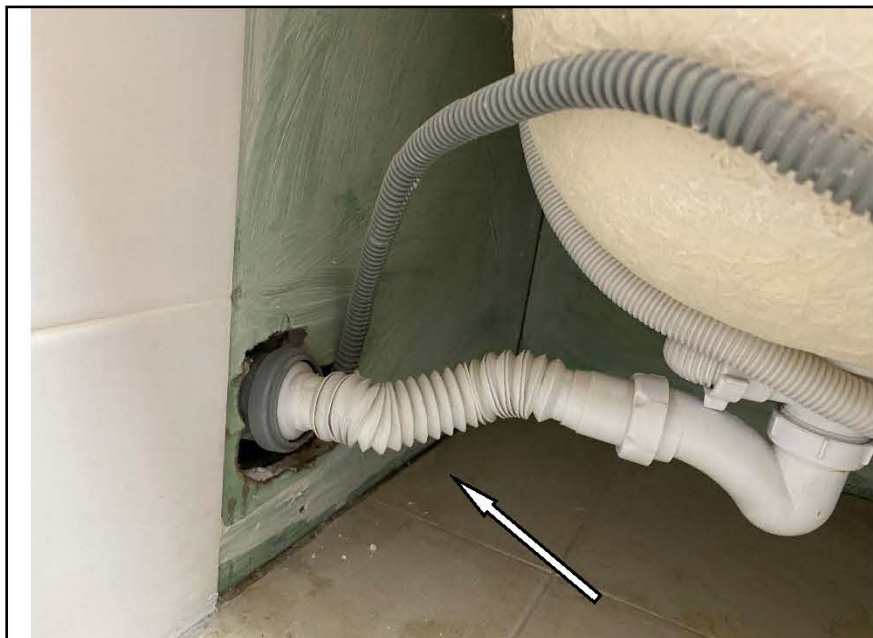
Фото №22. Отсутствует часть настенной керамической плитки в ванной комнате в квартире.
