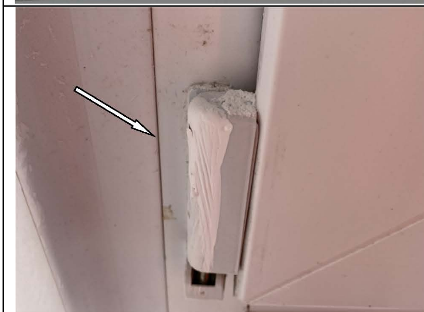
Фото №24. Загрязнения на профиле ПВХ оконного блока в спальне в квартире.
