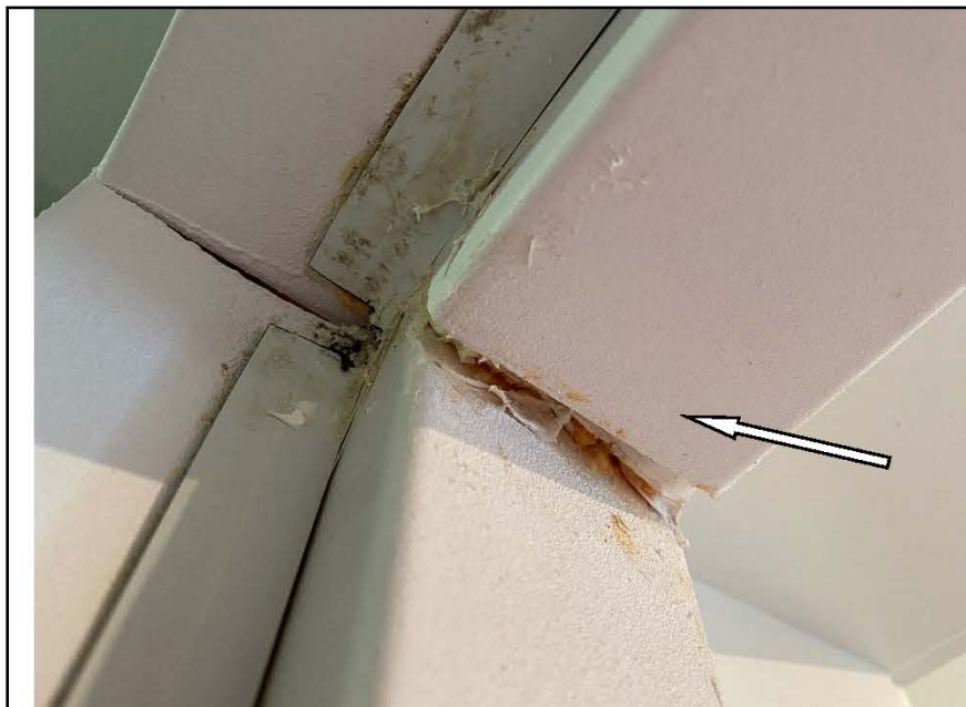
Фото №16. Дефекты на блоке входной металлической двери.
