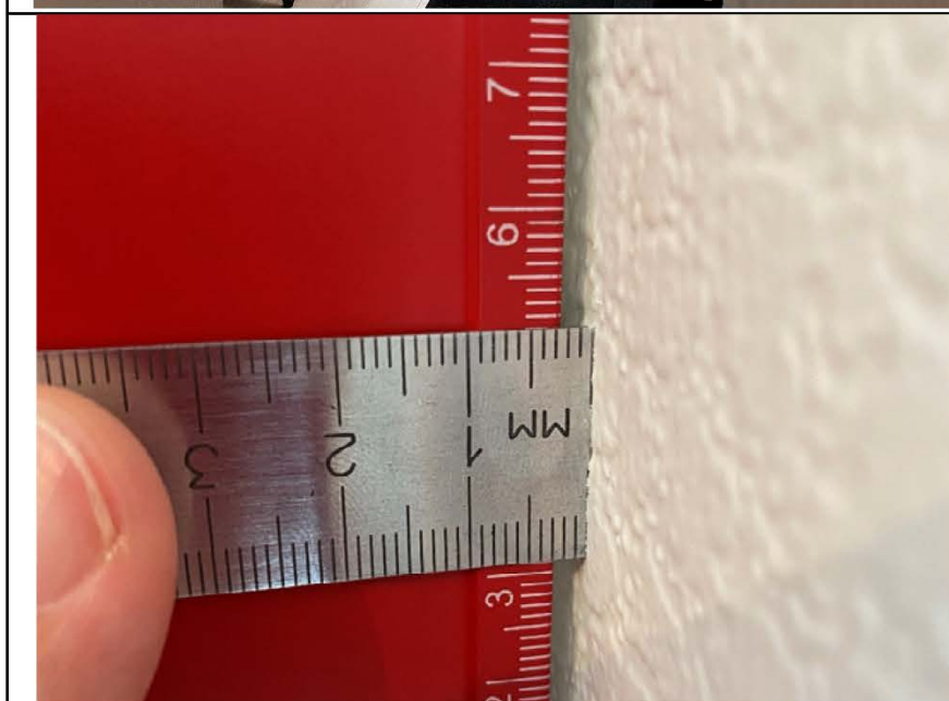
Фото №6. Измерение отклонений стен в коридоре.
