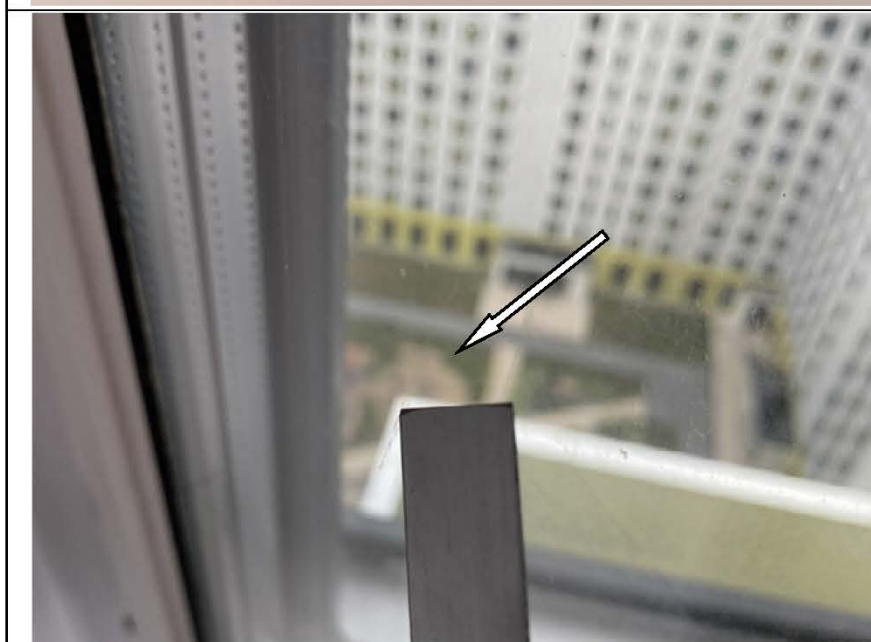
Фото №14. Царапина на стеклопакете оконного блока ПВХ в кухне в квартире.
