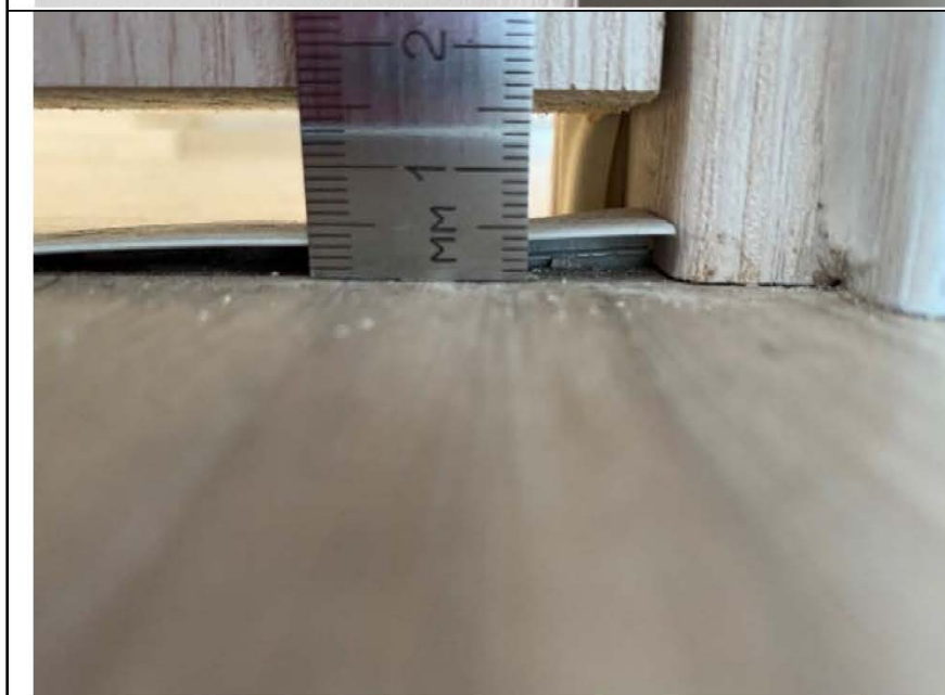
Фото №18. Отсутствует часть металлического порожка на шве напольного покрытия в ванной комнате в квартире.
