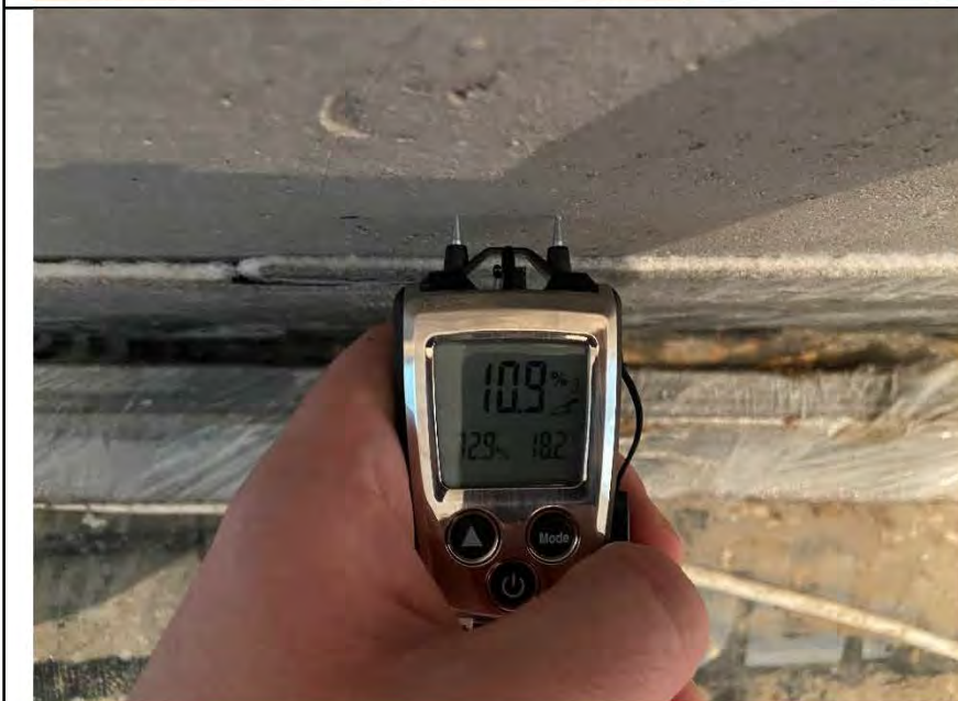
Фото №14. Следы залития на стенах и напольном покрытии в квартире.
