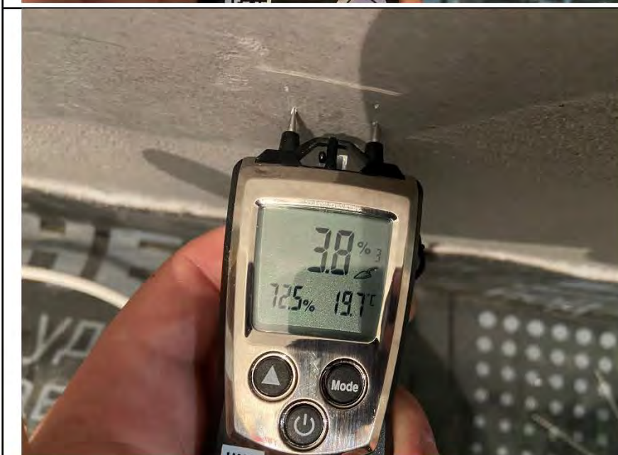
Фото №18. Следы залития на стенах и напольном покрытии в квартире.
