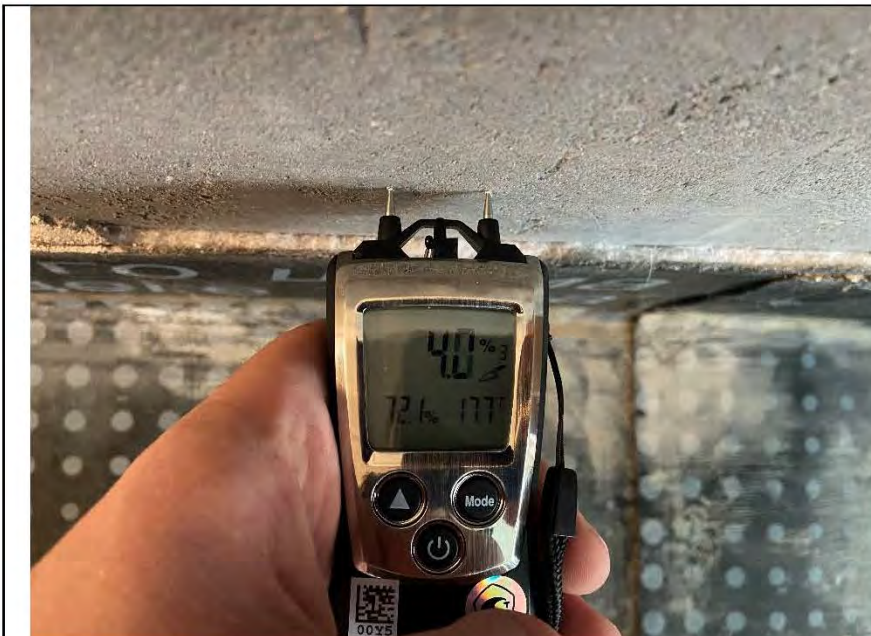
Фото №13. Следы залития на стенах и напольном покрытии в квартире.
