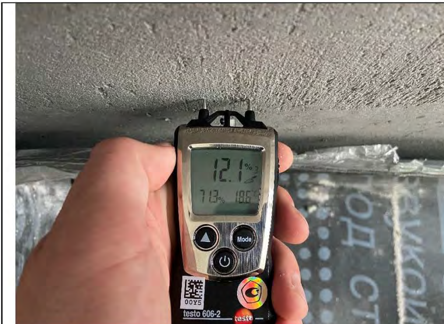
Фото №16. Следы залития на стенах и напольном покрытии в квартире..
