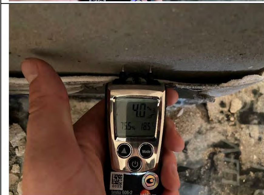
Фото №12. Следы заливки на стенах и напольном покрытии в квартире.
