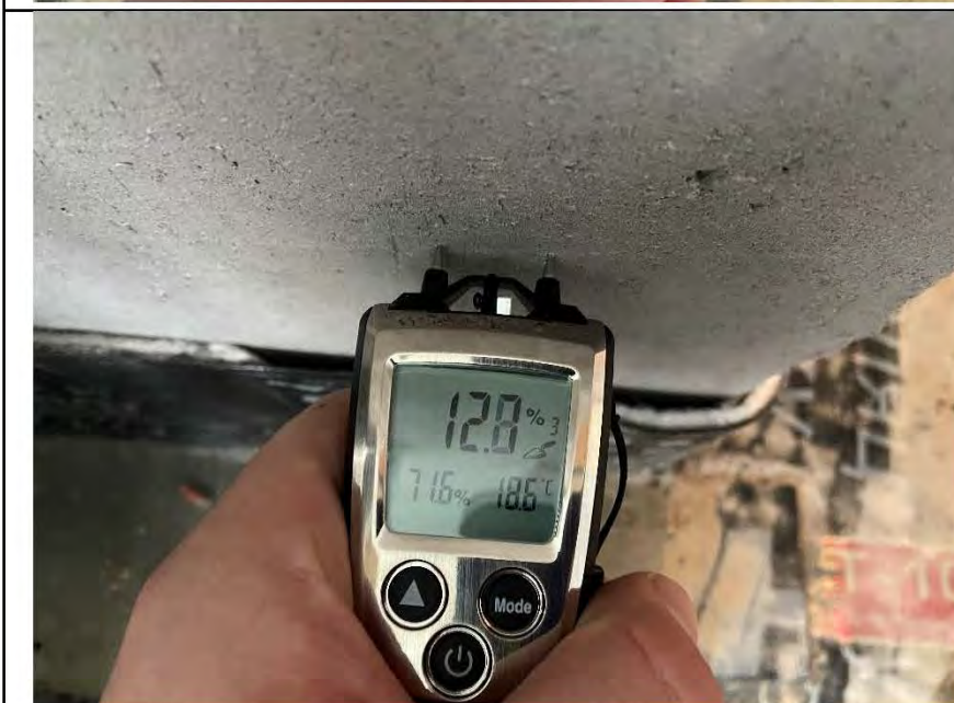
Фото №15. Следы залития на стенах и напольном покрытии в квартире.
