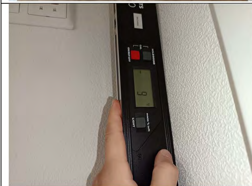
Фото №15. Измерение уровня стен в прихожей.
