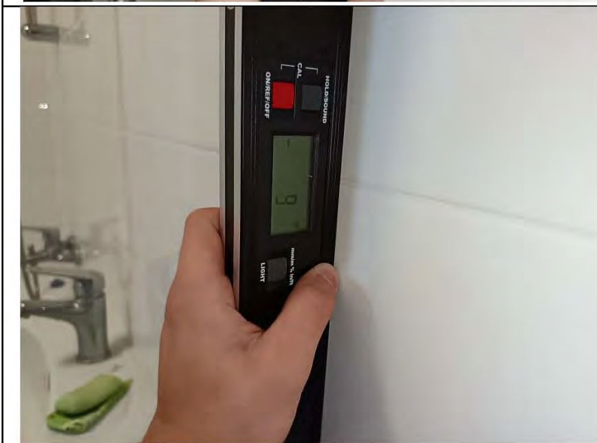
Фото №29. Измерение уровня стен в ванной комнате.
