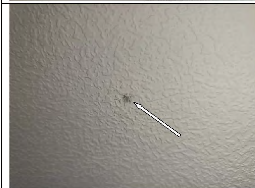
Фото №33. Потертости на обойном полотне в коридоре.
