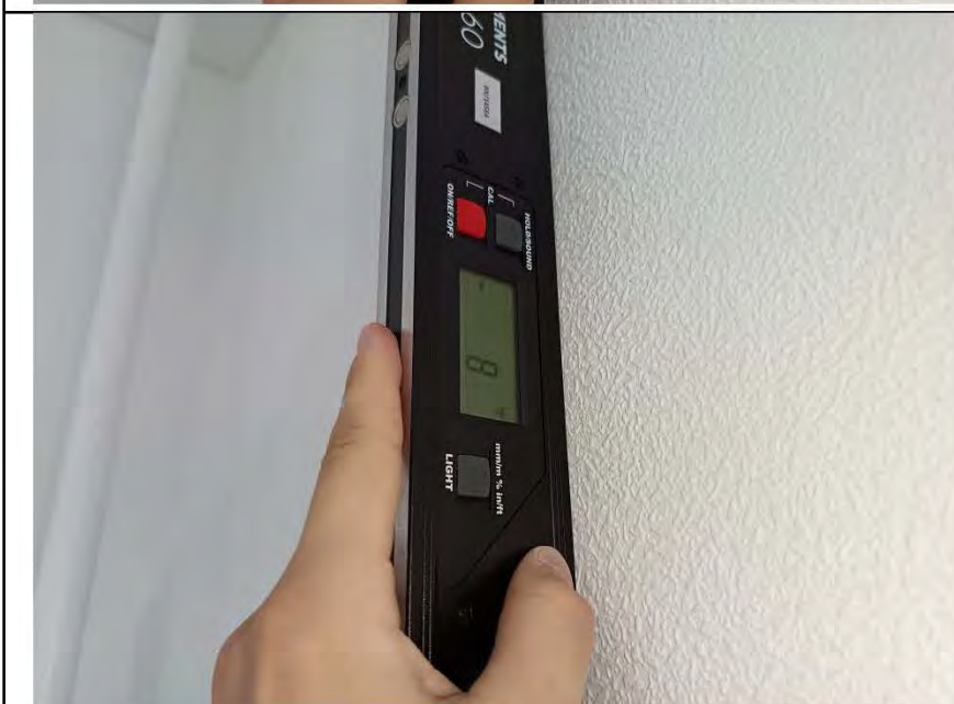
Фото №23. Измерение уровня стен в спальне.
