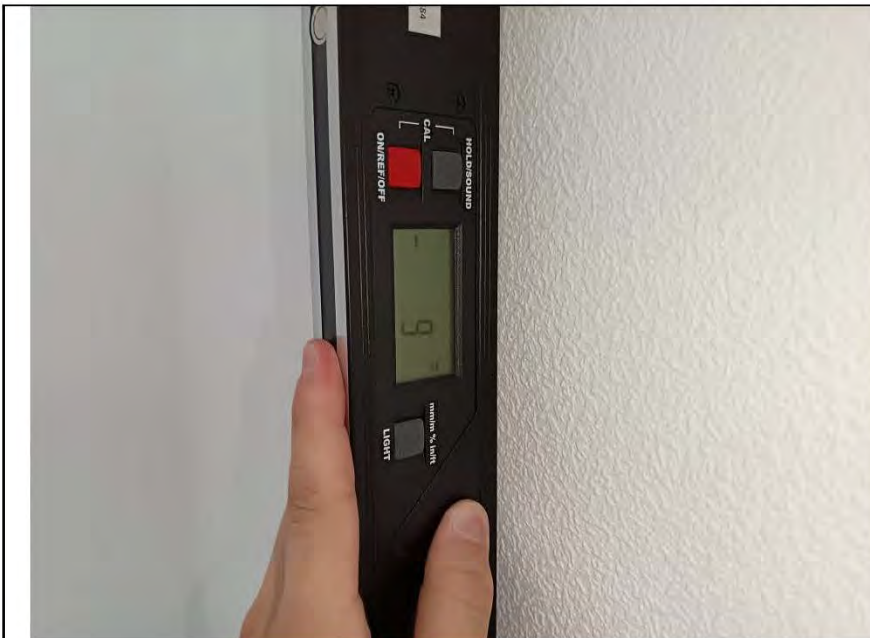
Фото №22. Измерение уровня стен в гостиной.
