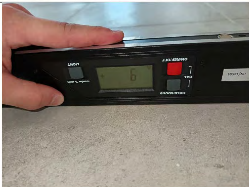
Фото №53. Измерение уровня пола в кухне.
