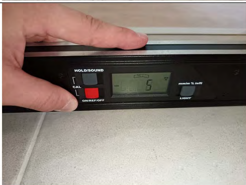
Фото №54. Измерение уровня пола в санузле.
