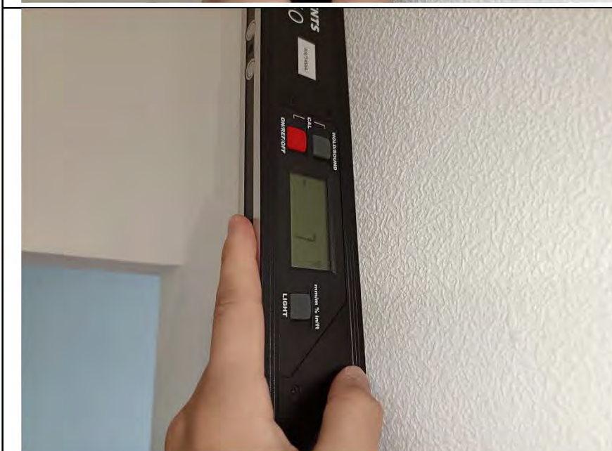
Фото №17. Измерение уровня стен в коридоре.
