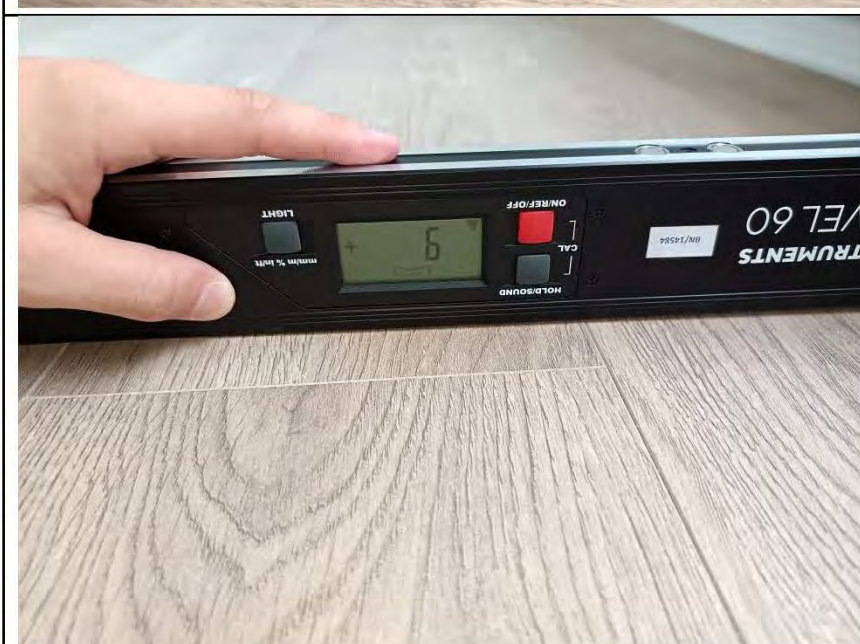
Фото №50. Измерение уровня пола в спальне.
