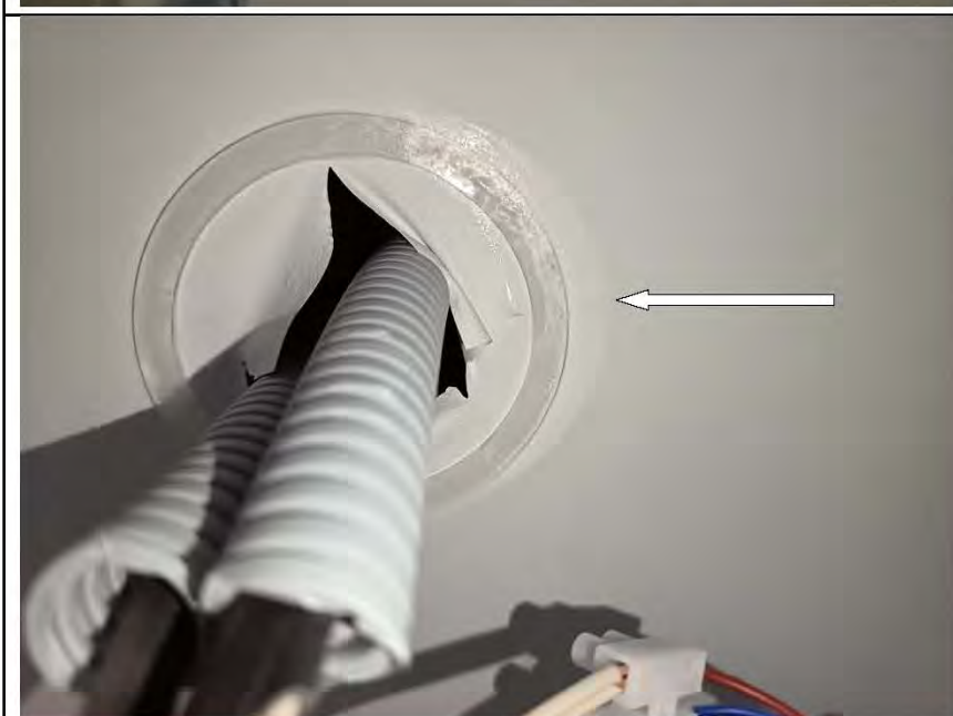
Фото №135. Видимость инженерных сетей на полотне натяжного потолка в коридоре.
