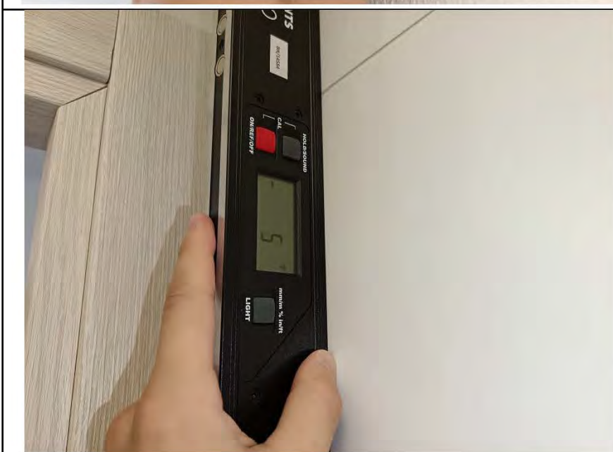
Фото №27. Измерение уровня стен в санузле.
