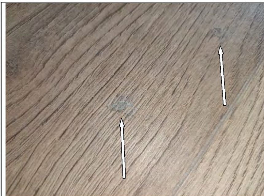
Фото №64. Загрязнение на ламинате в кухне.
