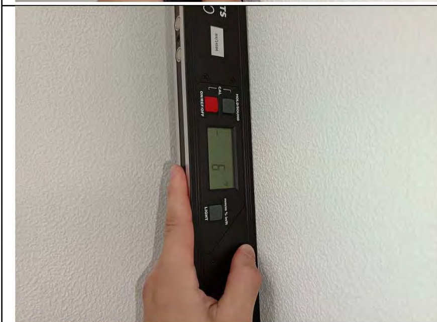
Фото №20. Измерение уровня стен в кухне.
