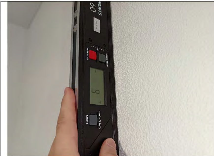
Фото №19. Измерение уровня стен в кухне.
