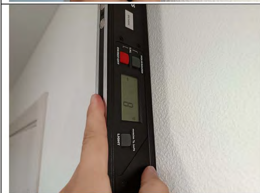
Фото №18. Измерение уровня стен в коридоре.
