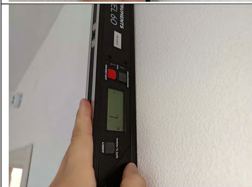
Фото №21. Измерение уровня стен в гостиной.
