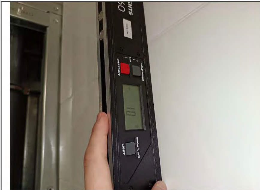
Фото №28. Измерение уровня стен в ванной комнате.
