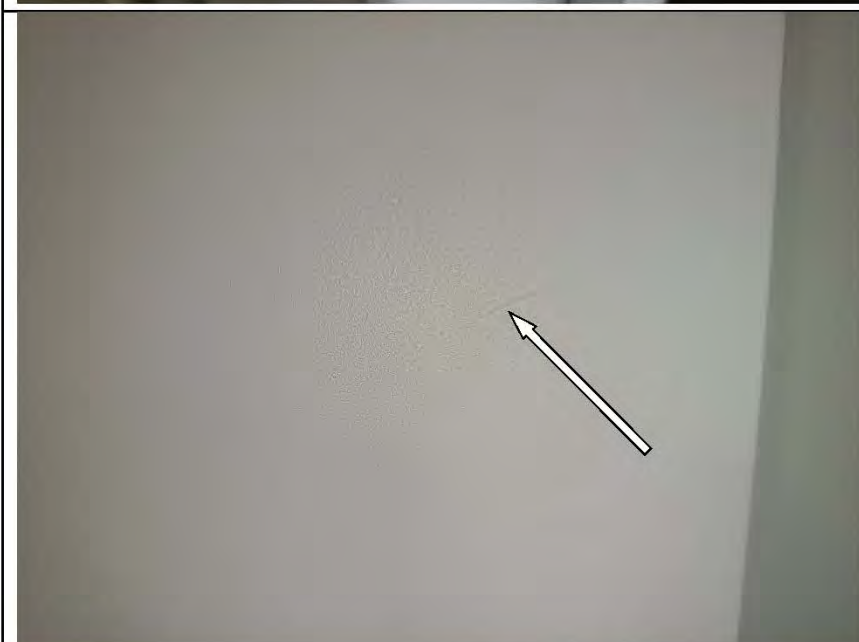
Фото №107. Царапины на полотне входного дверного блока.
