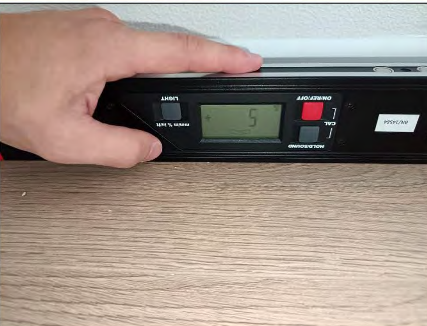
Фото №48. Измерение уровня пола в кухне.
