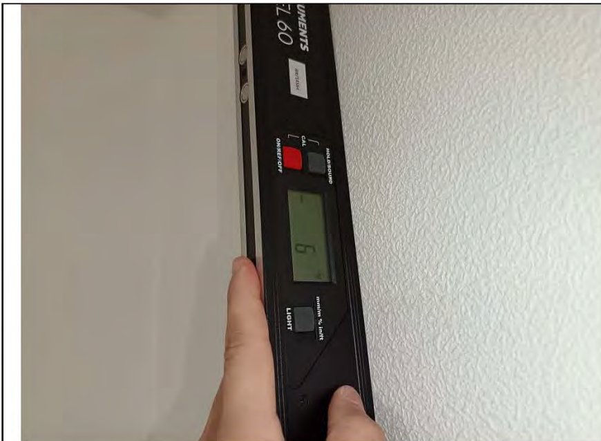
Фото №16. Измерение уровня стен в прихожей.
