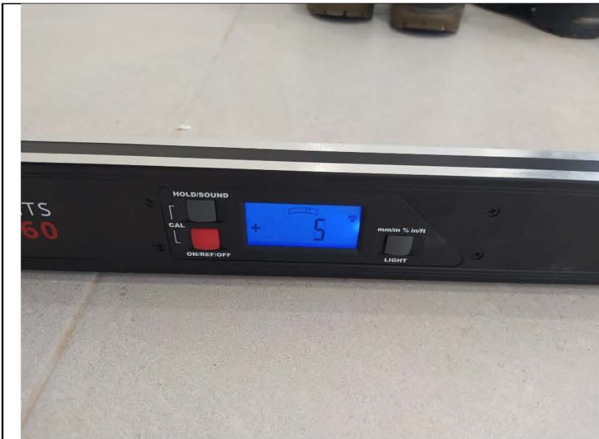
Фото №16. Измерения уровня напольного покрытия в прихожей (керамическая плитка).
