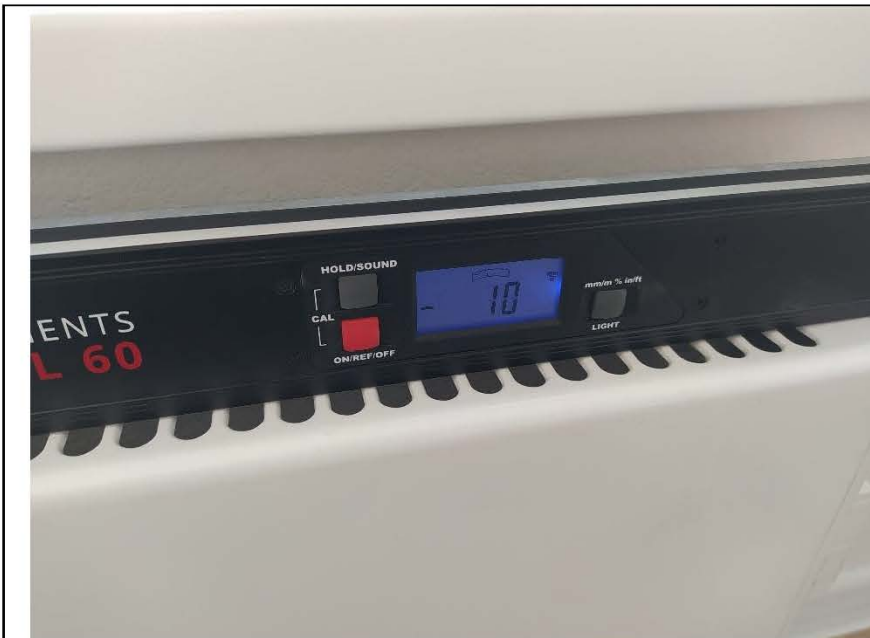
Фото №43. Отопительный прибор смонтирован неровно в гостиной.
