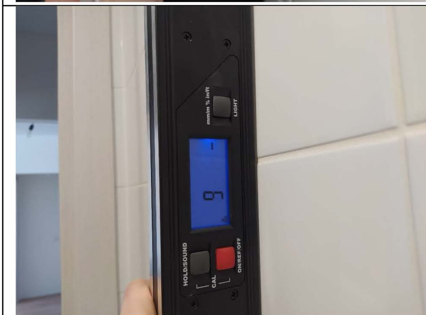
Фото №12. Измерения уровня стен в санузле.
