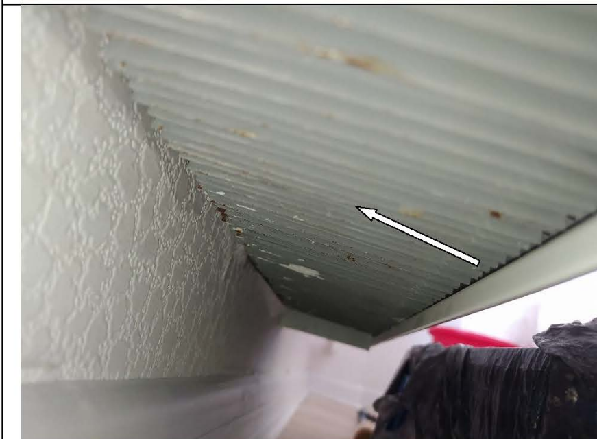
Фото №41. Радиатор в кухне имеет дефекты (коррозия)
