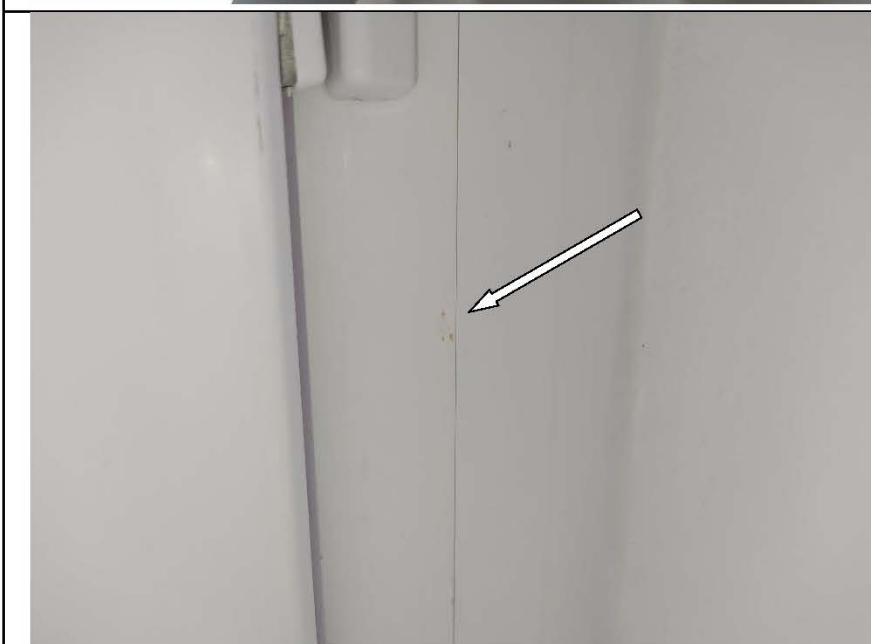
Фото №24. Профиль ПВХ оконного блока в кухне имеет дефекты (загрязнение строительными составами).
