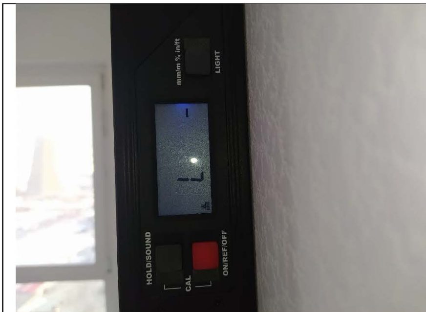
Фото №7. Измерения уровня стен в спальне.
