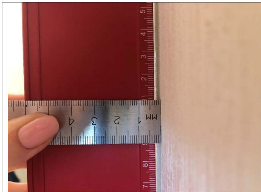
Фото №7. Измерение уровня стен коридора в квартире.
