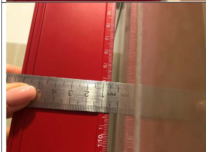
Фото №11. Измерение настенной плитки ванной комнаты в квартире.
