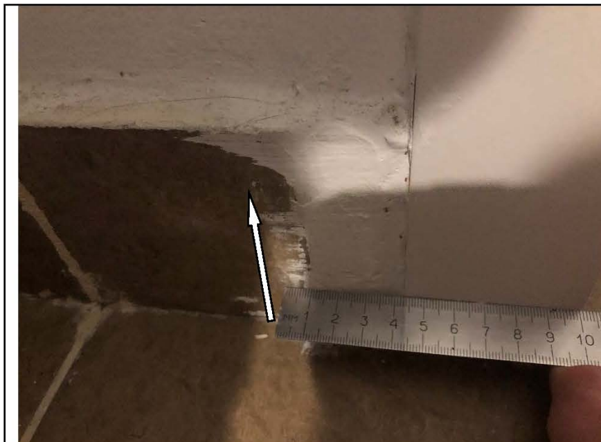
Фото №19. Загрязнение настенной плитки в ванной комнате.
