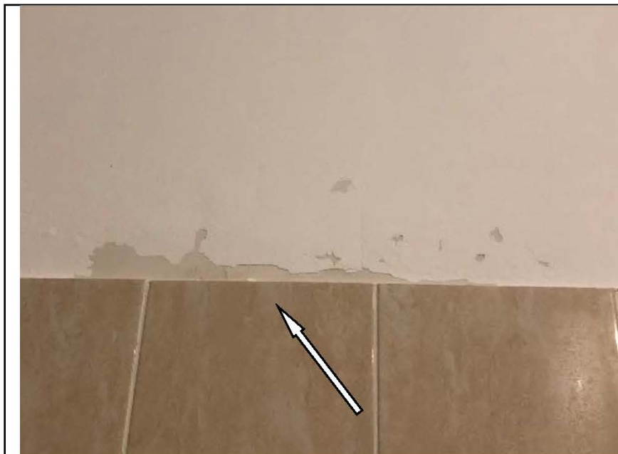
Фото №22. Дефект окрашенной стены в ванной комнате.
