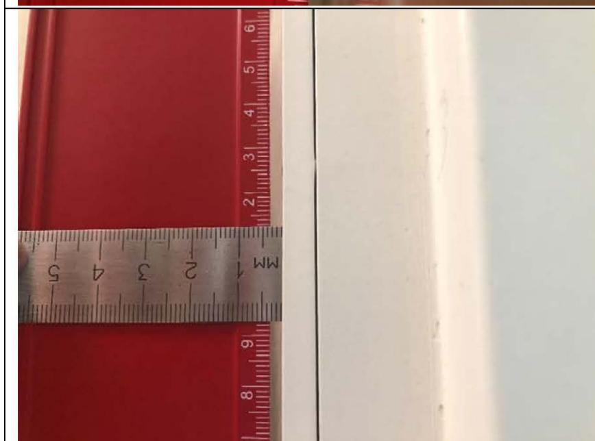
Фото №12. Отклонение дверного наличника в ванной комнате.
