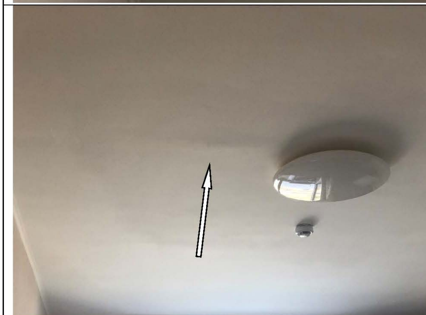
Фото №26. Дефект окрашивания потолка в спальне.
