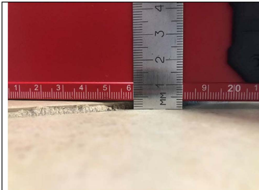
Фото №16. Уступ между плитки в коридоре.
