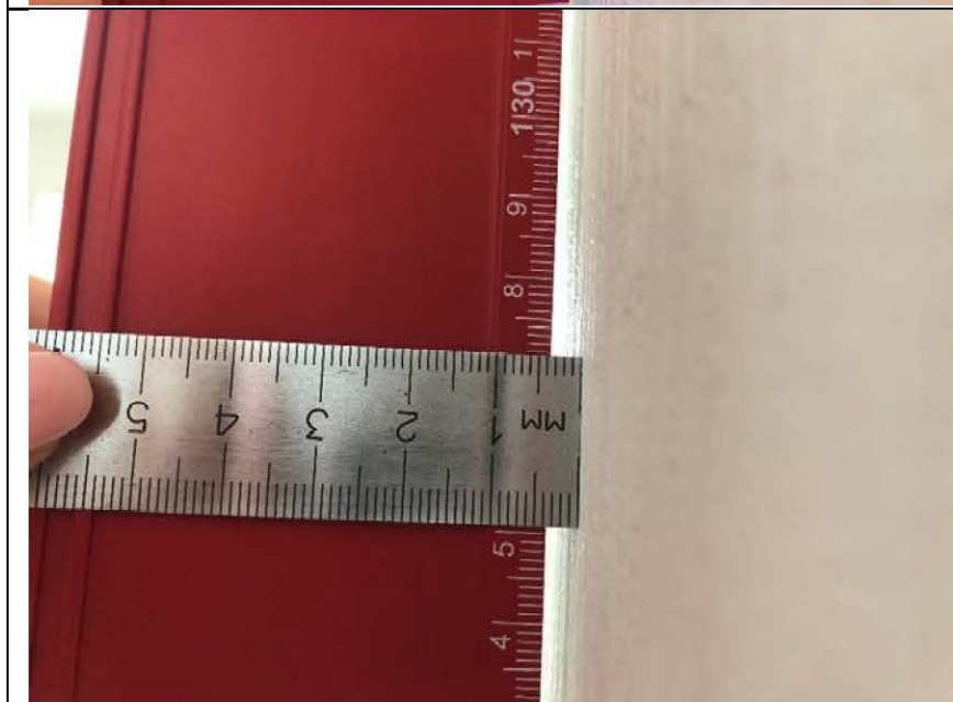
Фото №8. Измерение уровня стен кухни в квартире.
