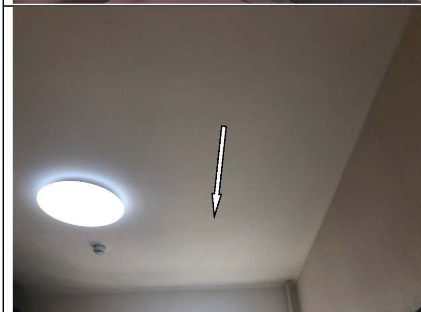
Фото №24. Дефект окрашивания потолка в кухне.
