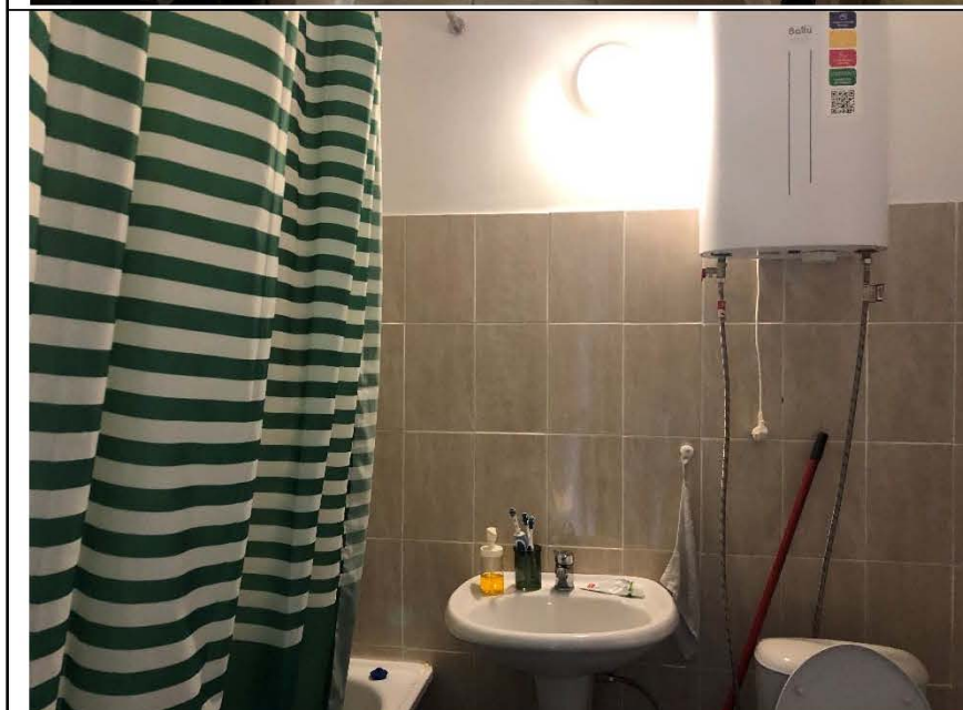
Фото №2. Общий вид ванной комнаты в квартире.
