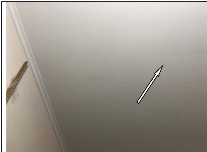
Фото №25. Дефект окрашивания потолка в коридоре.
