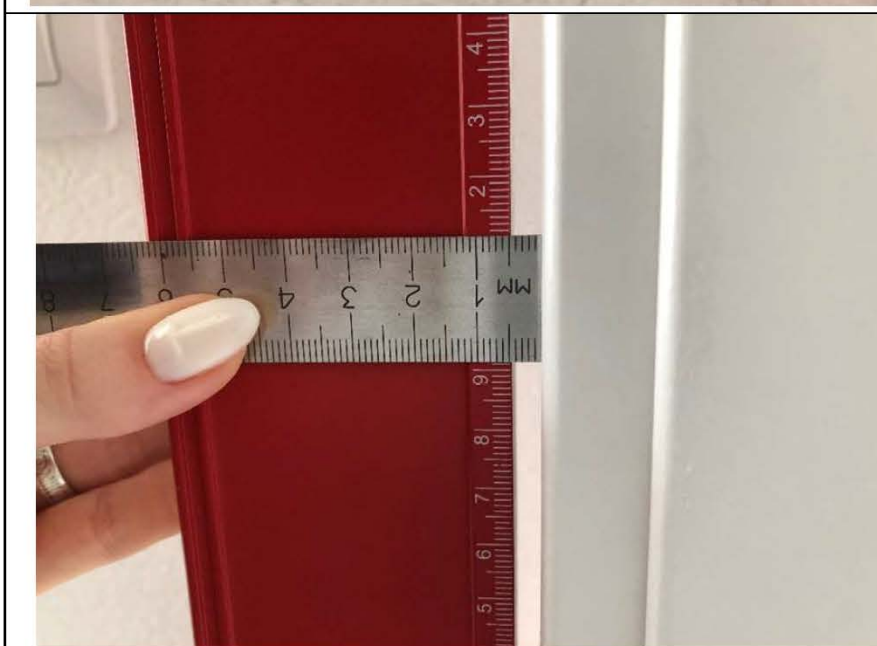
Фото №12. Измерение отклонения входного дверного наличника в квартире.
