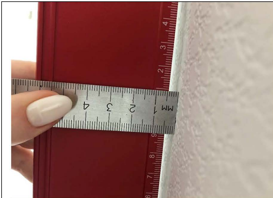
Фото №7. Измерение уровня стен коридора в квартире.
