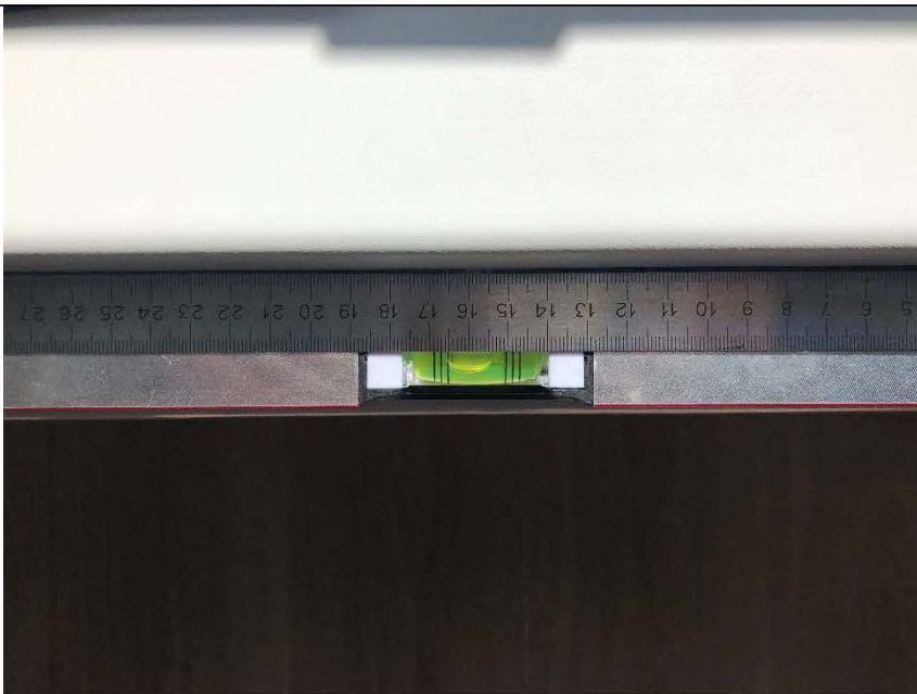
Фото №18. Неровно смонтированный отопительный прибор в комнате.
