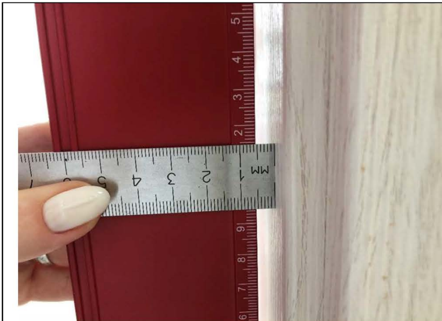
Фото №13. Измерение отклонения дверного наличника в санузле в квартире.
