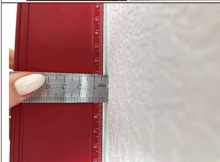
Фото №8. Измерение уровня стен комнаты в квартире.
