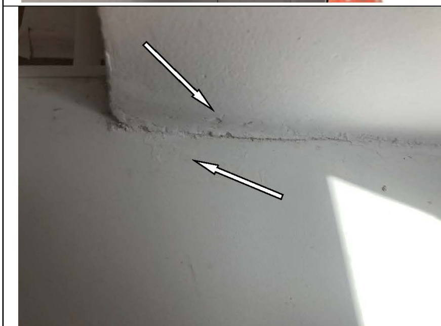
Фото №23. Подоконная доска оконного блока загрязнена. Дефект откоса.
