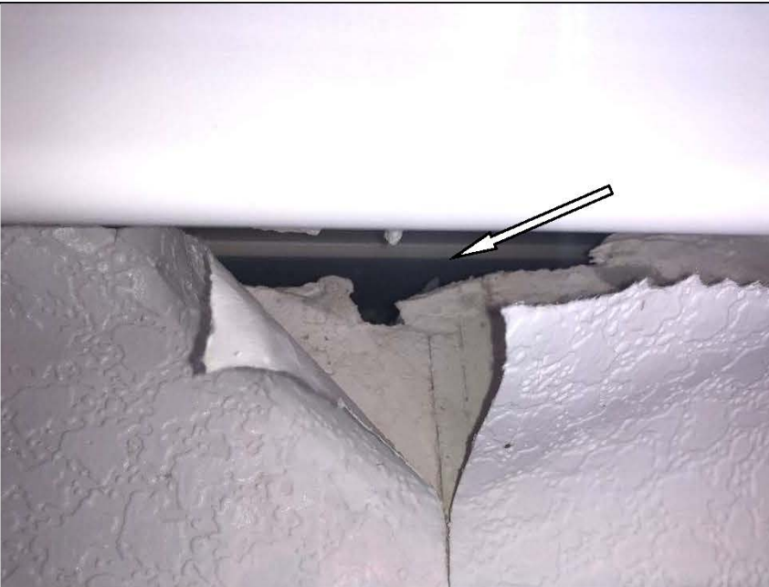
Фото №26. Отверстие под подоконником.
