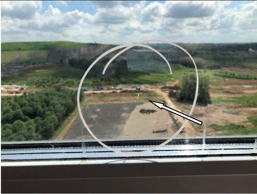
Фото №16. Царапины на стеклопакете оконного блока в комнате.
