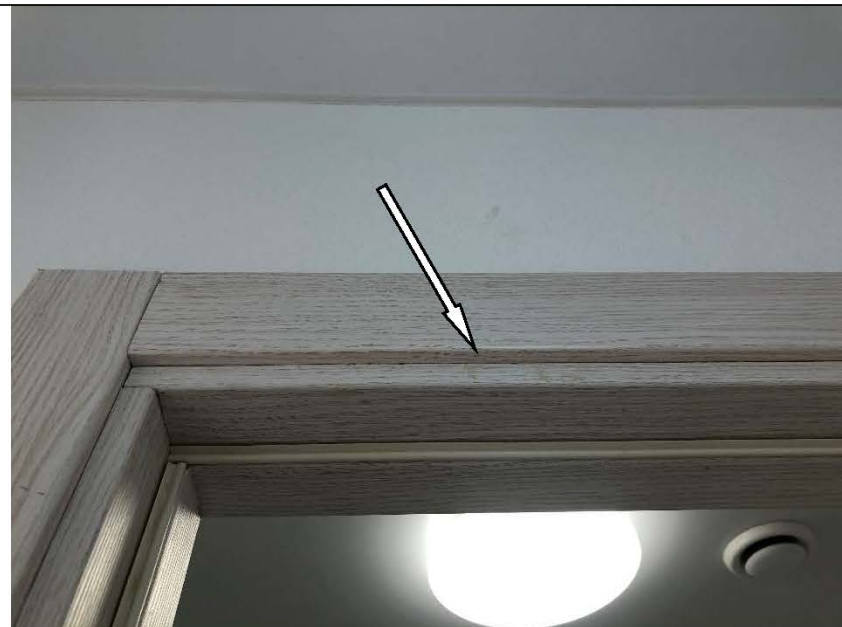
Фото №27. Загрязненный наличник дверного деревянного блока в санузле.
