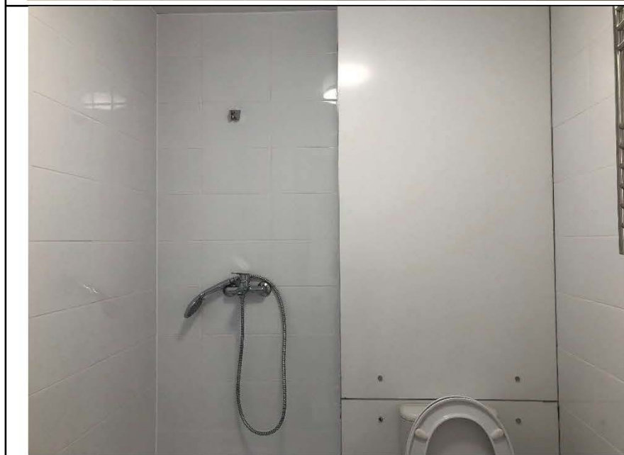
Фото №3. Общий вид санузла в квартире.
