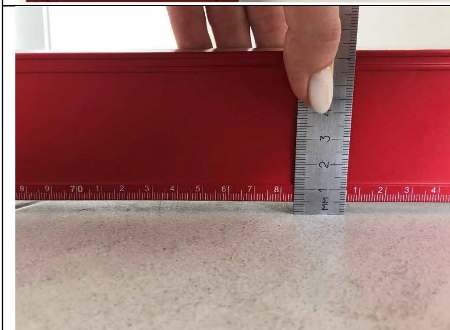
Фото №11. Измерение напольного покрытия коридора в квартире. Керамическая плитка.
