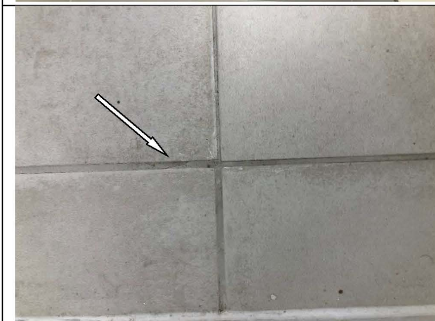
Фото №29. Дефект шва напольной керамической плитки.
