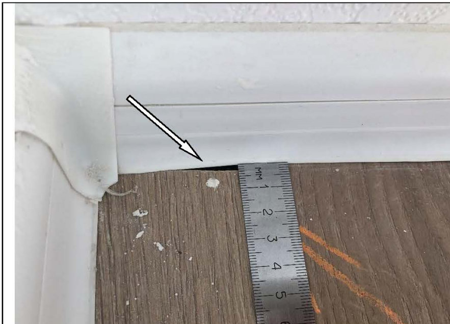
Фото №19. Дефект ламината в комнате.
