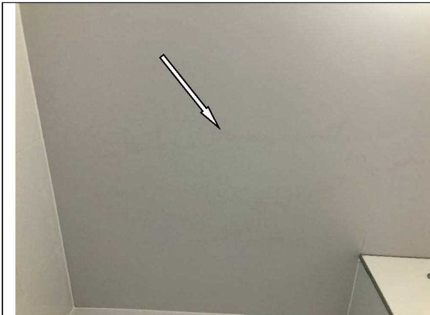
Фото №28. Дефект натяжного потолка в санузле.
