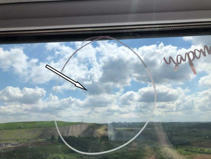
Фото №17. Царапины на стеклопакете оконного блока в комнате.
