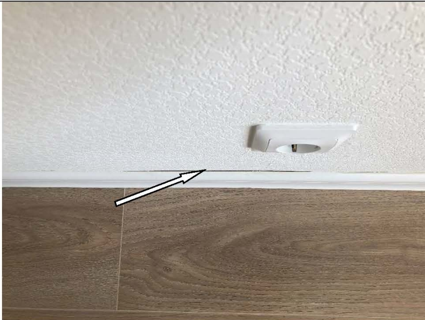
Фото №25. Дефект прилегания напольного плинтуса в комнате.
