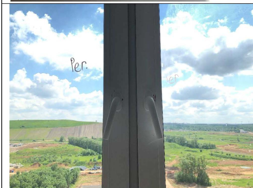
Фото №24. Регулировка фурнитуры оконного блока в комнате.
